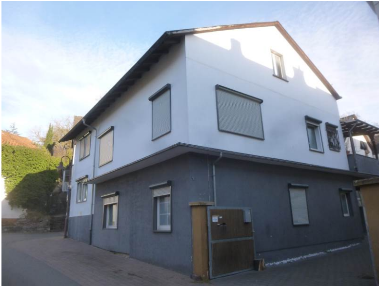
Bild 1: Ansicht von Südwesten:
