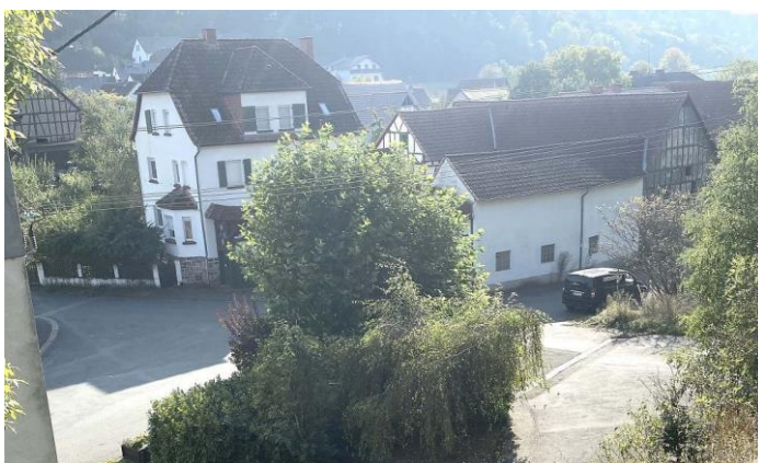
Nordwestansicht auf das Gesamtgrundstück
