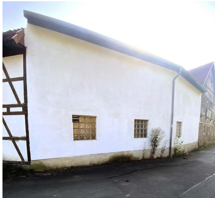
Ansicht aus Nordosten: Nebengebäude 1
