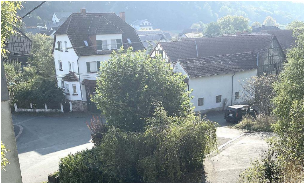
Blick von Nordwesten auf das Gesamtgrundstück
