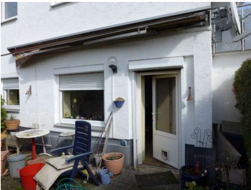
10 vor dem Bewertungsobjekt liegende Terrasse, gesonderter Eingang zur Wohnung Nr. I
