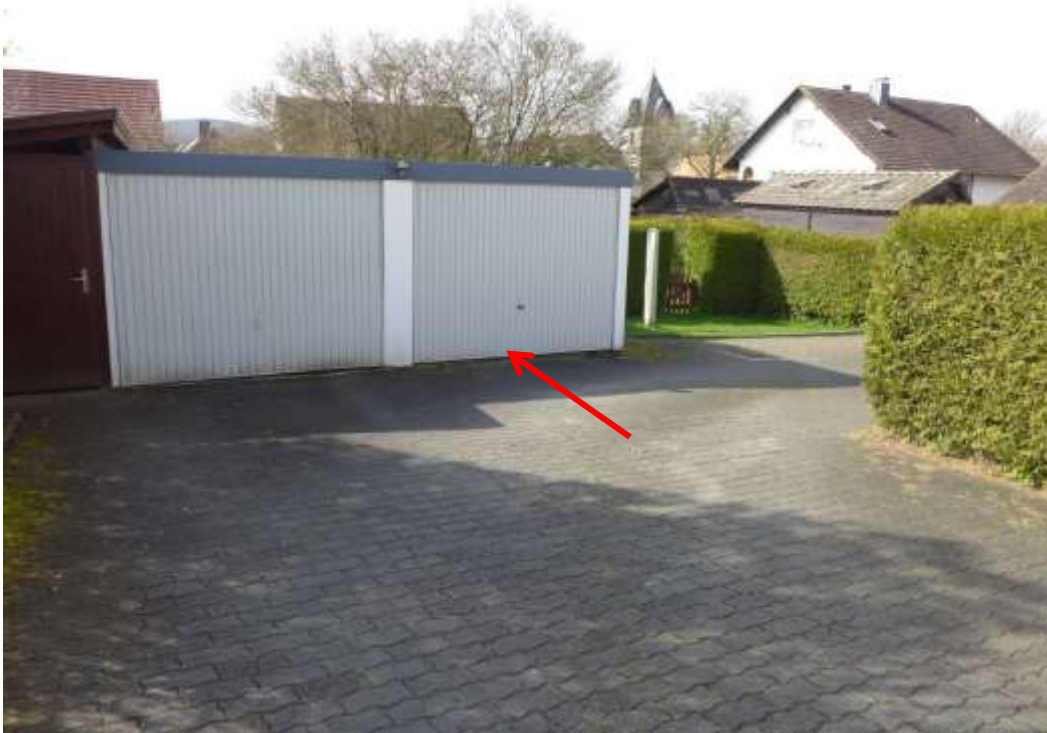
7 Fertiggaragen, Bewertungsobjekt links markiert
