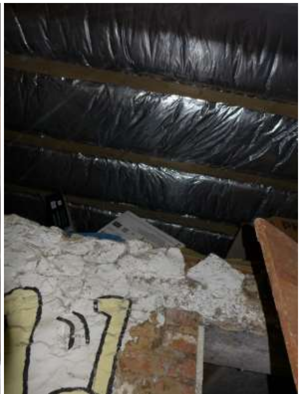
14 b Dämmung Remisendach
