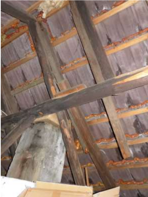
13 a Dacheindeckung mit Montageschaum
