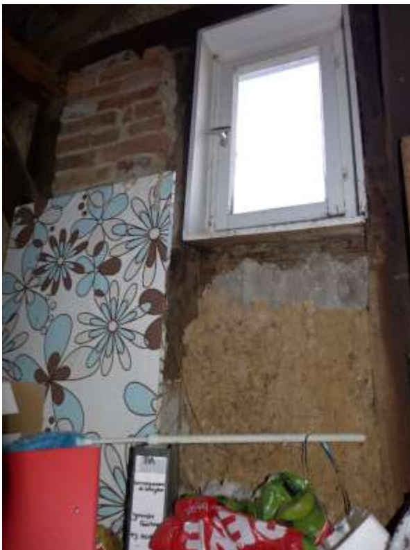
14 a Giebelwand Dachboden
