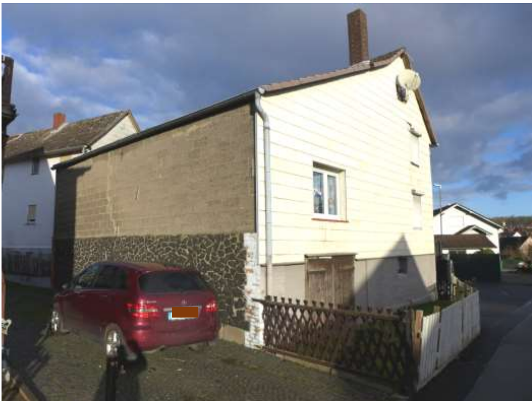
6 Rückansicht Remise (Südansicht)
