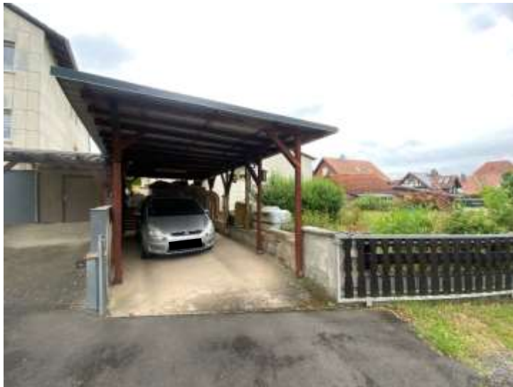
Bild 10: Carport mit Zufahrt
