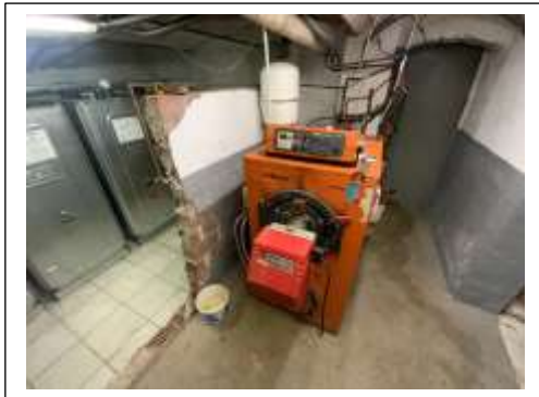
Abb.: Ölzentralheizung KG
