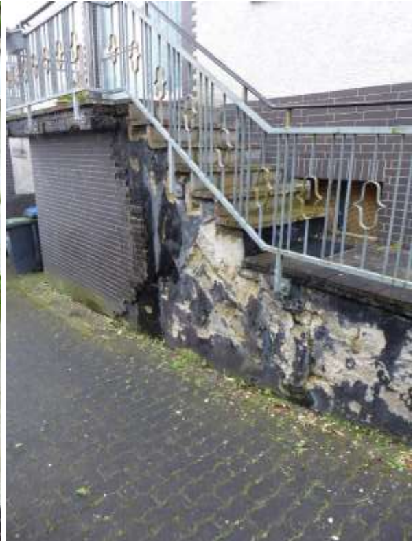
33 b Schäden Zugangstreppe
