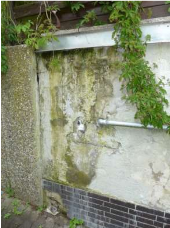
33 a Fassadenschäden (Terrassenunterkell.)
