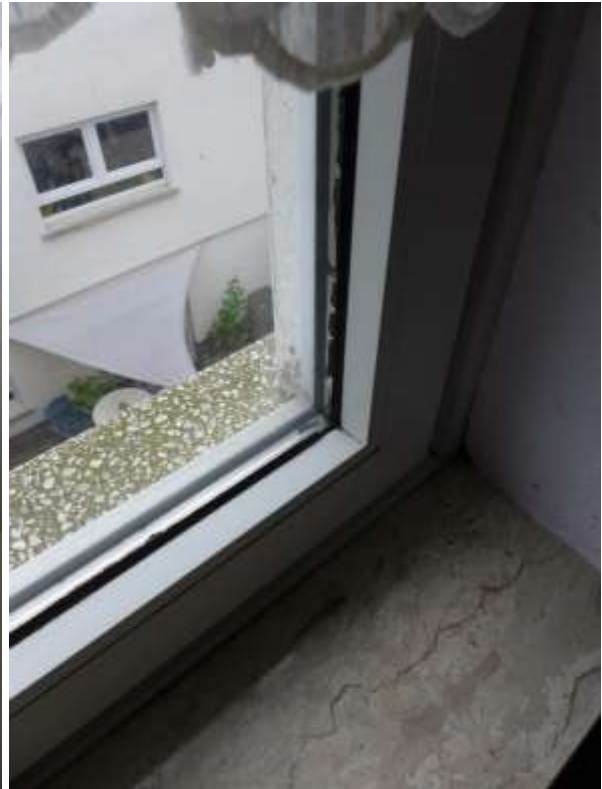
23 b Zustand Fenster DG (Gummi)
