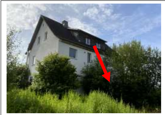
Abb.: Zugang Kellergeschoss (nicht einsehbar)
