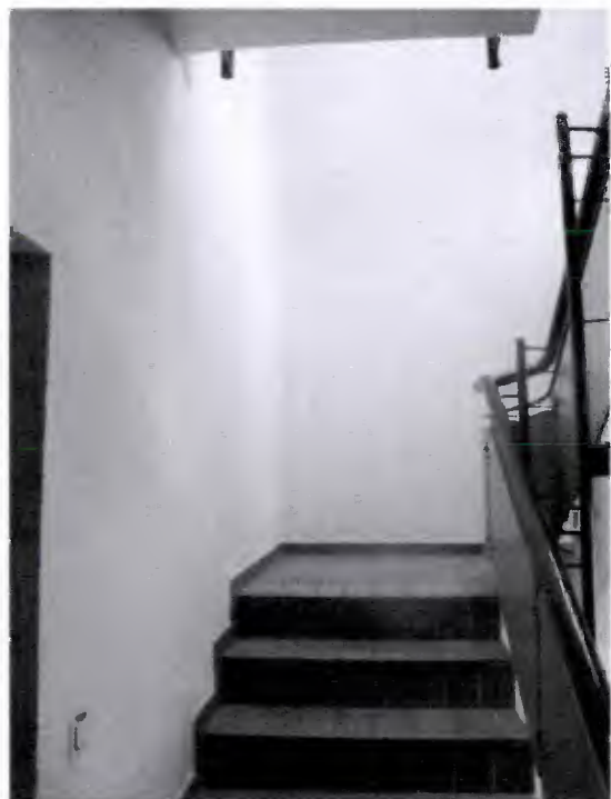
Treppe zum Dachgeschoss
