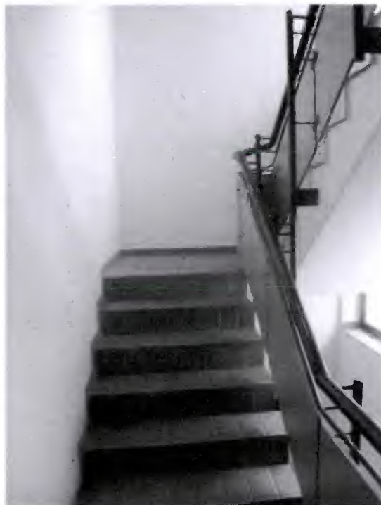
Treppe zum 3. Obergeschoss
