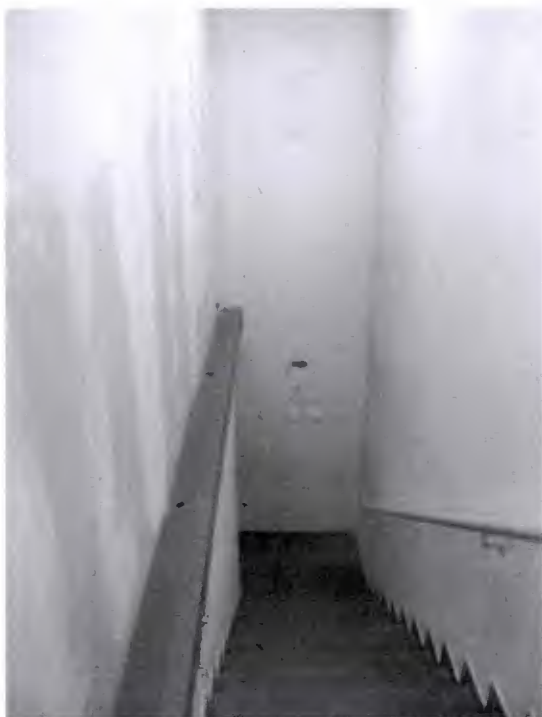
Treppe zum Kellergeschoss
