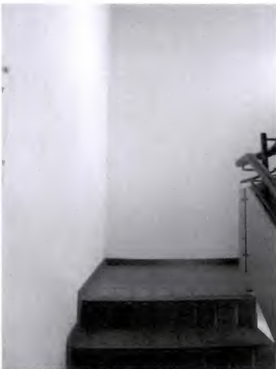
Treppe zum 4. Obergeschoss
