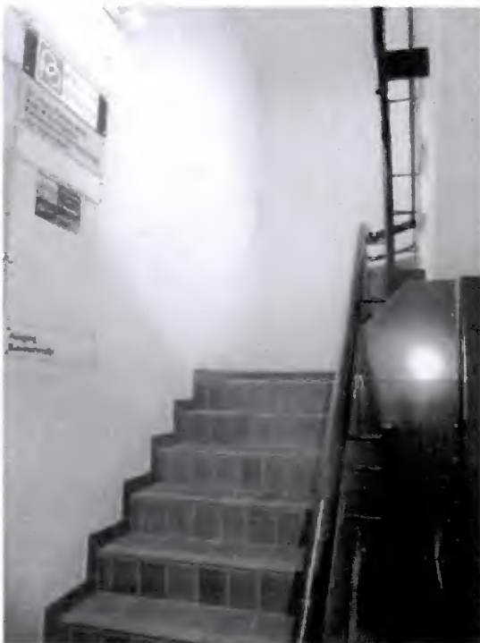
Treppe zum 1. Obergeschoss
