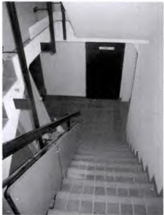
Treppe zum Kellergeschoss
