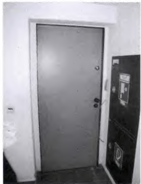
Eingang Bereich MVZ 2. OG
