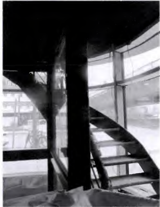
fertigzustellendes Treppenhaus MVZ
