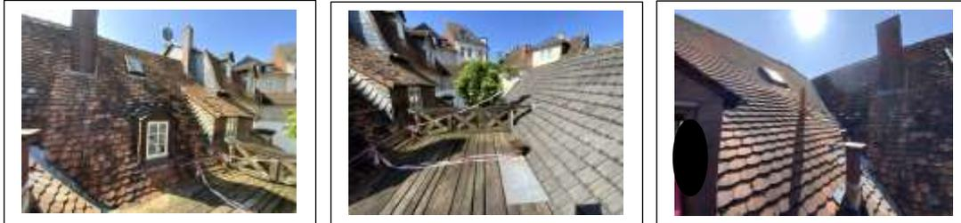
Die Dachterrasse in diesem Bereich ist eine Holzkonstruktion, die ca. 1985 errichtet wurde und bereits deutlich sichtbar durch Feuchtigkeit angegriffen ist und derzeit nicht nutzbar.
