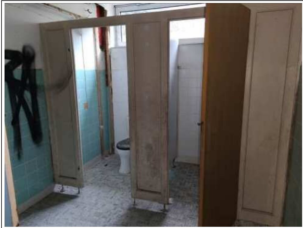
Blick auf WC-Anlagen
