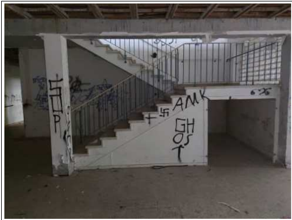
Blick in das Treppenhaus
