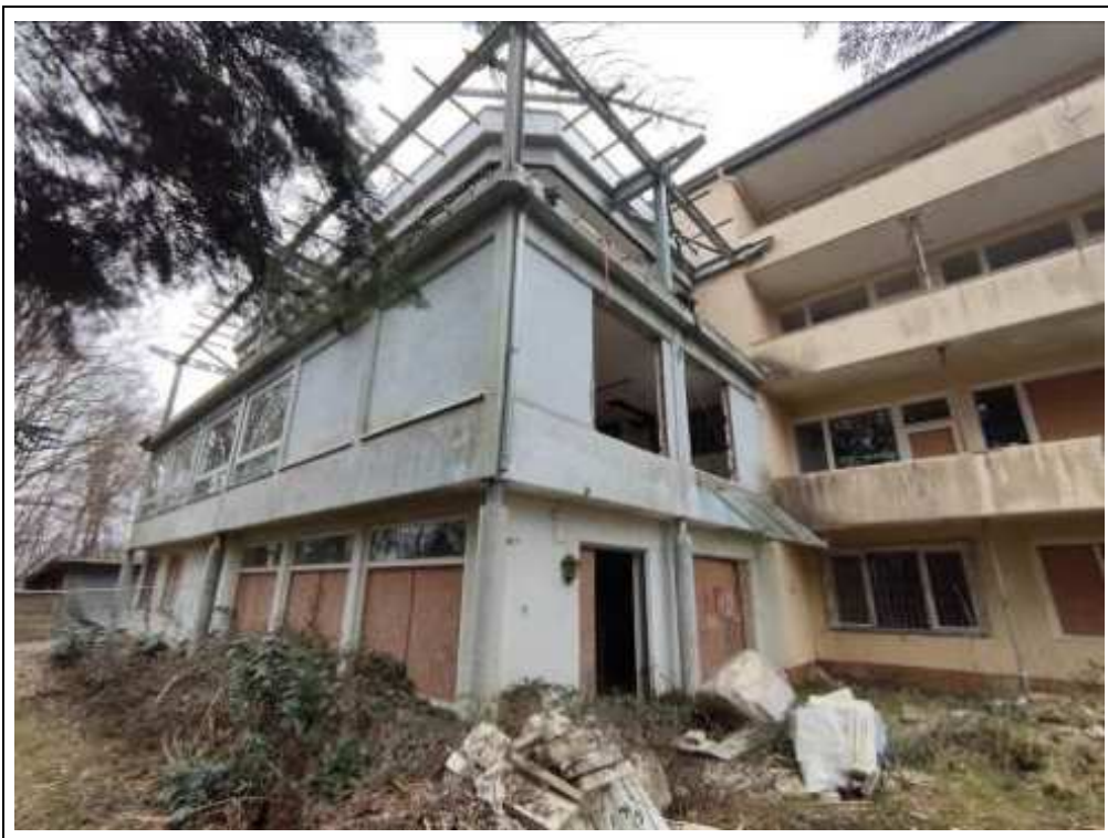
Blick auf das Bewertungsobjekt von Nordosten (Eingangsbereich)
