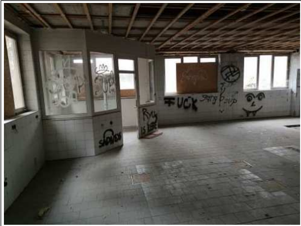
Blick in den Hauptraum im Kellergeschoss
