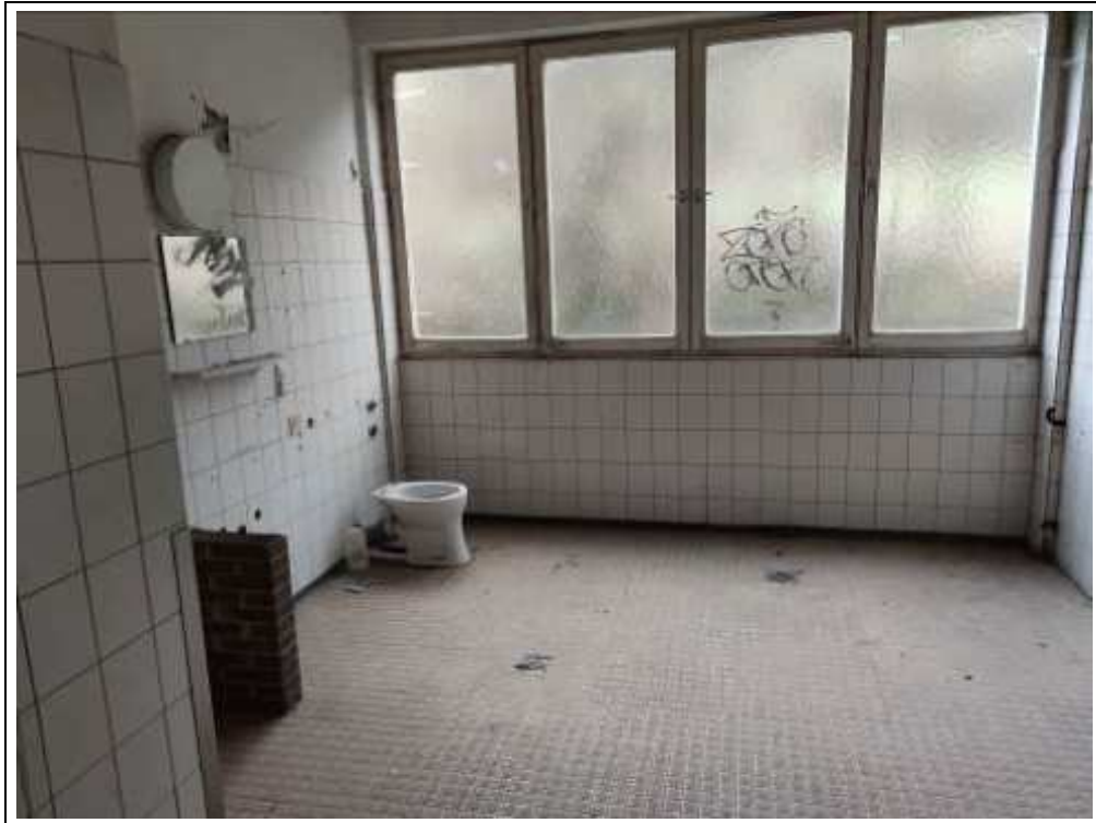
Blick in einen Sanitärraum
