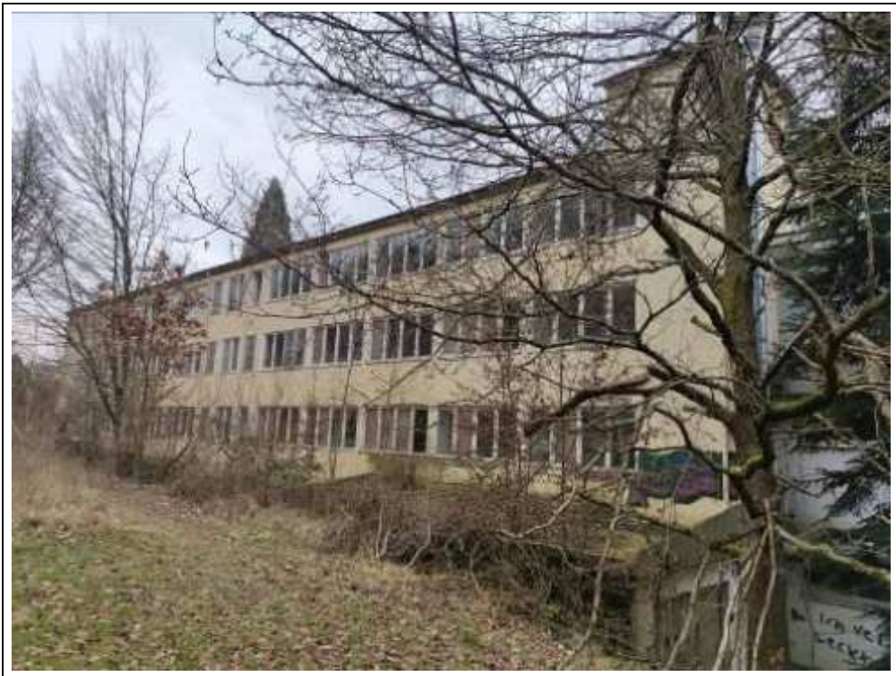
Blick auf das Bewertungsobjekt von Südwesten
