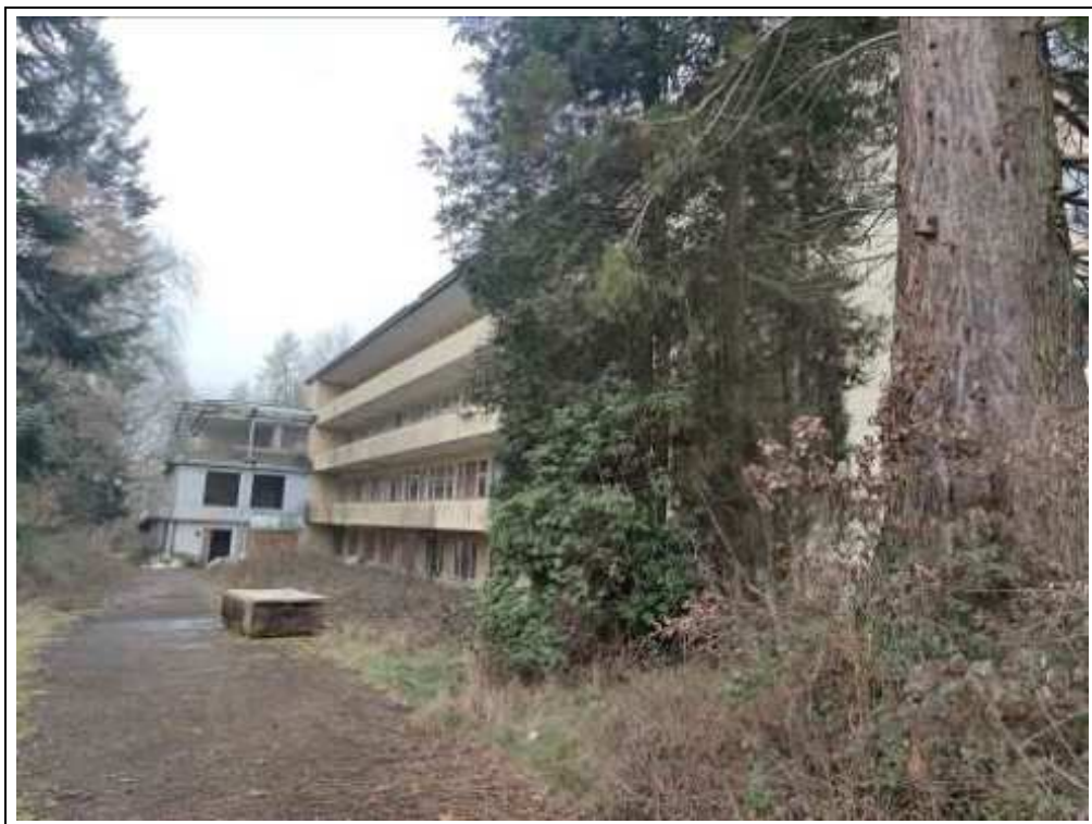
Blick auf das Bewertungsobjekt von Norden
