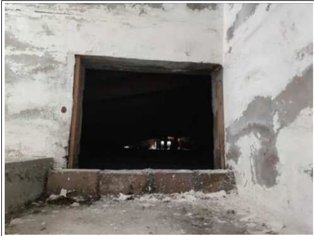
Blick auf einen Zugang zum Dachboden
