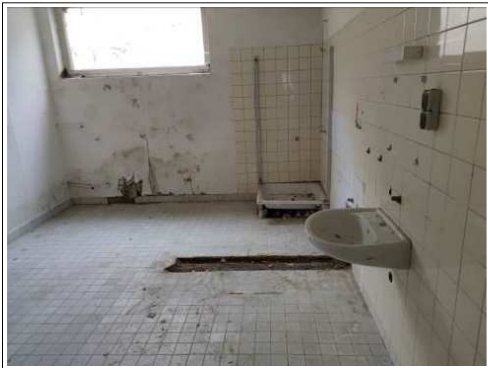
Blick in ein Sanitärraum
