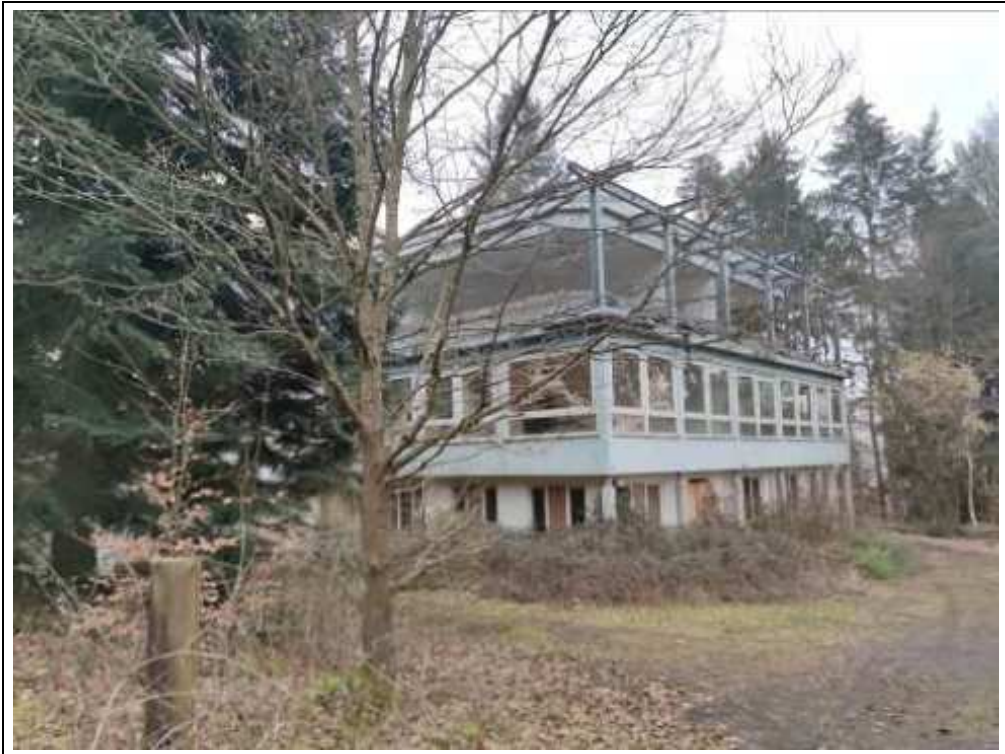
Blick auf das Bewertungsobjekt von Südwesten
