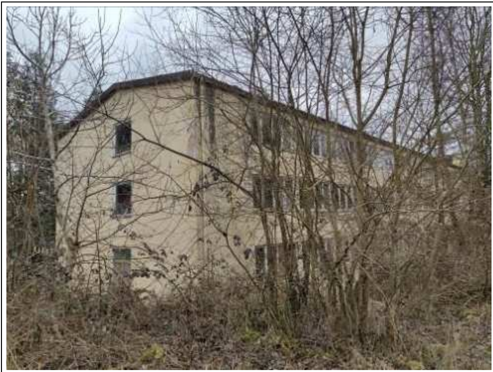
Blick auf das Bewertungsobjekt von Nordwesten
