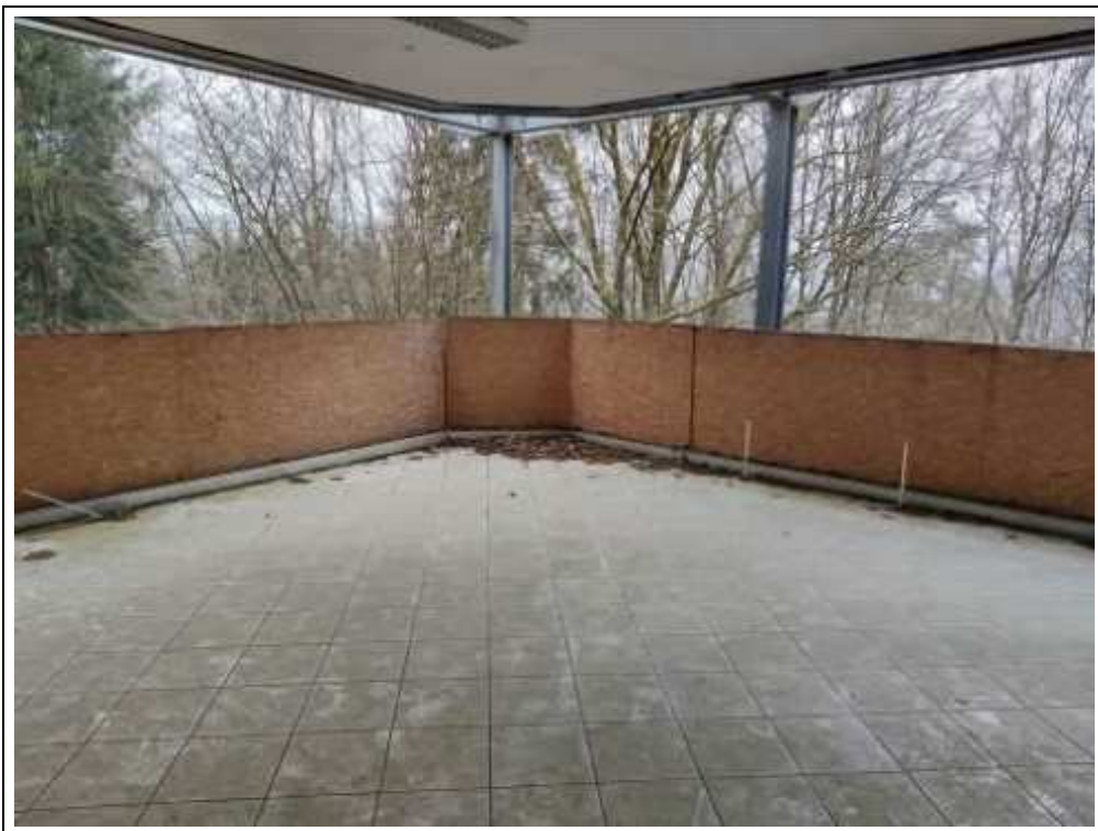
Blick auf die überdachte Terrasse im 1. Obergeschoss
