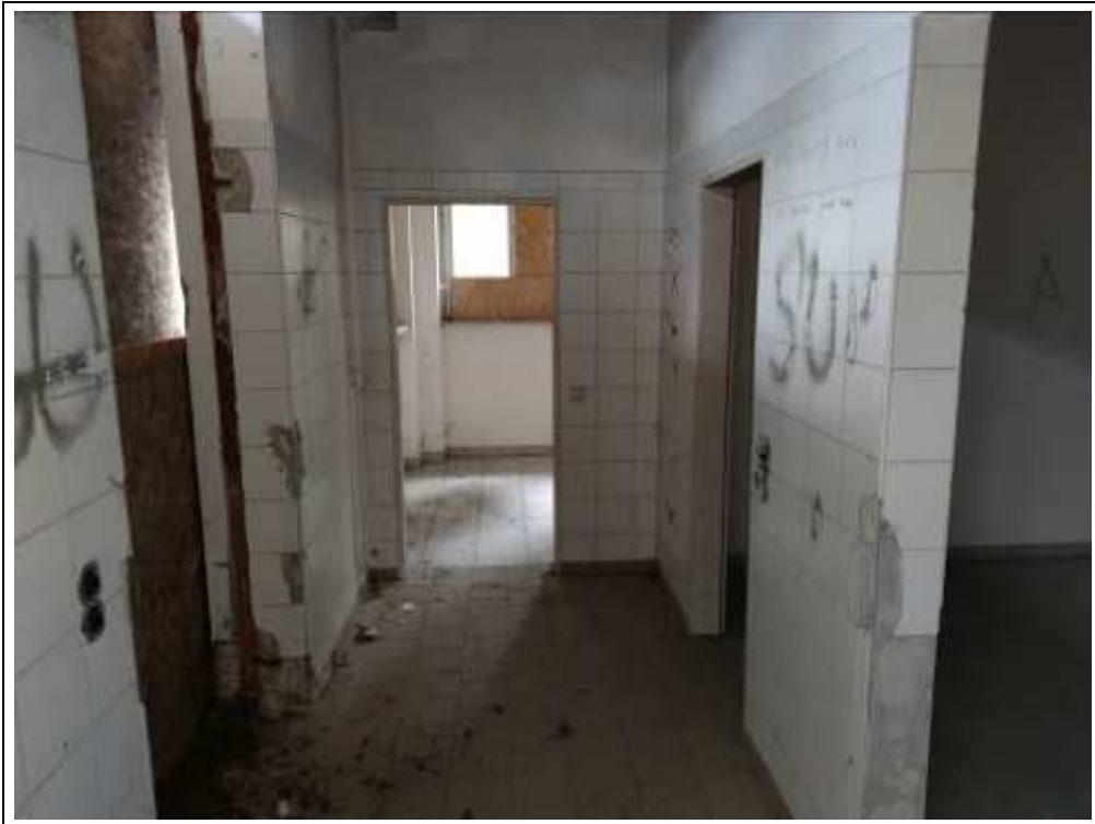
Blick in kleine Sanitärräume
