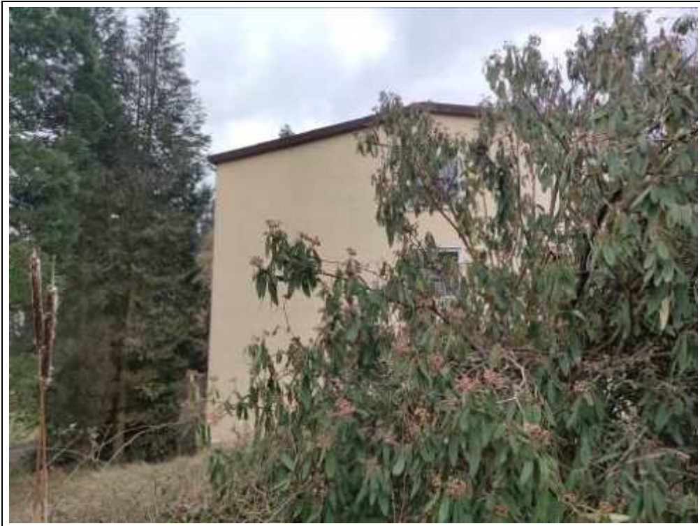
Blick auf das Bewertungsobjekt von Norden
