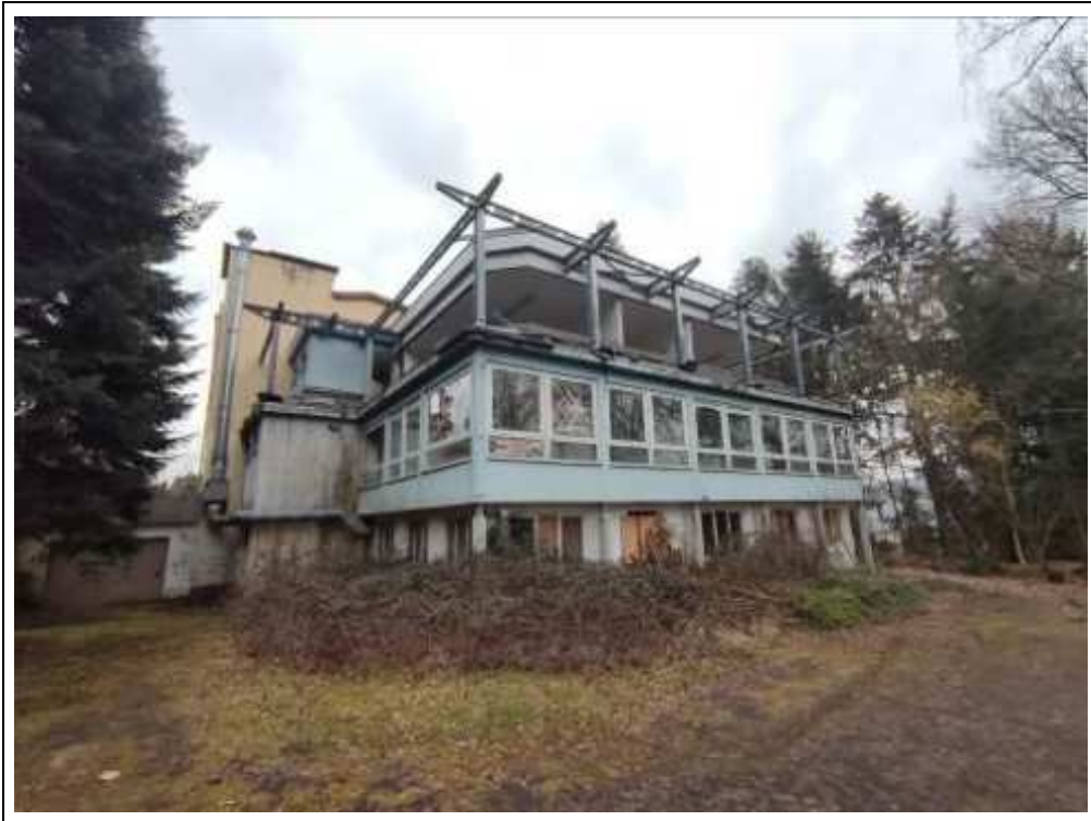
Blick auf das Bewertungsobjekt von Südwesten
