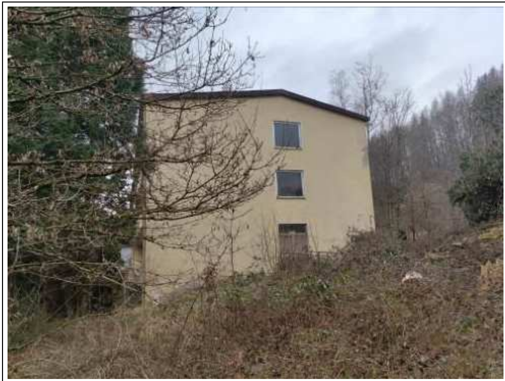
Blick auf das Bewertungsobjekt von Norden
