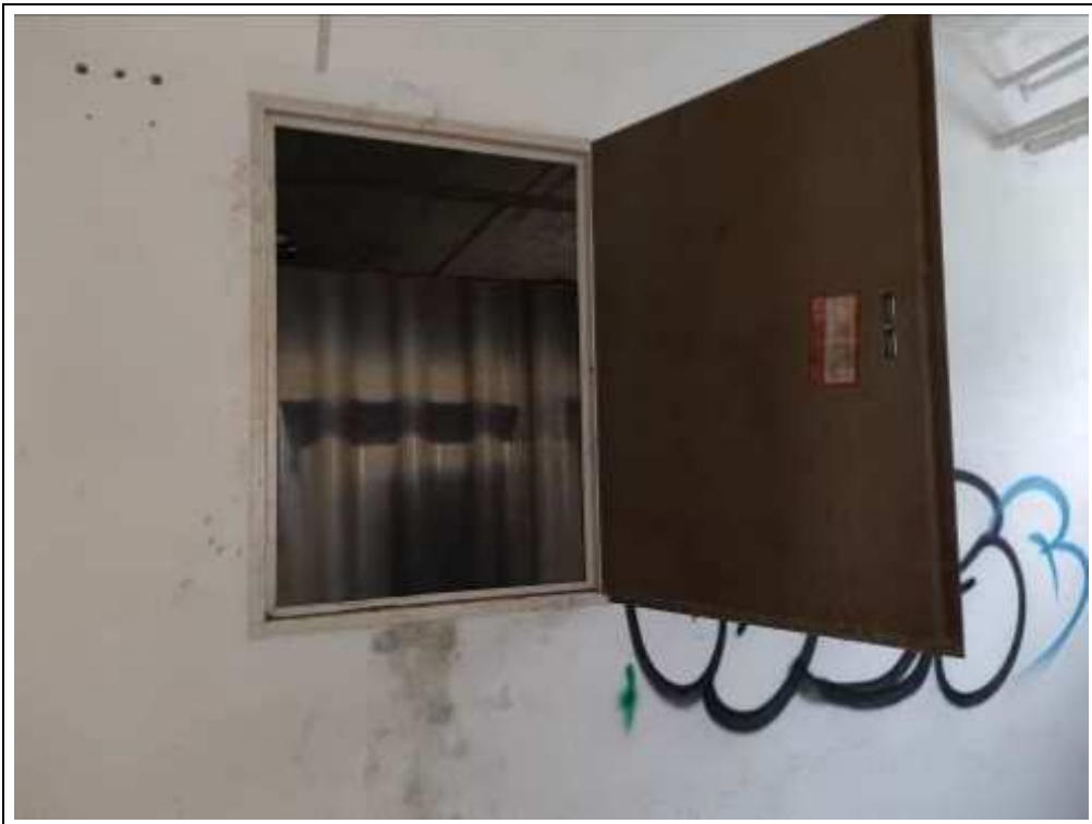
Blick in den Tankraum
