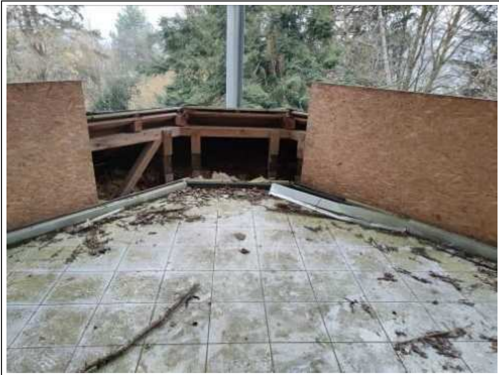
Blick auf die überdachte Terrasse im 1. Obergeschoss
