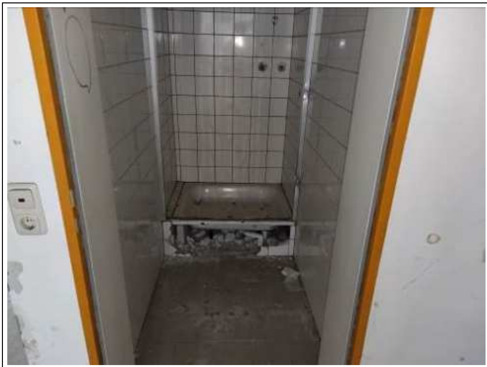
Blick in eine Dusche
