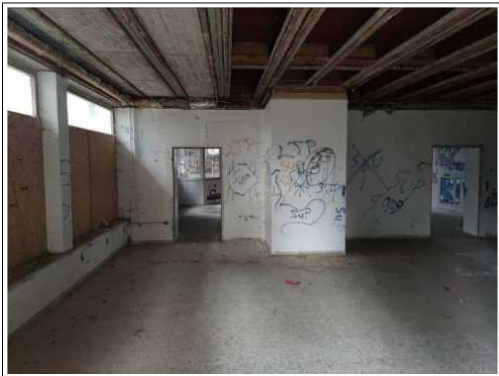
Blick in den Hauptraum im Kellergeschoss
