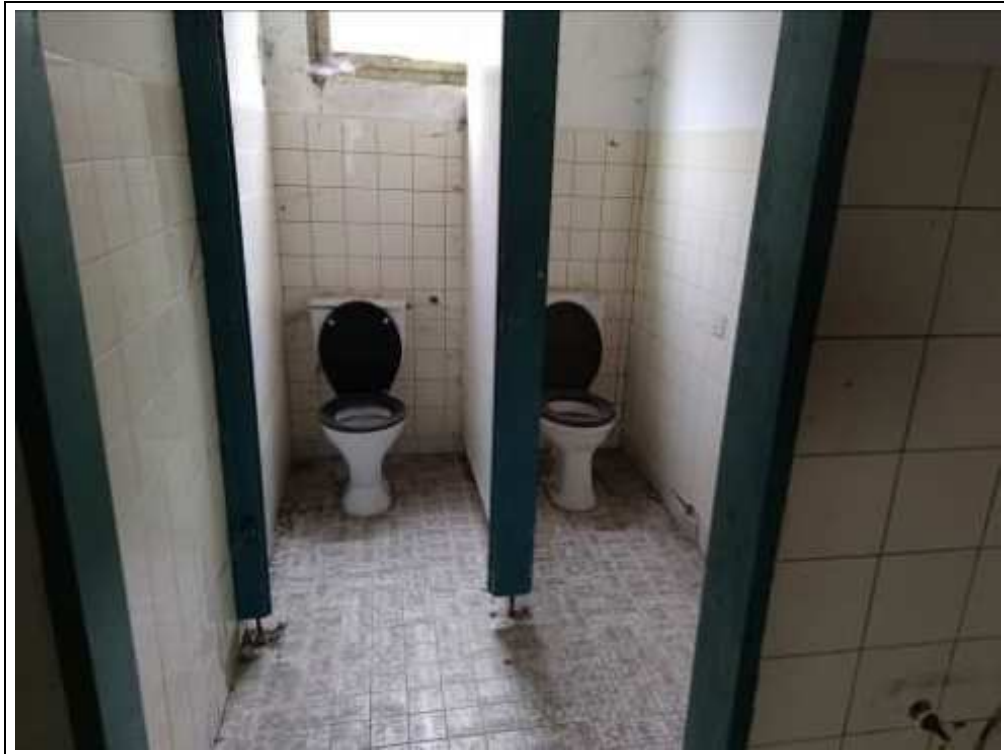
Blick in ein WC
