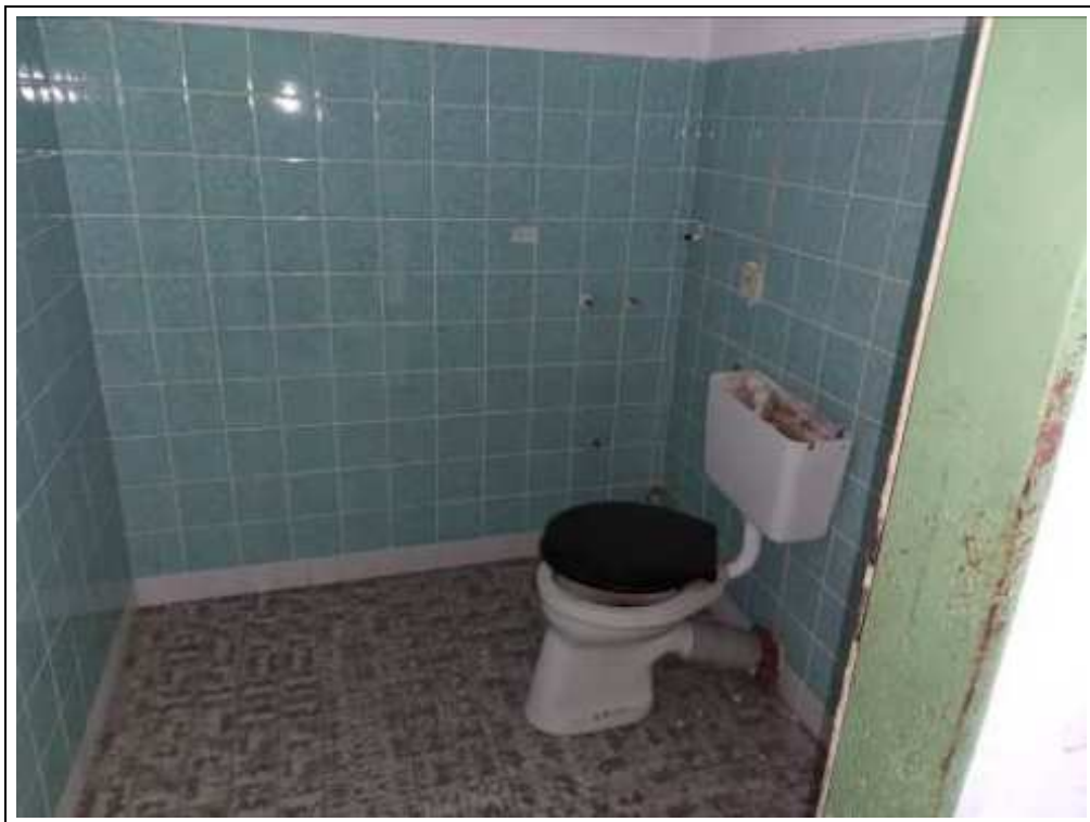
Blick in ein WC
