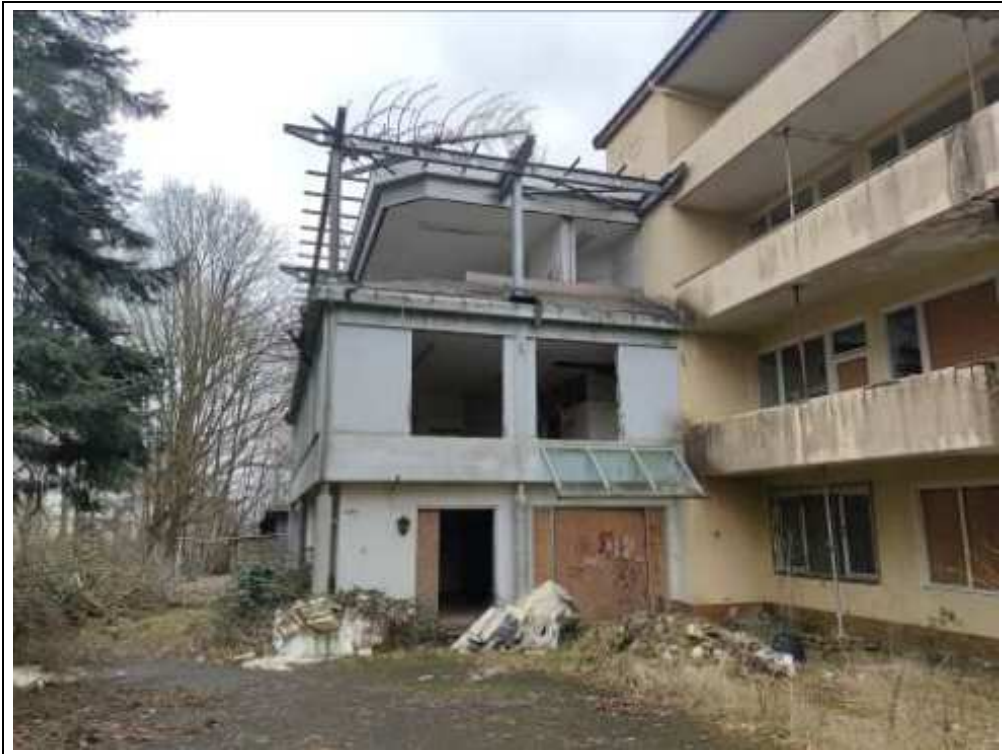
Blick auf das Bewertungsobjekt von Norden (Eingangsbereich)
