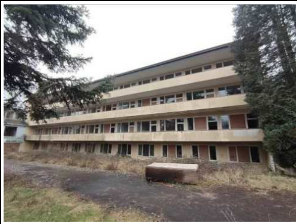
Blick auf das Bewertungsobjekt von Nordosten
