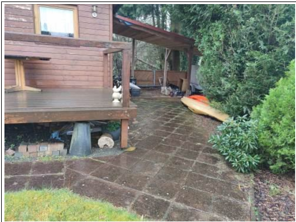
Blick auf die angebaute Überdachung am Gartenhaus
