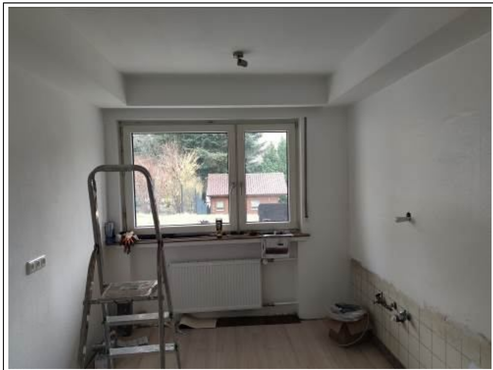
Blick in die Küche im Kellergeschoss
