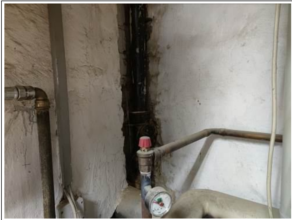
Blick auf die Ausführung der Abwasserleitungen im Kellergeschoss
