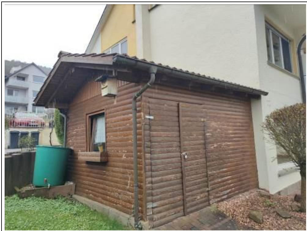
Blick auf das angebaute Gartengerätehaus
