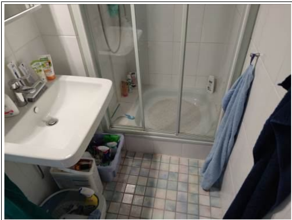
Blick in die separate Dusche im Dachgeschoss
