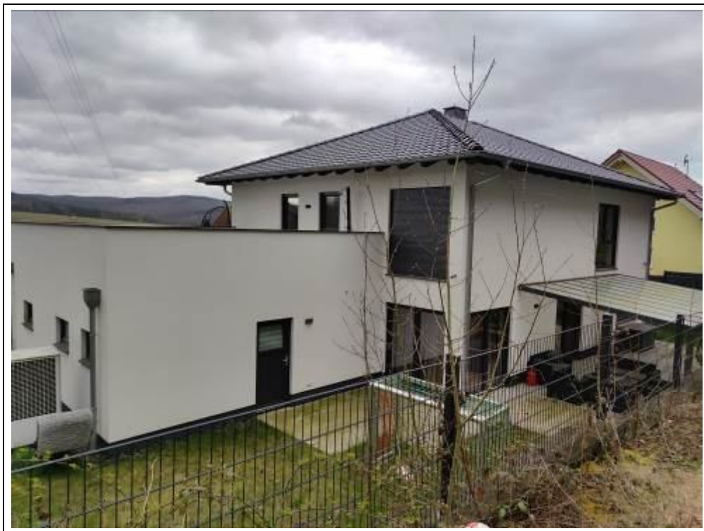
Blick auf das Bewertungsobjekt von Nordosten
