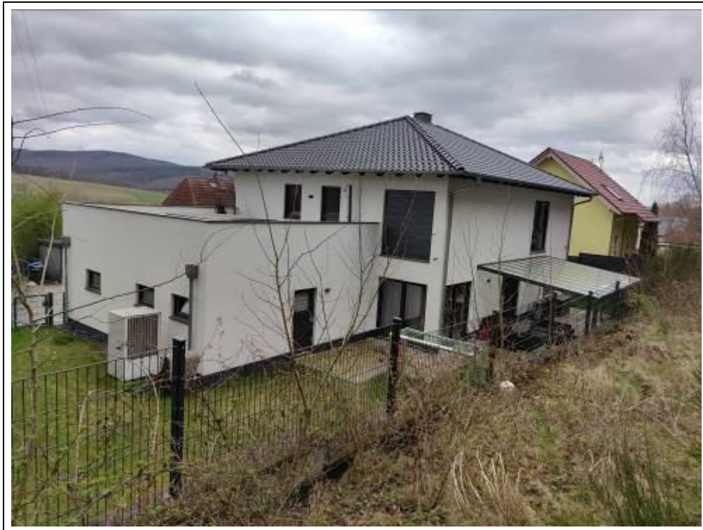
Blick auf das Bewertungsobjekt von Nordosten
