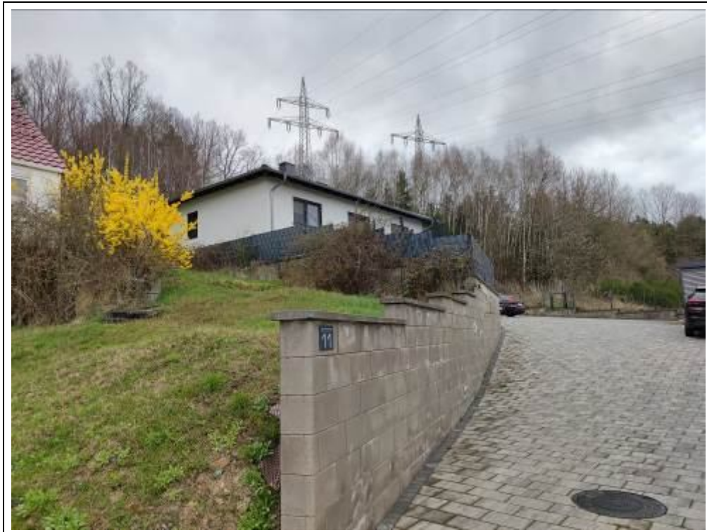
Blick auf das Bewertungsobjekt von Südwesten
