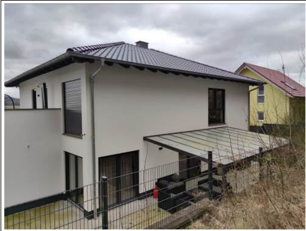
Blick auf das Bewertungsobjekt von Norden
