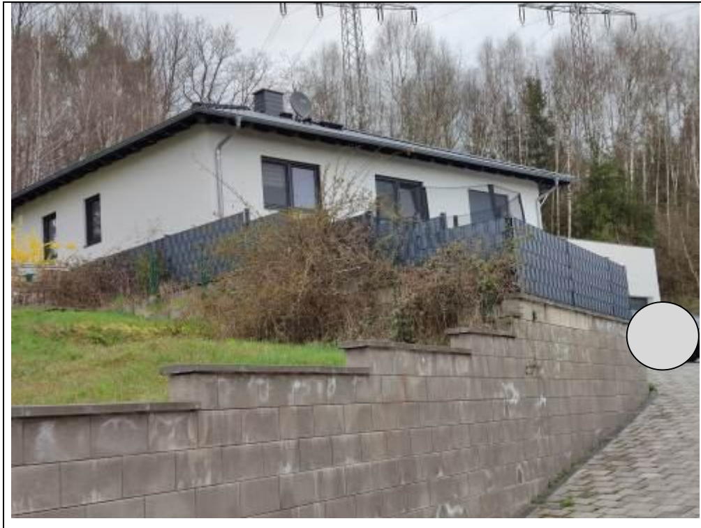
Blick auf das Bewertungsobjekt von Südwesten
