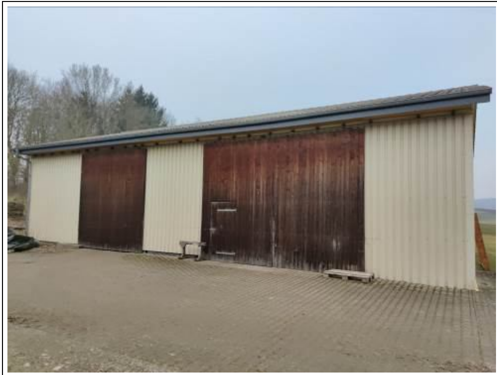
Blick auf Lagerhalle 3 von Südosten
