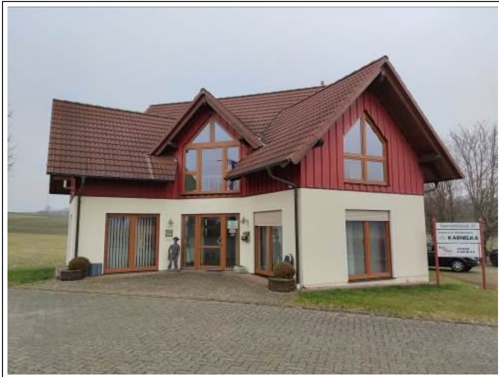
Blick auf das Bürogebäude von Südosten
