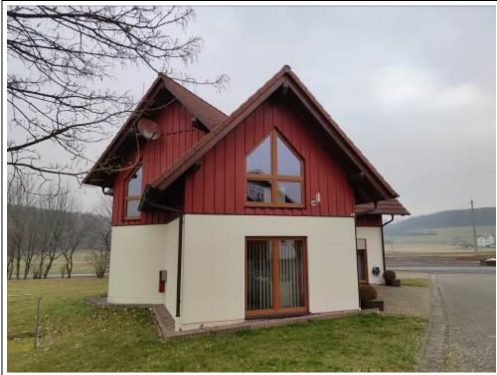
Blick auf das Bürogebäude von Südwesten
