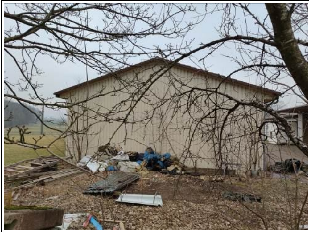
Blick auf Lagerhalle 3 von Südwesten
