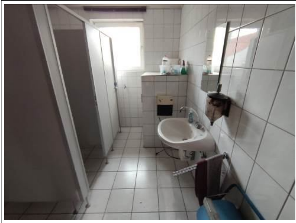
Blick in den Sanitärraum
