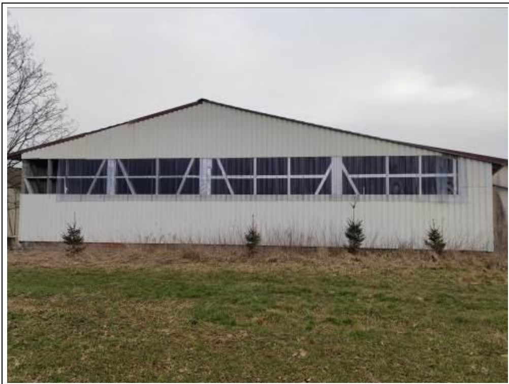
Blick auf die Werk- und Lagerhalle von Südwesten
