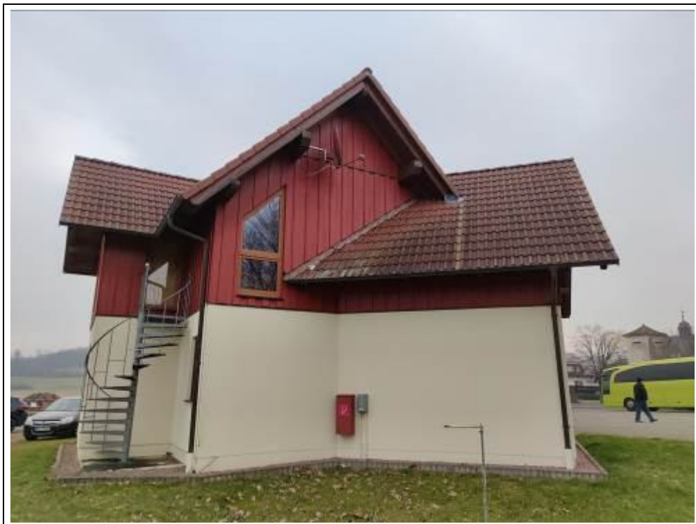
Blick auf das Bürogebäude von Südwesten
