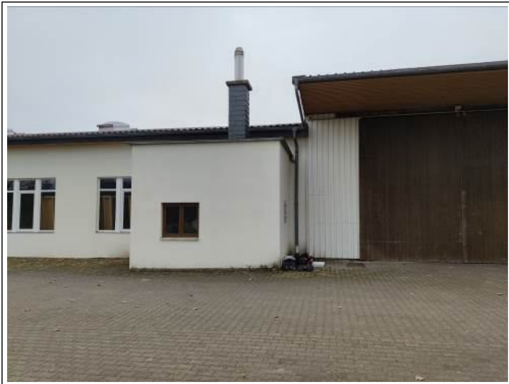
Blick auf die Werk- und Lagerhalle von Nordwesten (Heizraumanbau)
