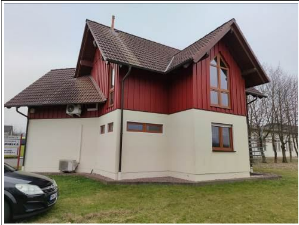
Blick auf das Bürogebäude von Norden
