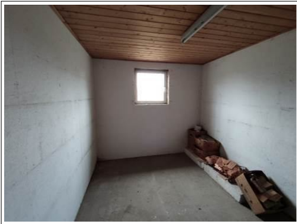
Blick in einen Lagerraum
