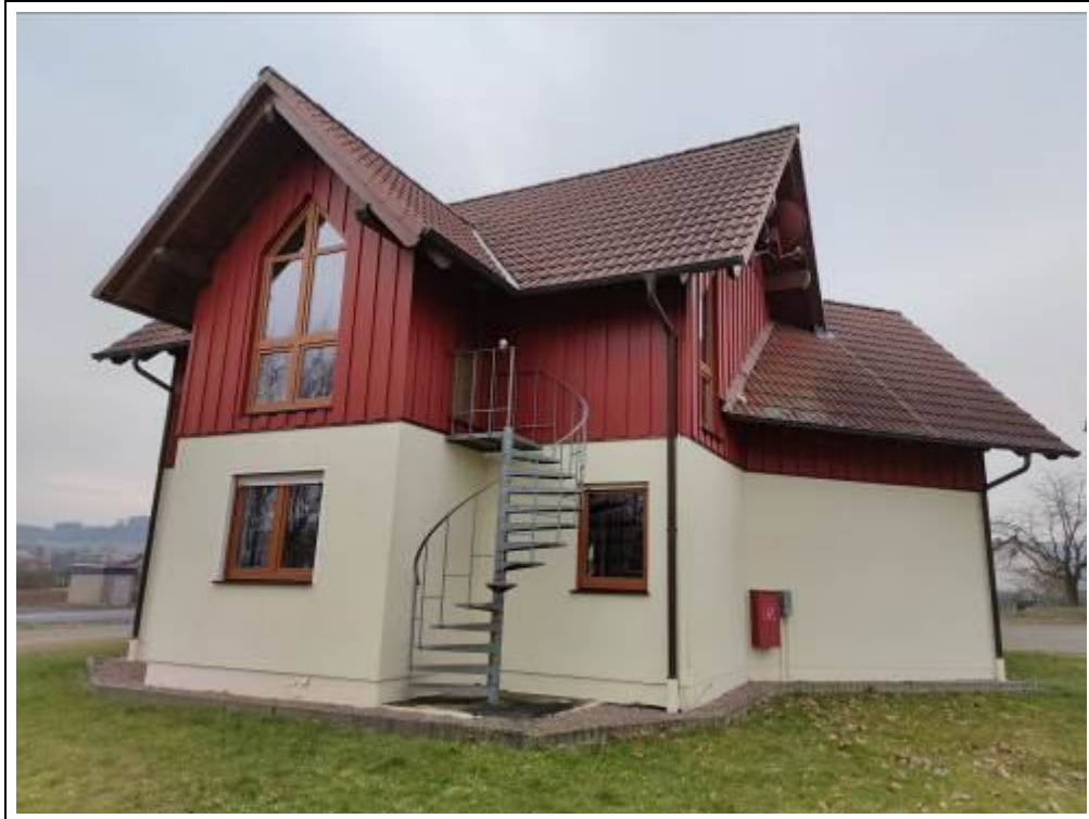
Blick auf das Bürogebäude von Westen
