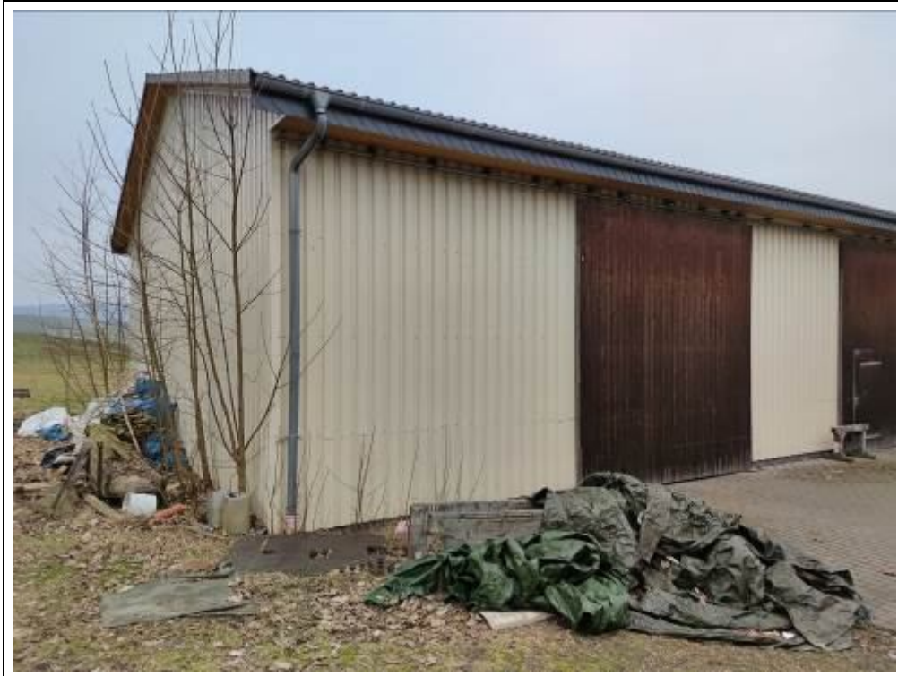
Blick auf Lagerhalle 3 von Süden
