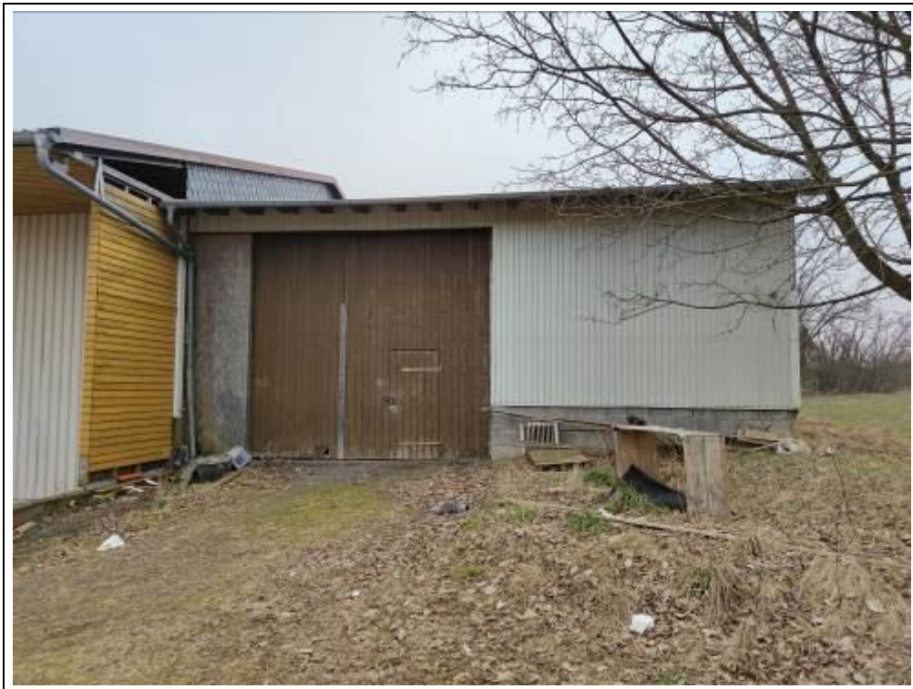
Blick auf die Werk- und Lagerhalle von Nordwesten (Zufahrt zum Lagerhallenanbau)osten
