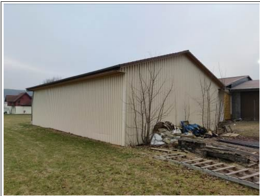
Blick auf Lagerhalle 3 von Westen
