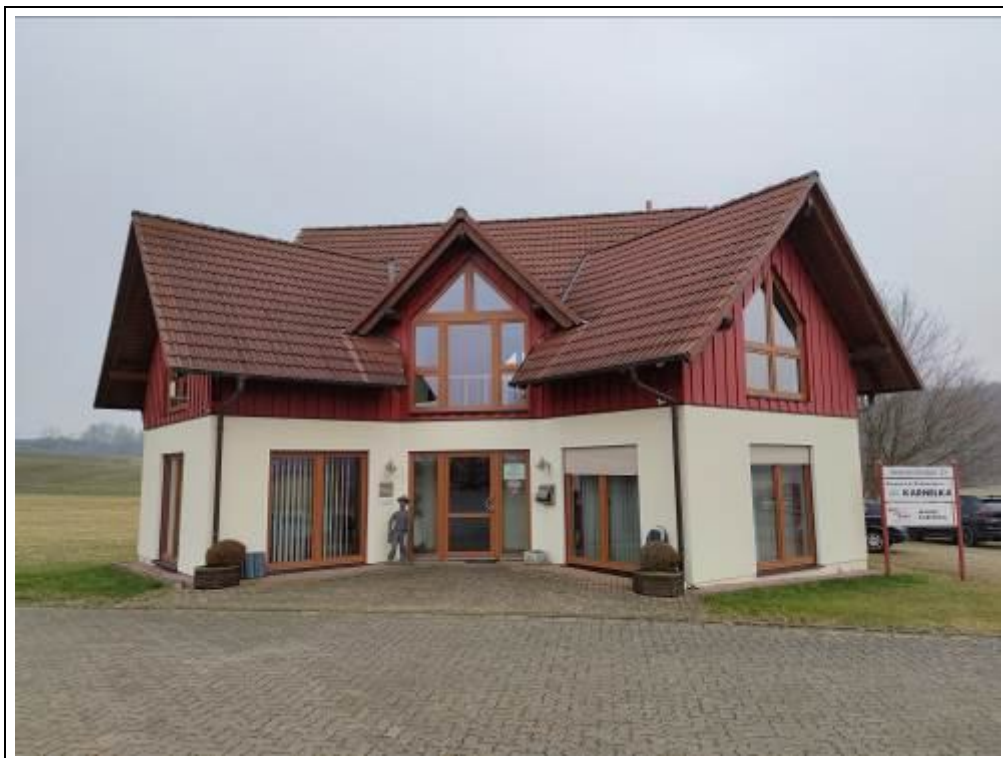
Blick auf das Bürogebäude von Südosten
