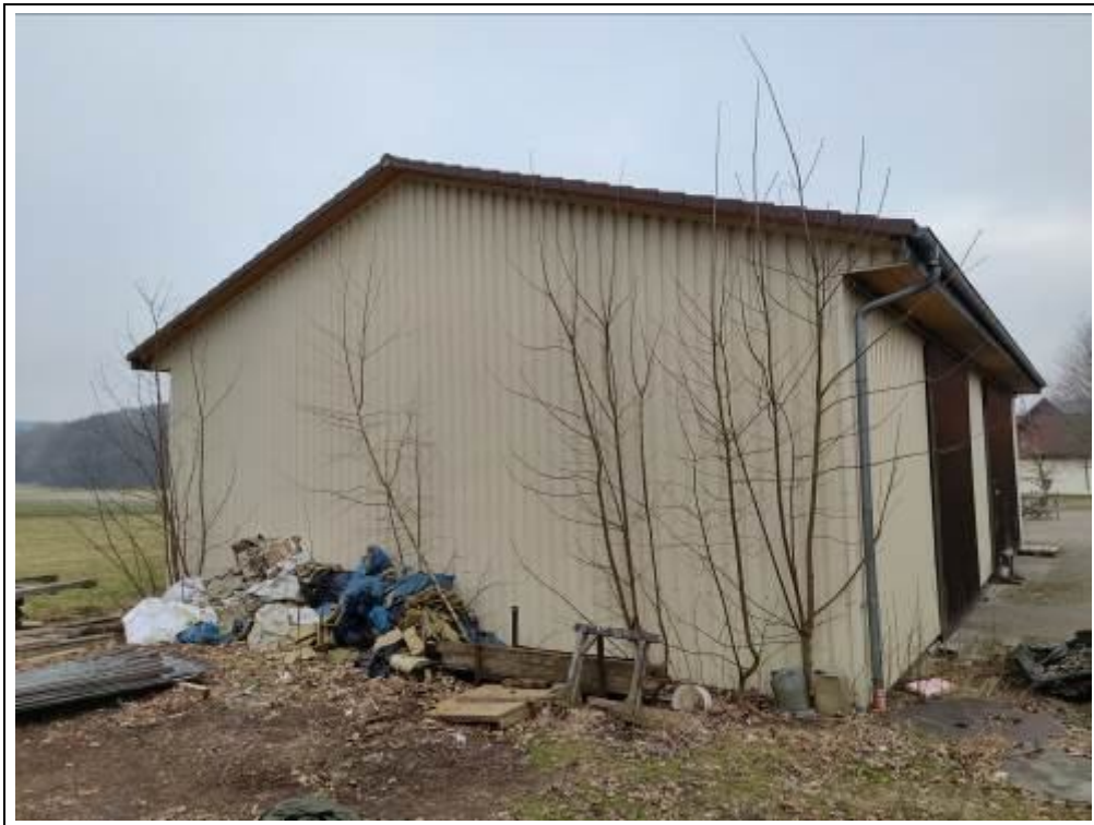
Blick auf Lagerhalle 3 von Südwesten
