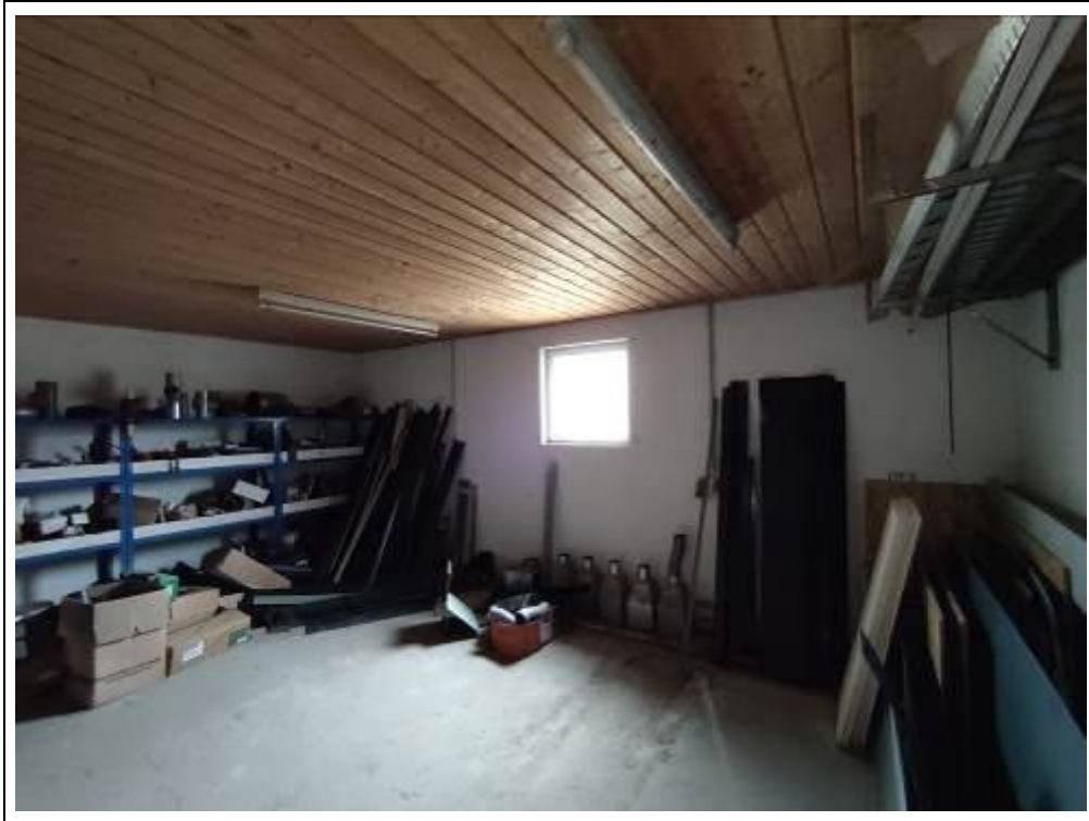
Blick in einen Lagerraum
