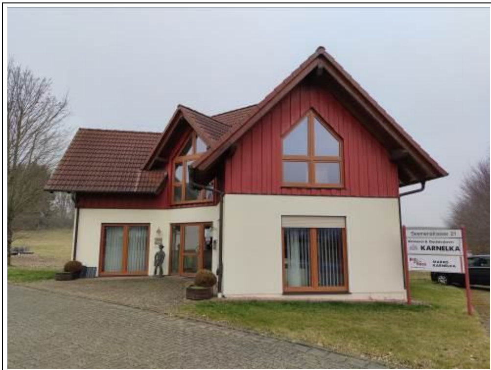
Blick auf das Bürogebäude von Osten
