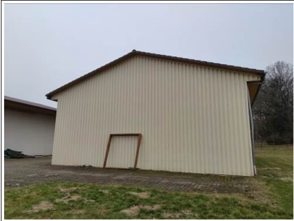
Blick auf Lagerhalle 3 von Nordosten
