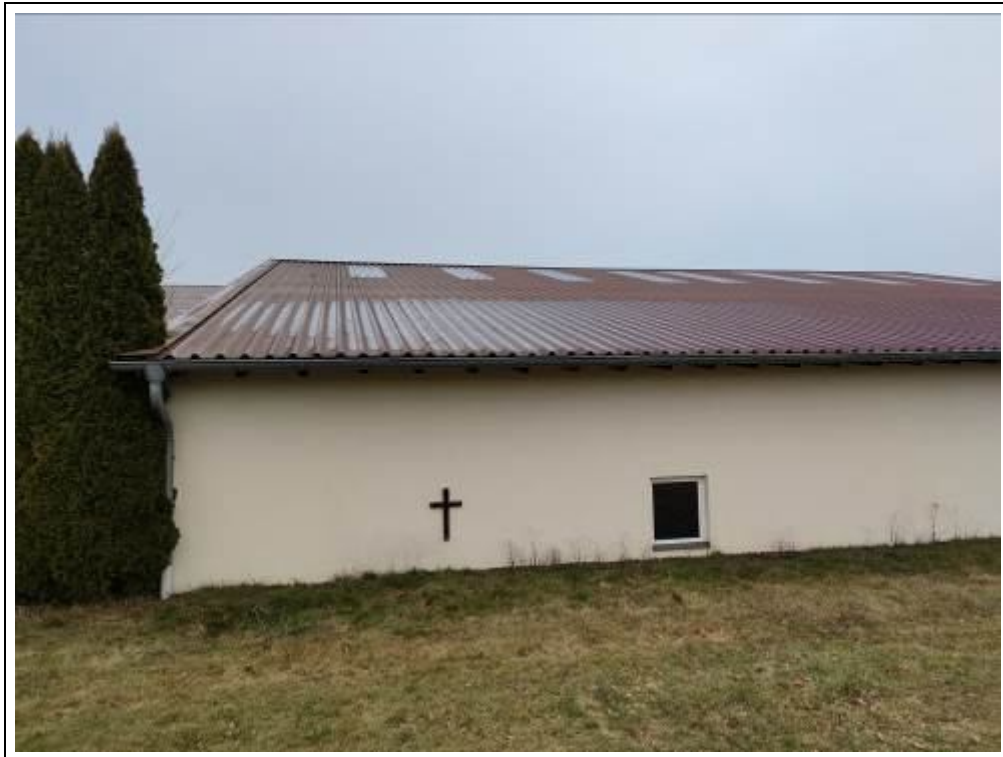
Blick auf die Werk- und Lagerhalle von Südosten (Teilansicht)
