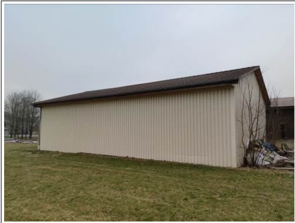
Blick auf Lagerhalle 3 von Nordwesten
