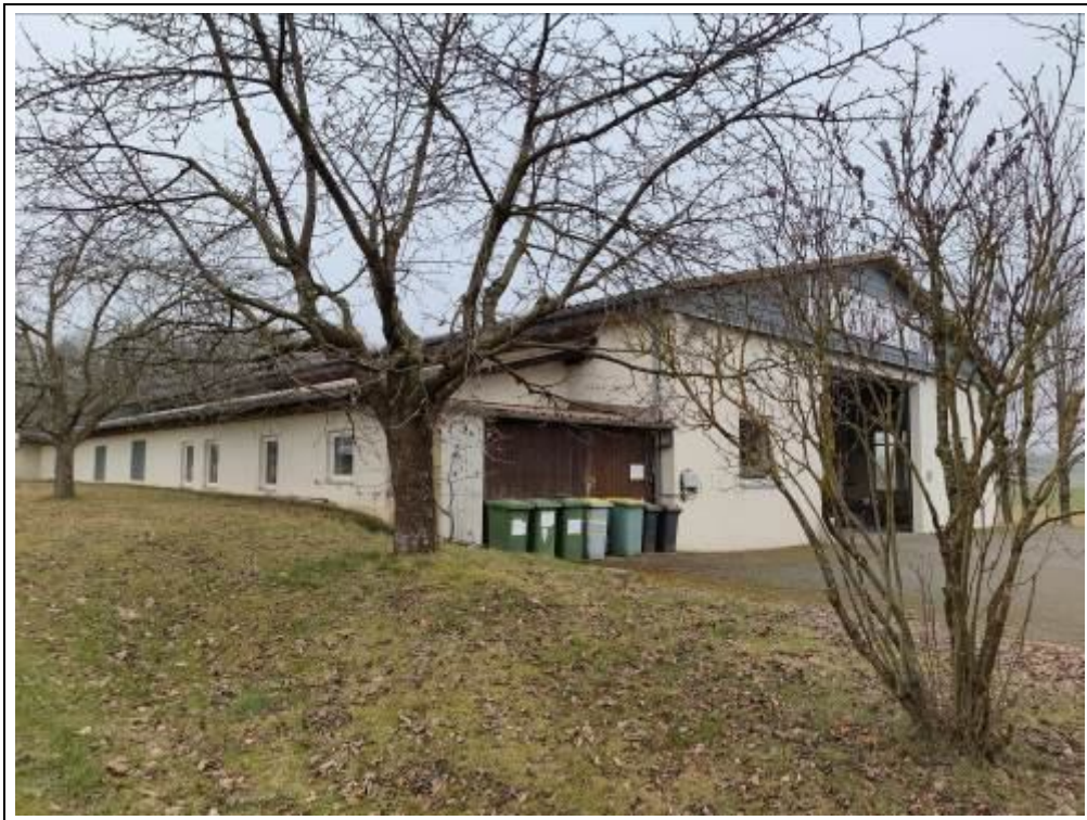
Blick auf die Werk- und Lagerhalle von Nordosten
