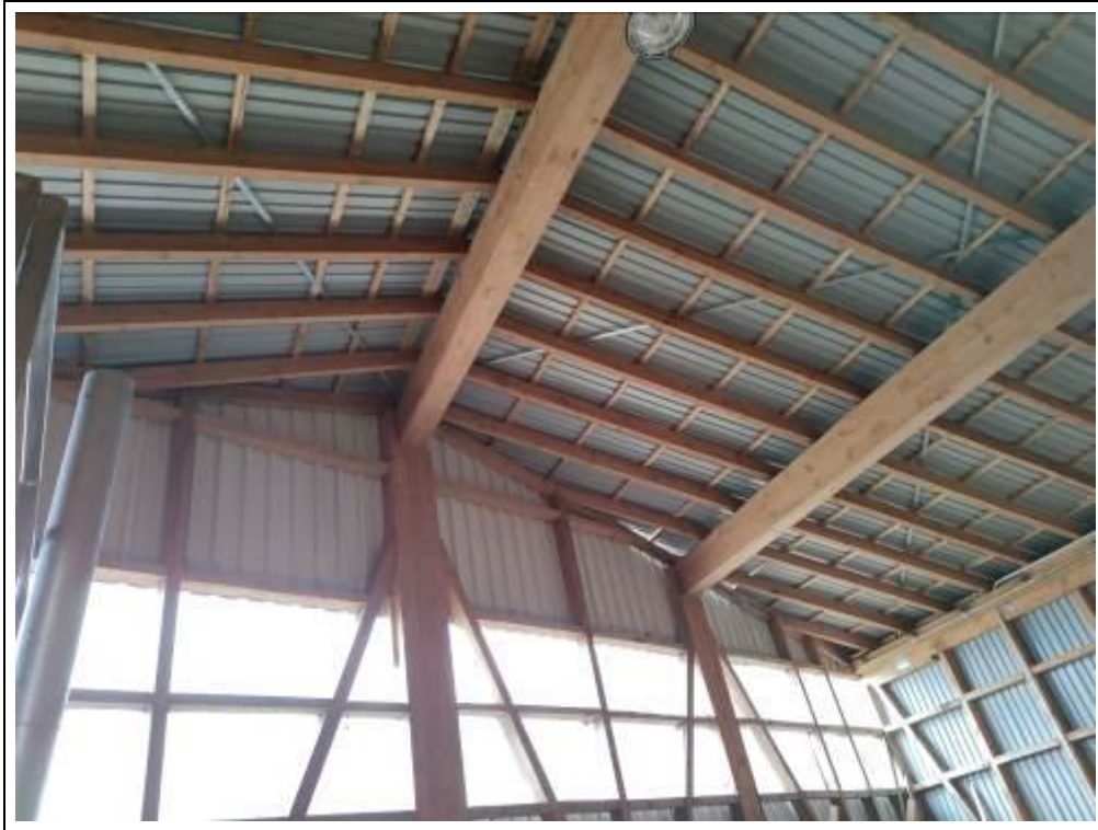
Blick gegen die Dachkonstruktion im Lagerhallenanbau
