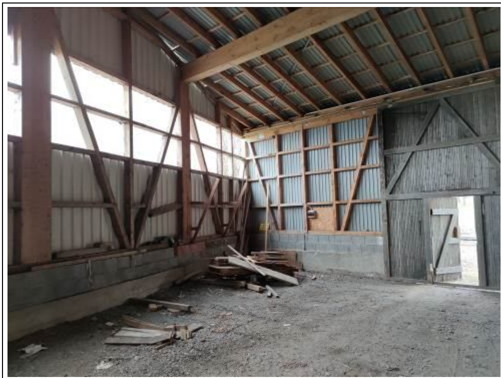
Blick in den Lagerhallenbau
