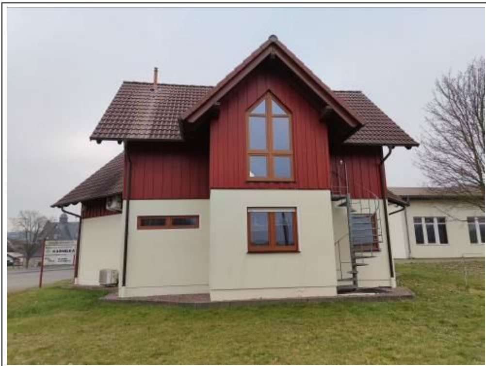
Blick auf das Bürogebäude von Nordwesten
