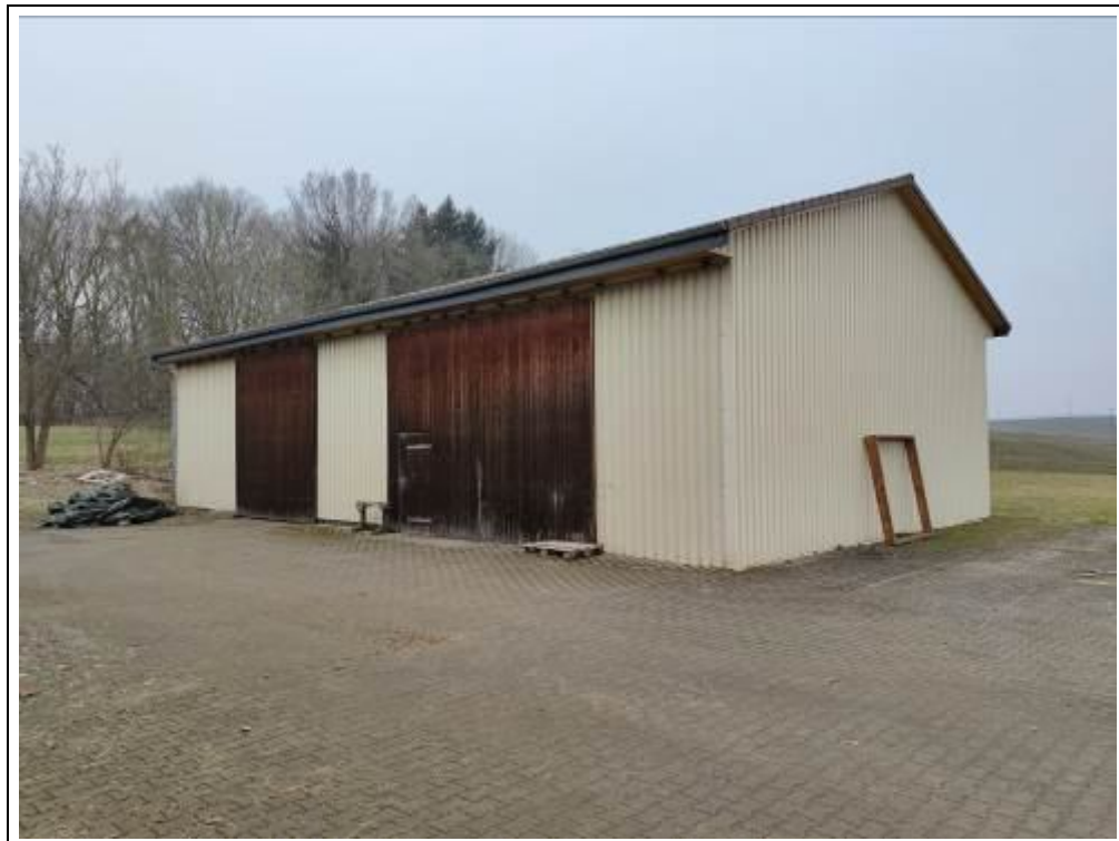
Blick auf Lagerhalle 3 von Osten
