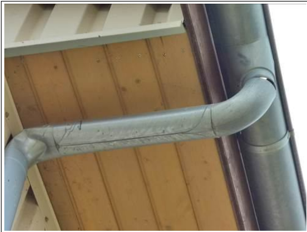
Blick auf den verkleideten Dachüberstand und die Dachentwässerung
