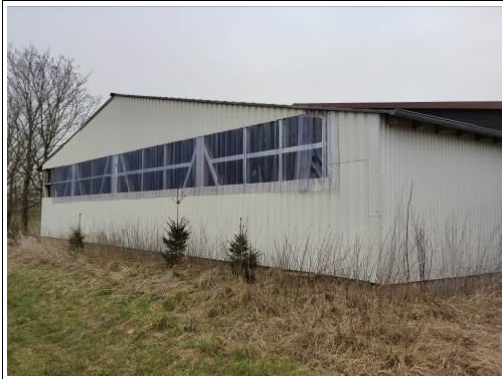
Blick auf die Werk- und Lagerhalle von Süden
