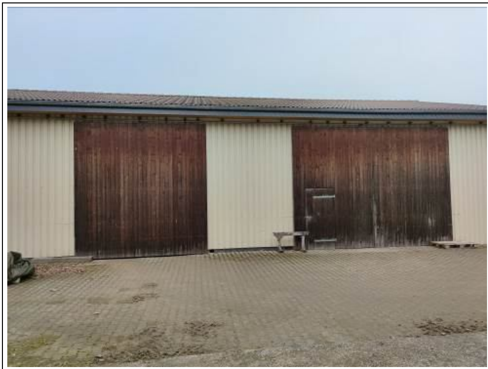
Blick auf Lagerhalle 3 von Südosten
