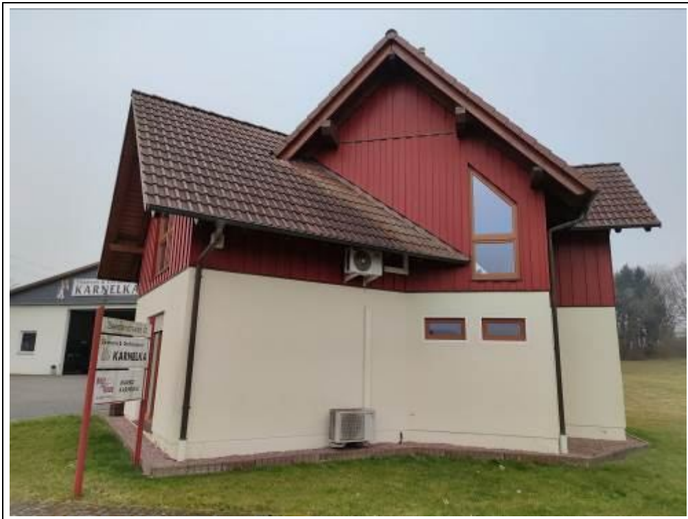
Blick auf das Bürogebäude von Norden
