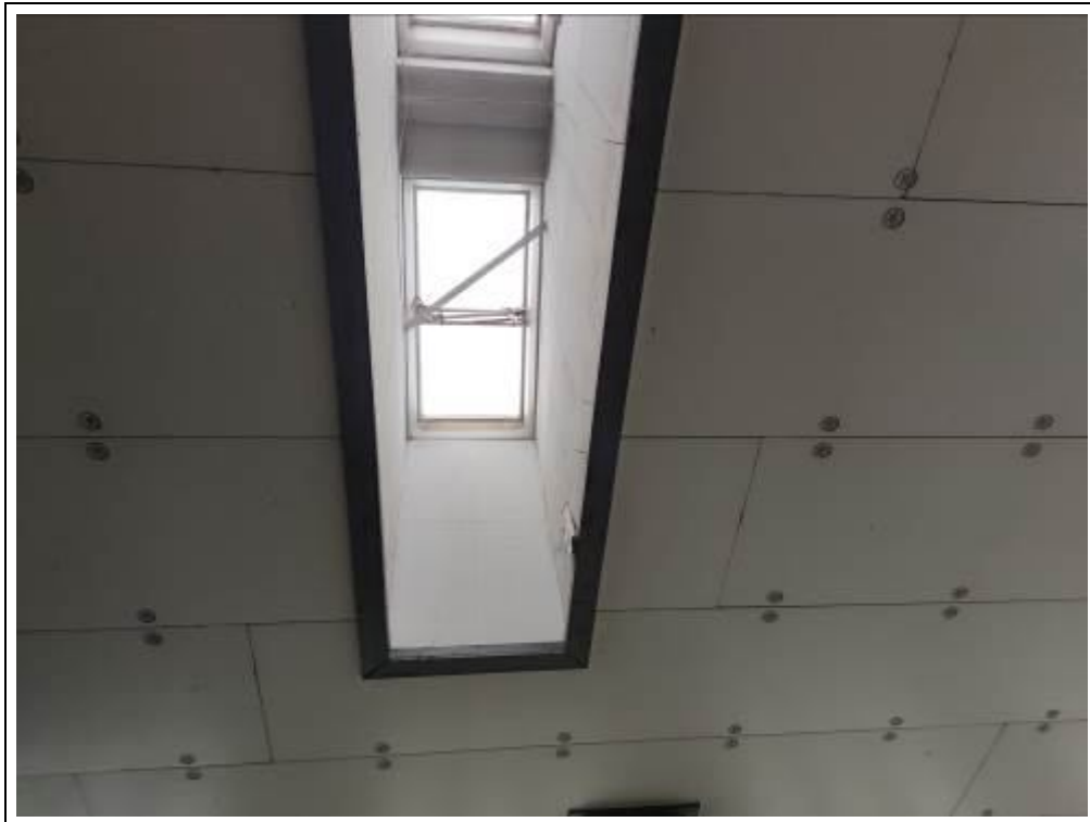
Blick gegen die abgehängte Decke sowie die als Rauch- und Wärmeabzugsanlage ausgebildete Lichtkuppel
