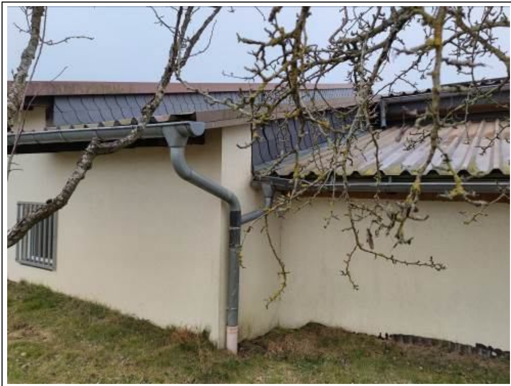
Blick auf die Werk- und Lagerhalle von Osten, Detail Gebäudeübergang)
