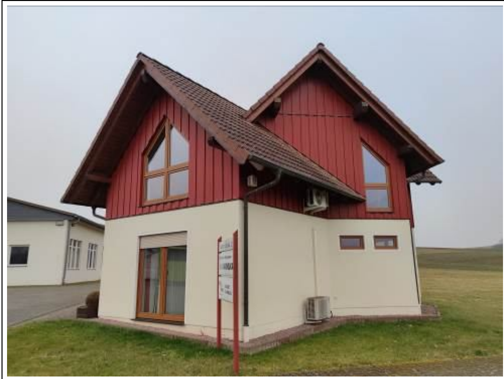
Blick auf das Bürogebäude von Nordosten
