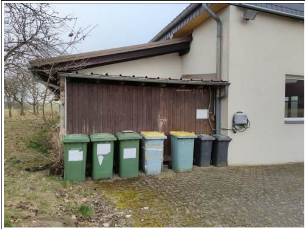
Blick auf den angebauten Hundezwinger (Nutzung für Abfall)
