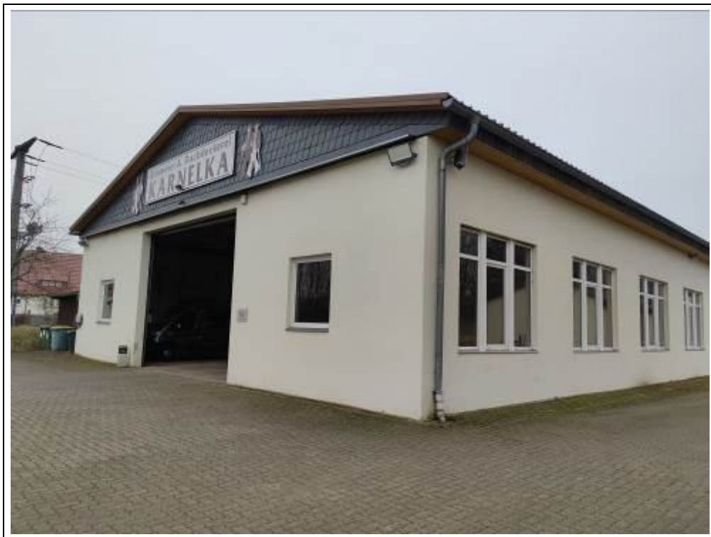
Blick auf die Werk- und Lagerhalle von Norden
