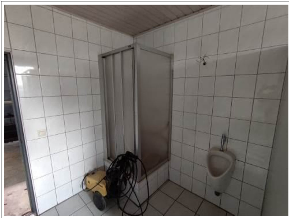
Blick in den Sanitärraum
