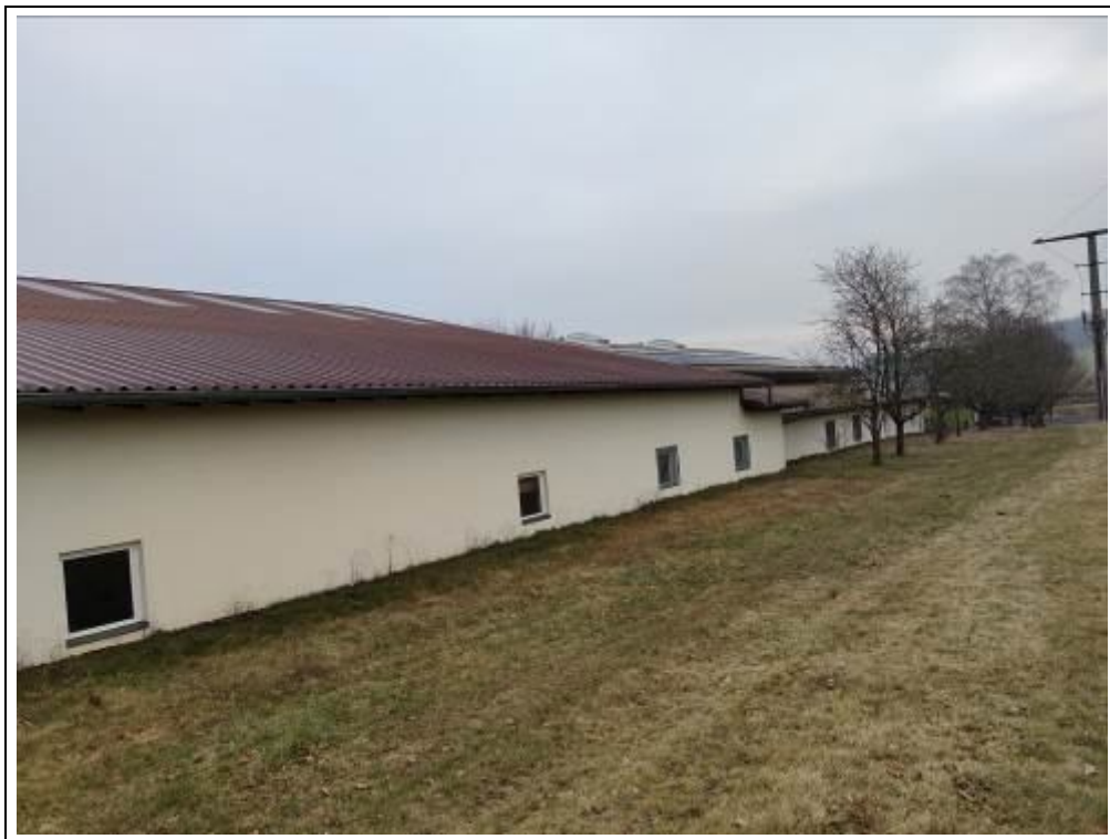
Blick auf die Werk- und Lagerhalle von Süden (Teilansicht)
