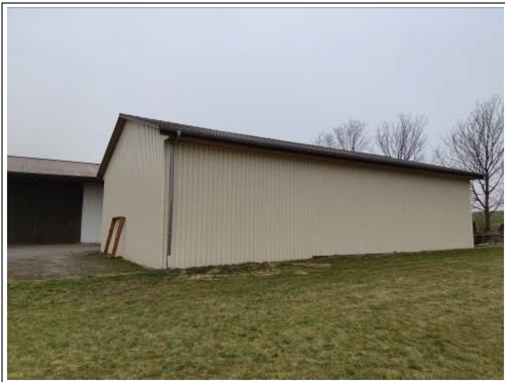
Blick auf Lagerhalle 3 von Norden
