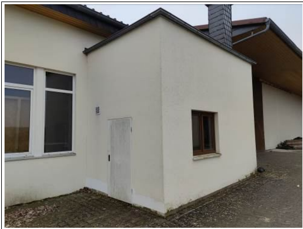
Blick auf die Werk- und Lagerhalle von Norden (Heizraumanbau)
