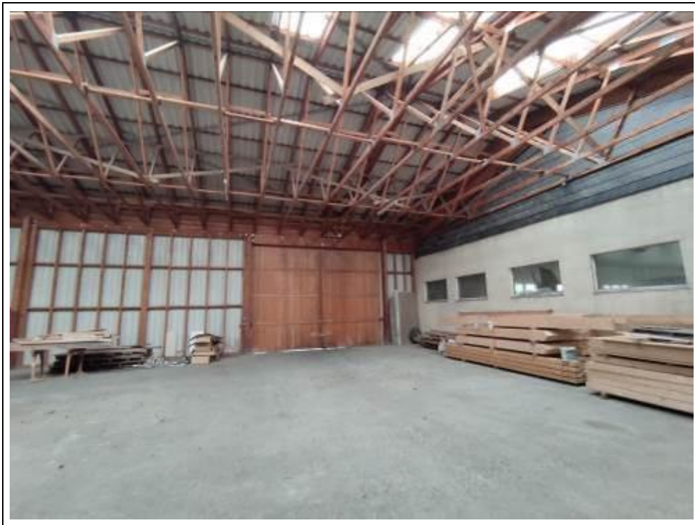
Blick in die Werk- und Lagerhalle Bauabschnitt II
