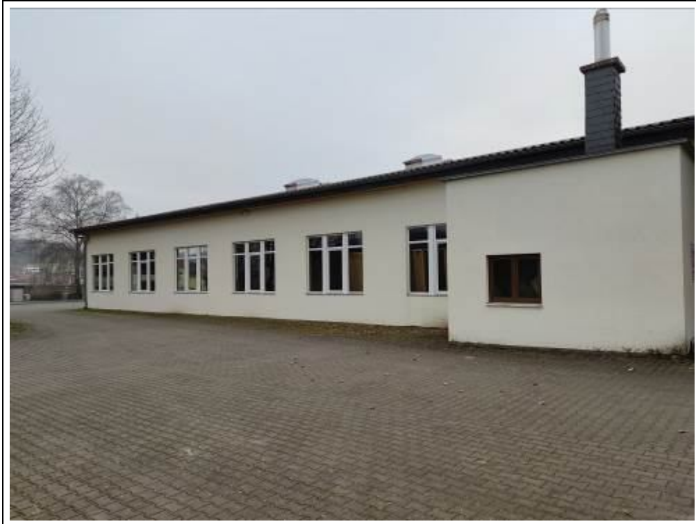
Blick auf die Werk- und Lagerhalle von Westen (Teilansicht)
