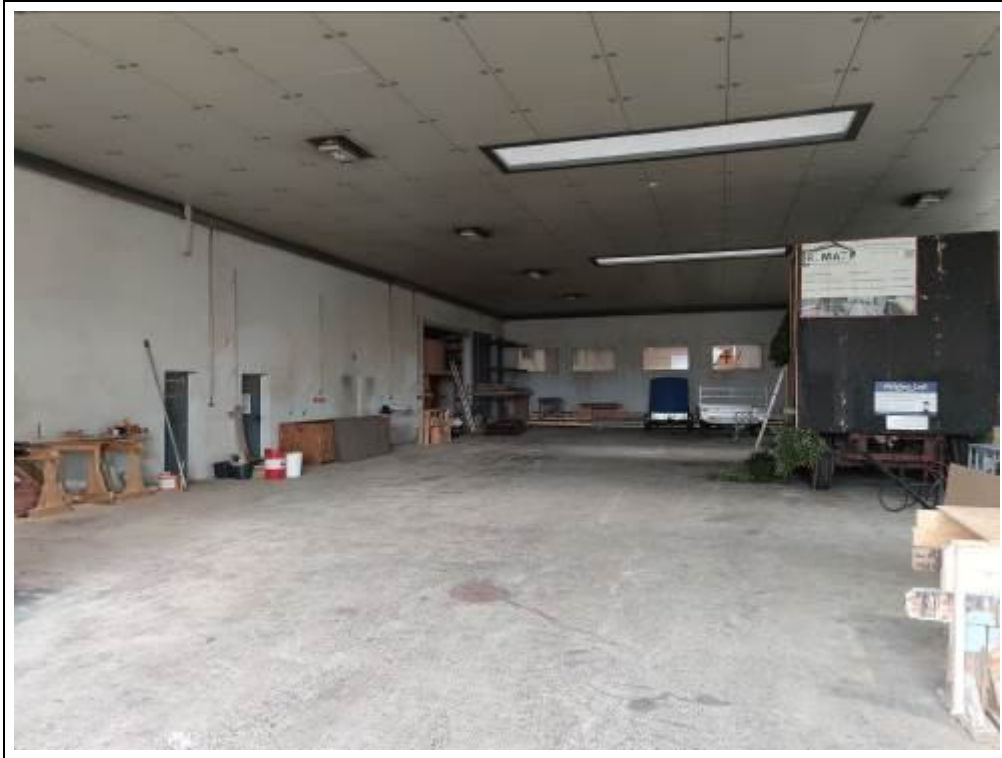
Blick in die Werk- und Lagerhalle Bauabschnitt I
