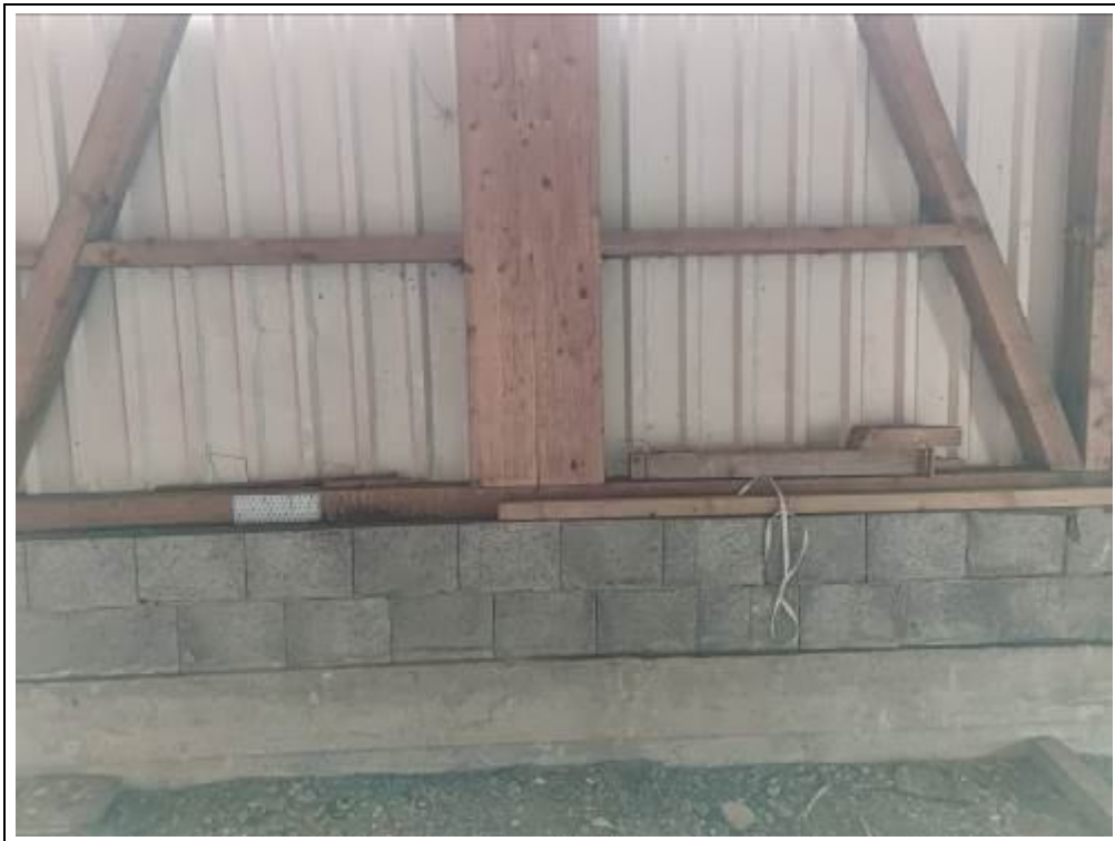
Blick auf die Konstruktion des Anbaus im Sockelbereich
