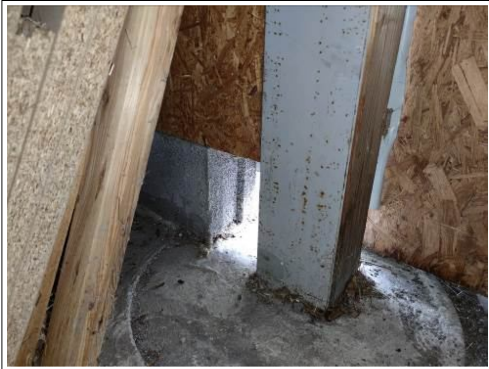
Blick auf die Ausführung im Fundamentbereich
