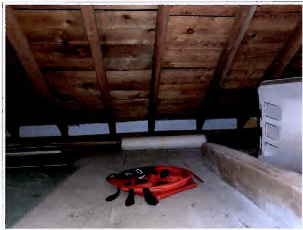
Blick in das Dachgeschoss
