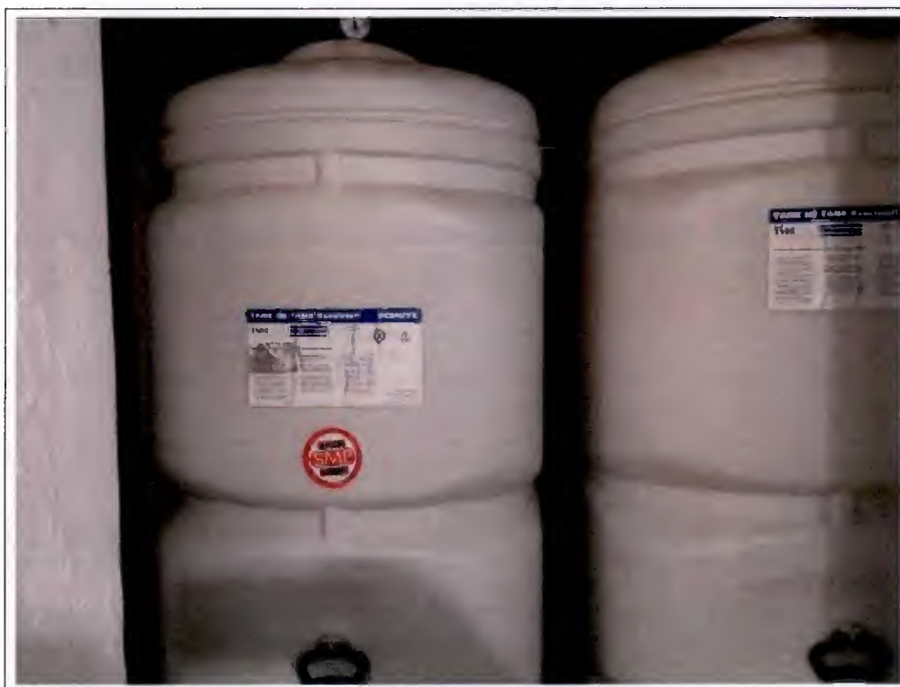
Blick in den Tankraum
