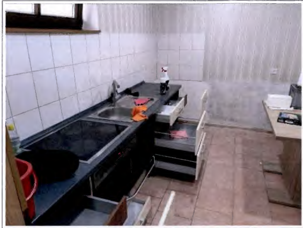
Blick in die Küche im Kellergeschoss
