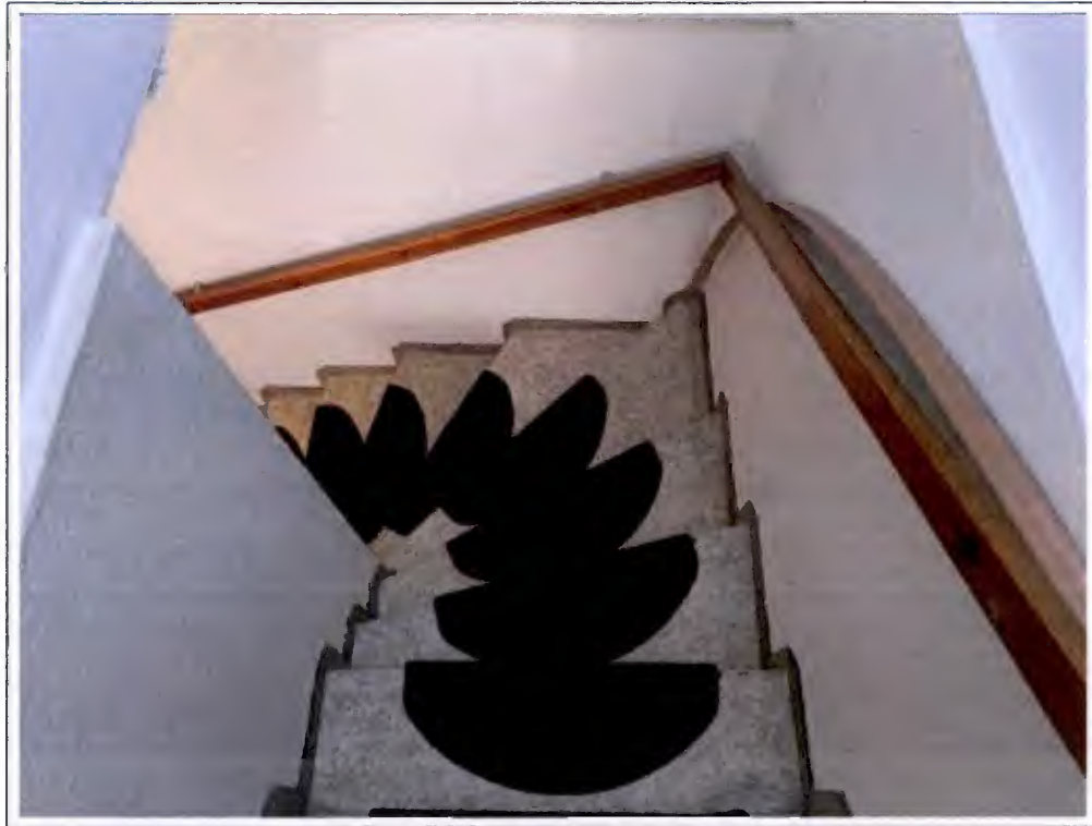
Blick auf die Kellertreppe
