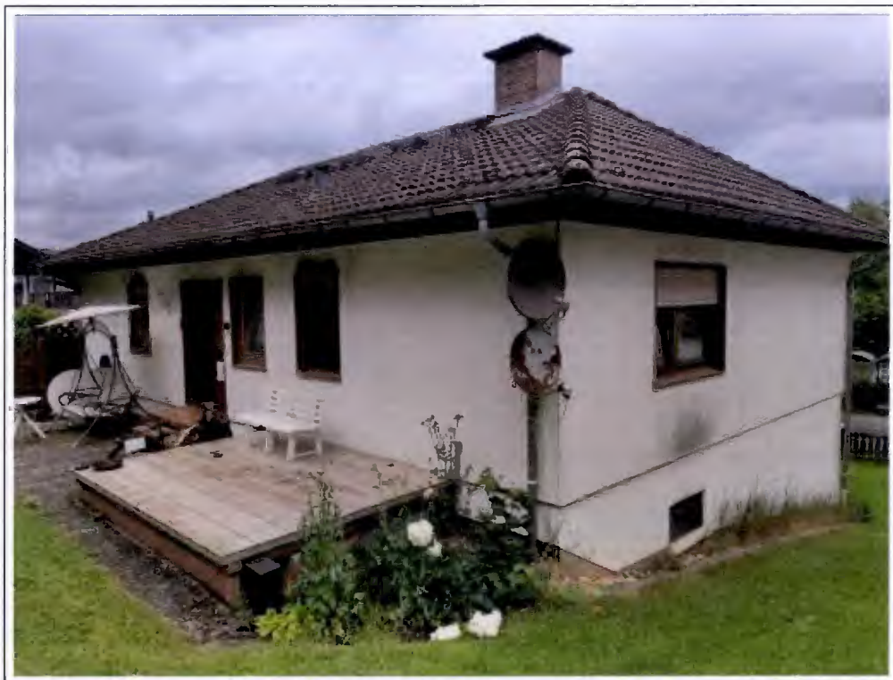
Blick auf das Bewertungsobjekt von Südwesten
