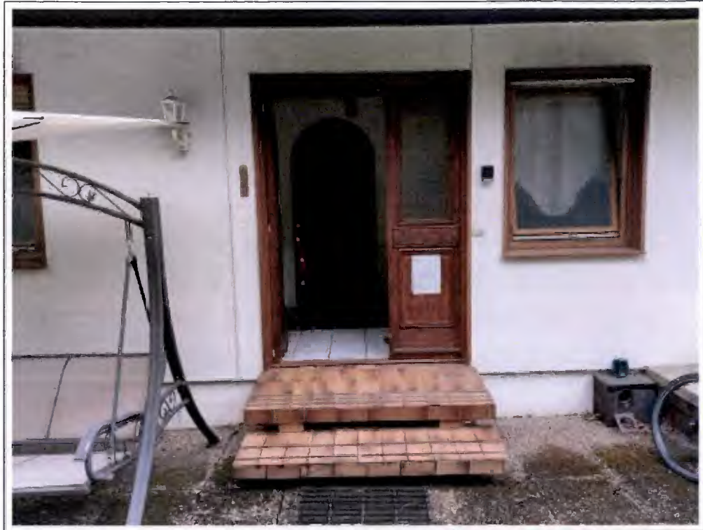
Blick auf den Hauseingangsbereich
