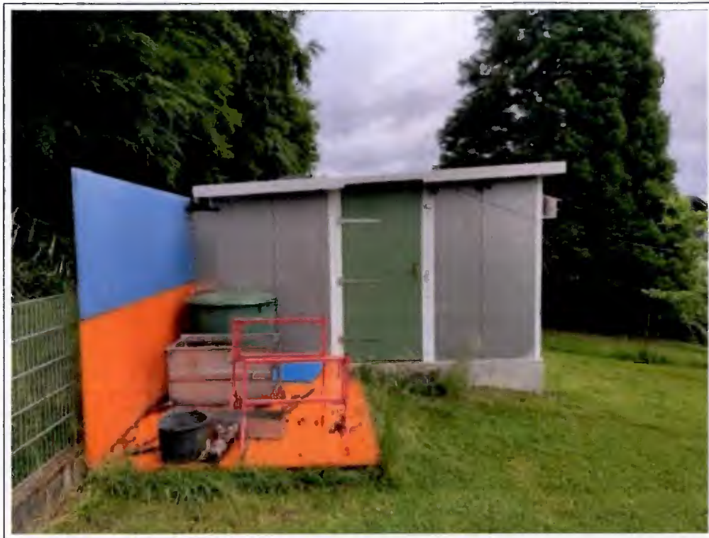
Blick auf ein Gartengerätehaus in der nordwestlichen Grundstücksecke, Nutzung als kleine Werkstatt
