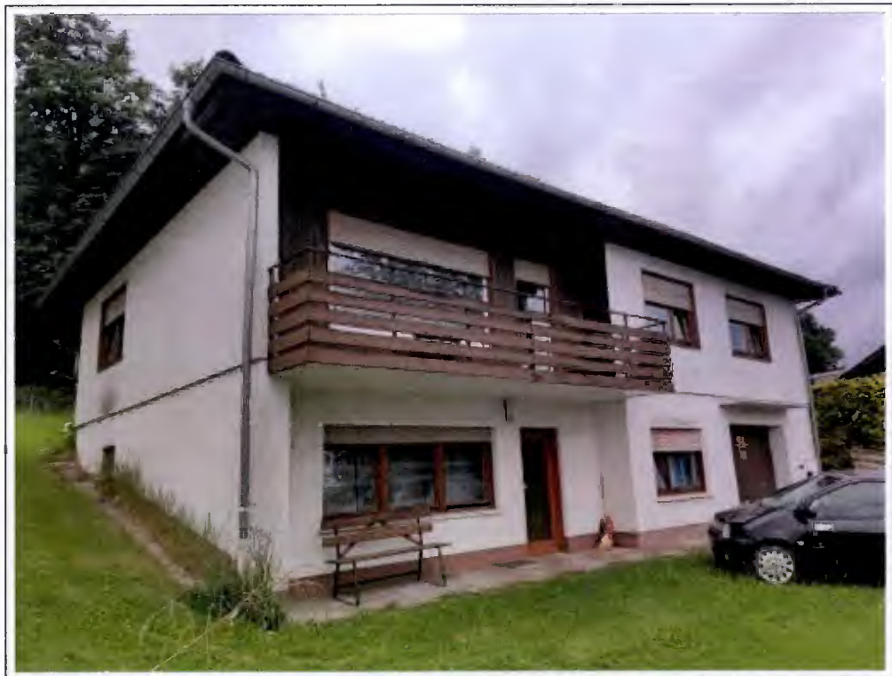
Blick auf das Bewertungsobjekt von Südosten
