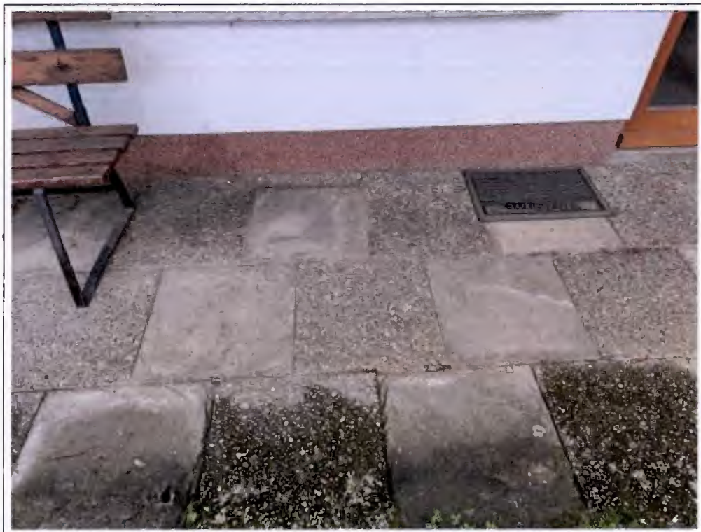
Blick auf die Befestigung der Terrasse im Kellergeschoss
