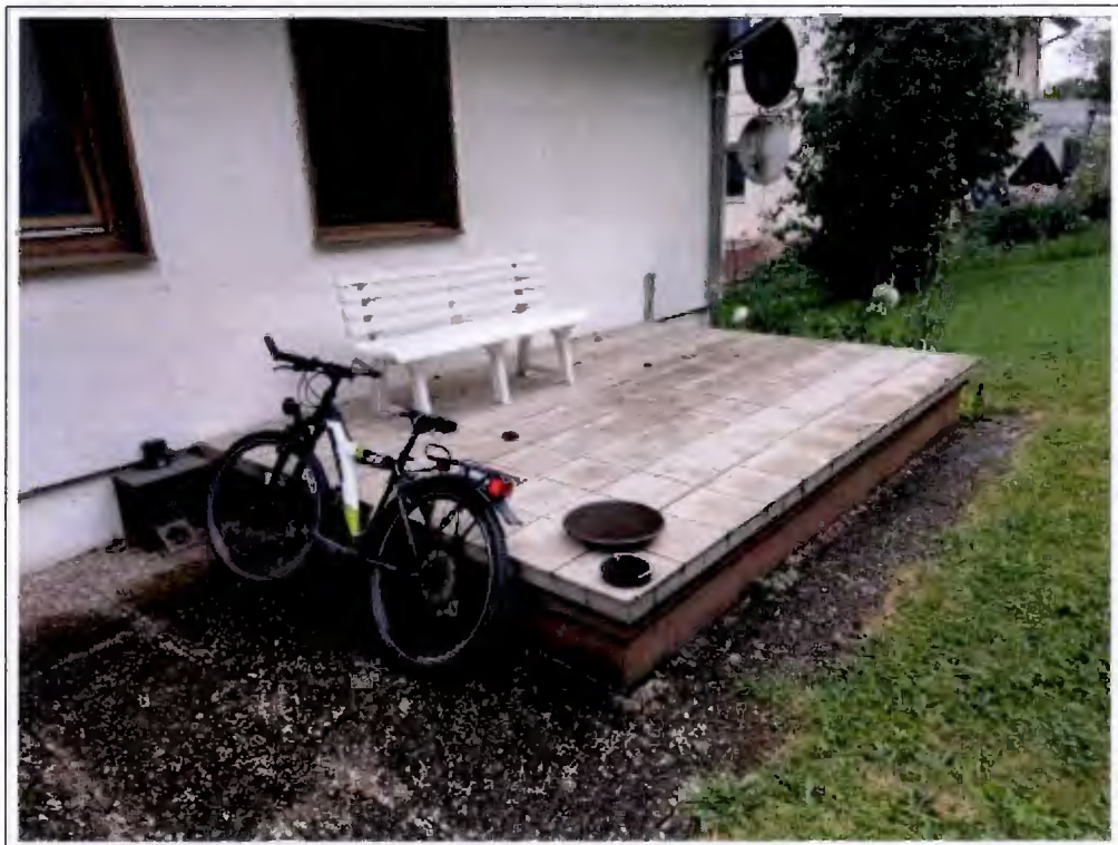
Blick auf die Terrasse über dem zusätzlichen Keller (Tankraum)
