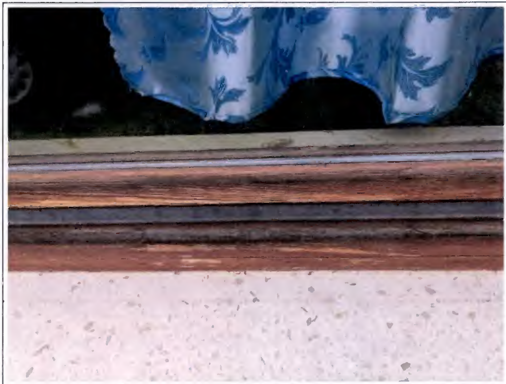
Blick auf den Zustand der Holzfenster
