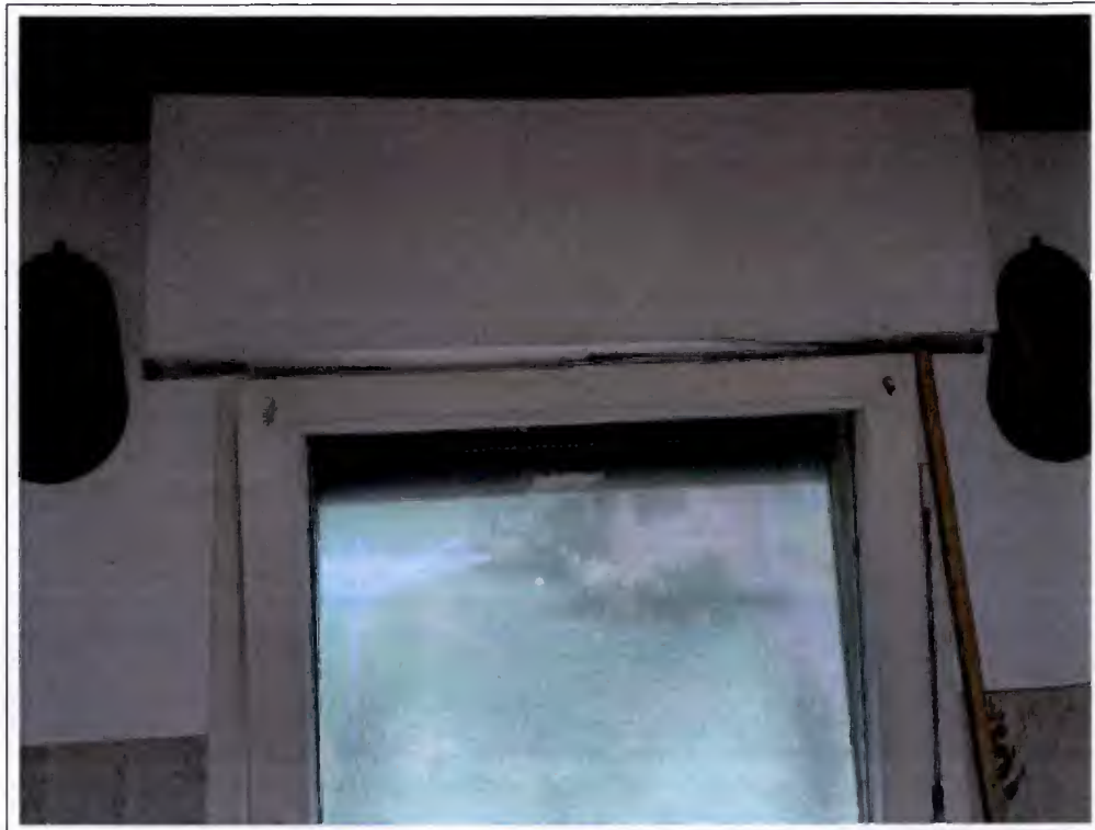
Blick gegen einen nach innen aufgesetzten Rolladenkasten
