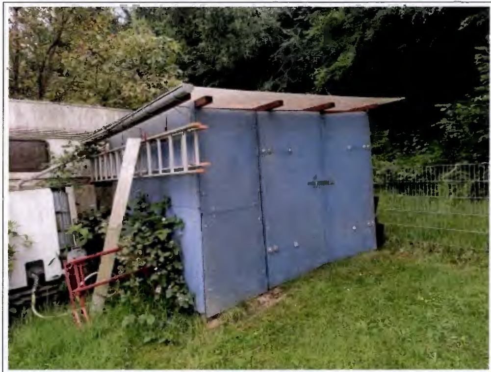
Blick auf das Gartengerätehaus in der südwestlichen Grundstücksecke, Nutzung für Gartengeräte
