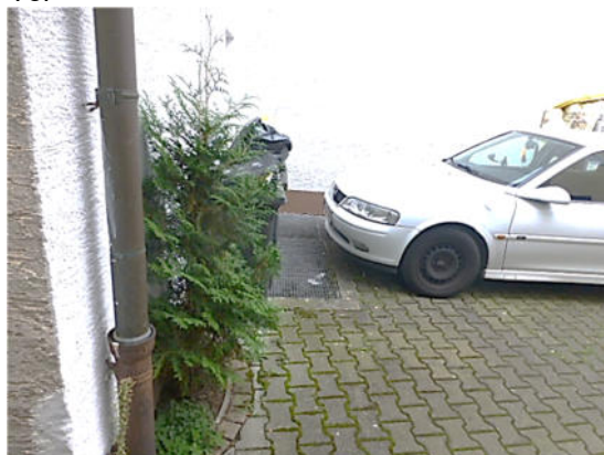
Beet, Fallrohr, Lichtschächte
