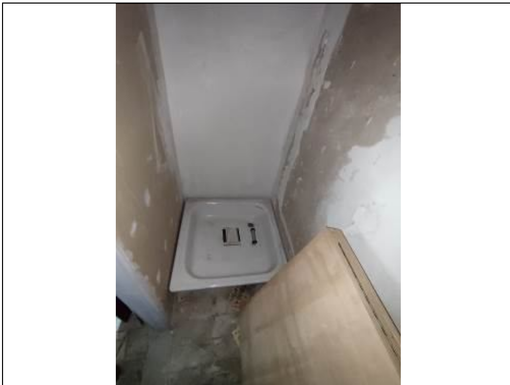
Blick in die Dusche/WC im Apartment im Obergeschoss
