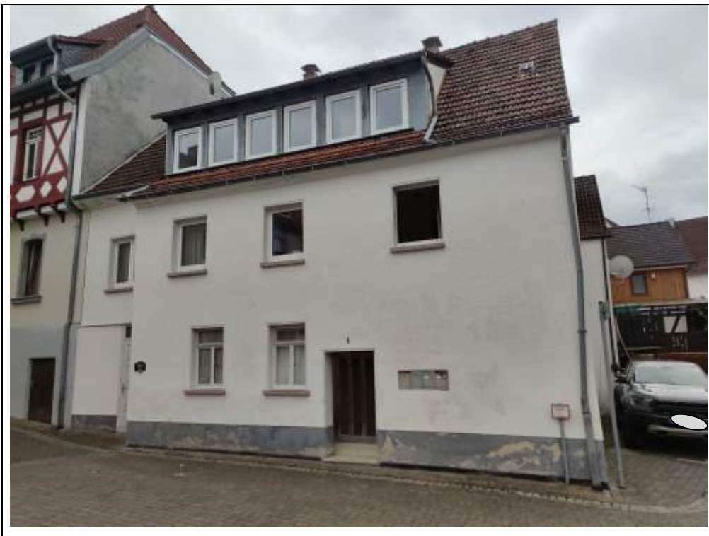
Blick auf das Bewertungsobjekt von Norden
