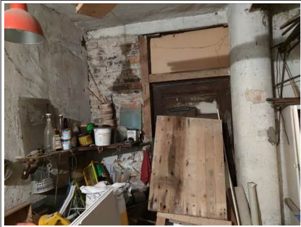
Blick in die ehemalige Spenglerwerkstatt im Erdgeschoss
