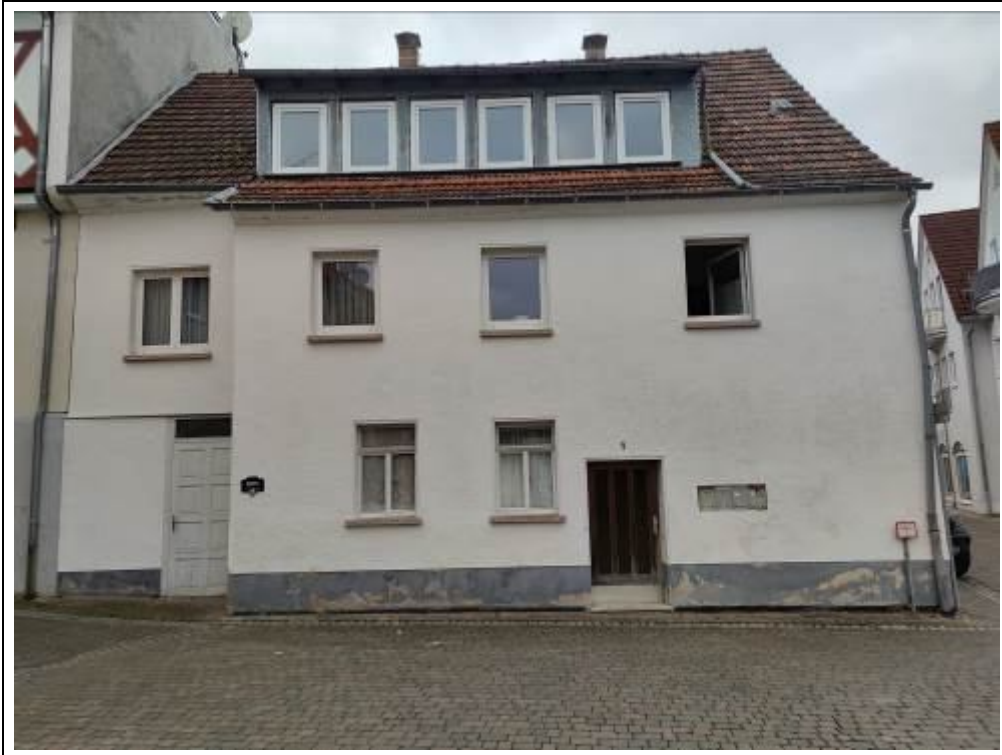
Blick auf das Bewertungsobjekt von Norden
