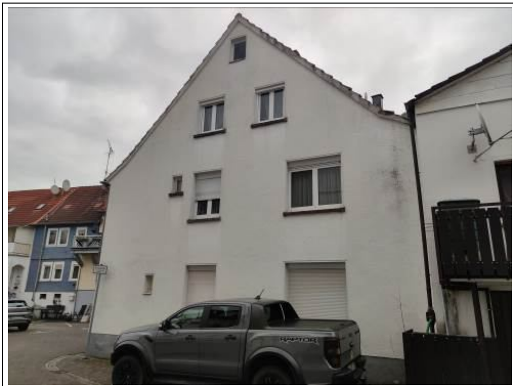
Blick auf das Bewertungsobjekt von Südwesten
