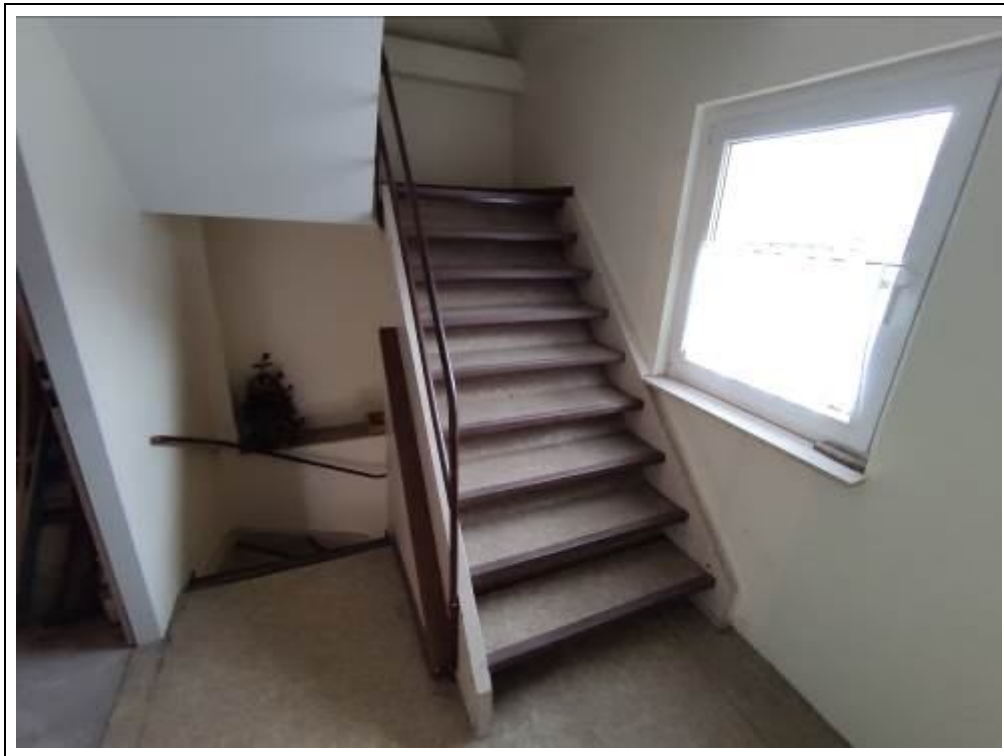
Blick auf die Treppe zum Dachgeschoss
