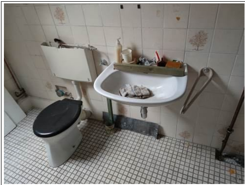
Blick in das Bad im Dachgeschoss
