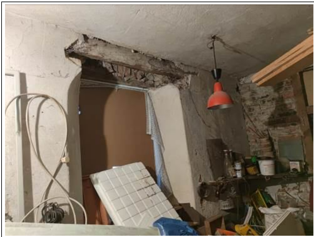
Blick in die ehemalige Spenglerwerkstatt im Erdgeschoss
