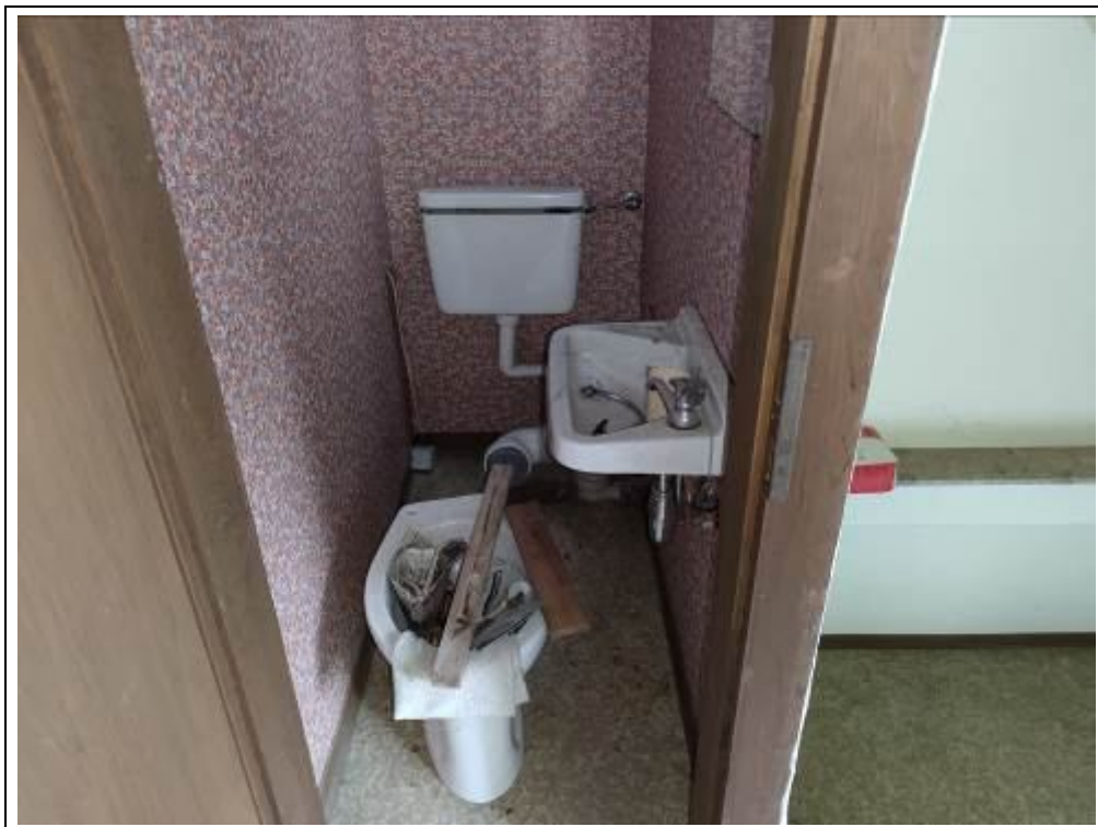
Blick in das WC im Treppenhaus im Dachgeschoss
