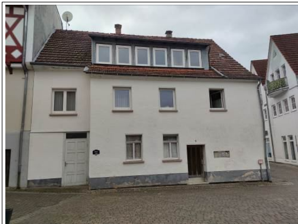
Blick auf das Bewertungsobjekt von Norden
