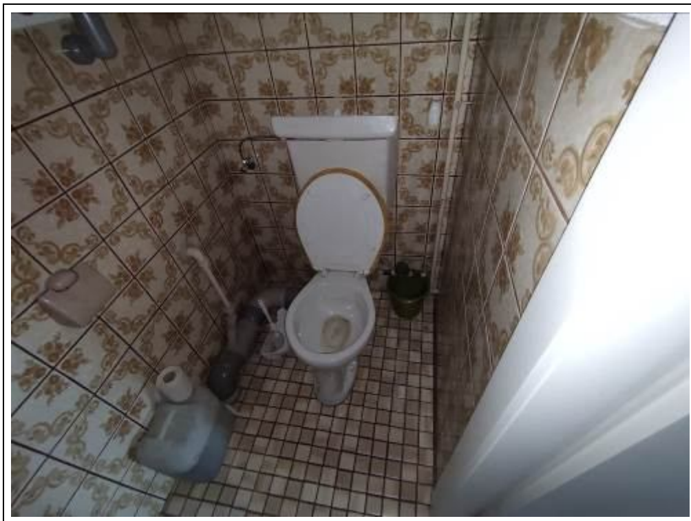
Blick in die Dusche im Obergeschoss
