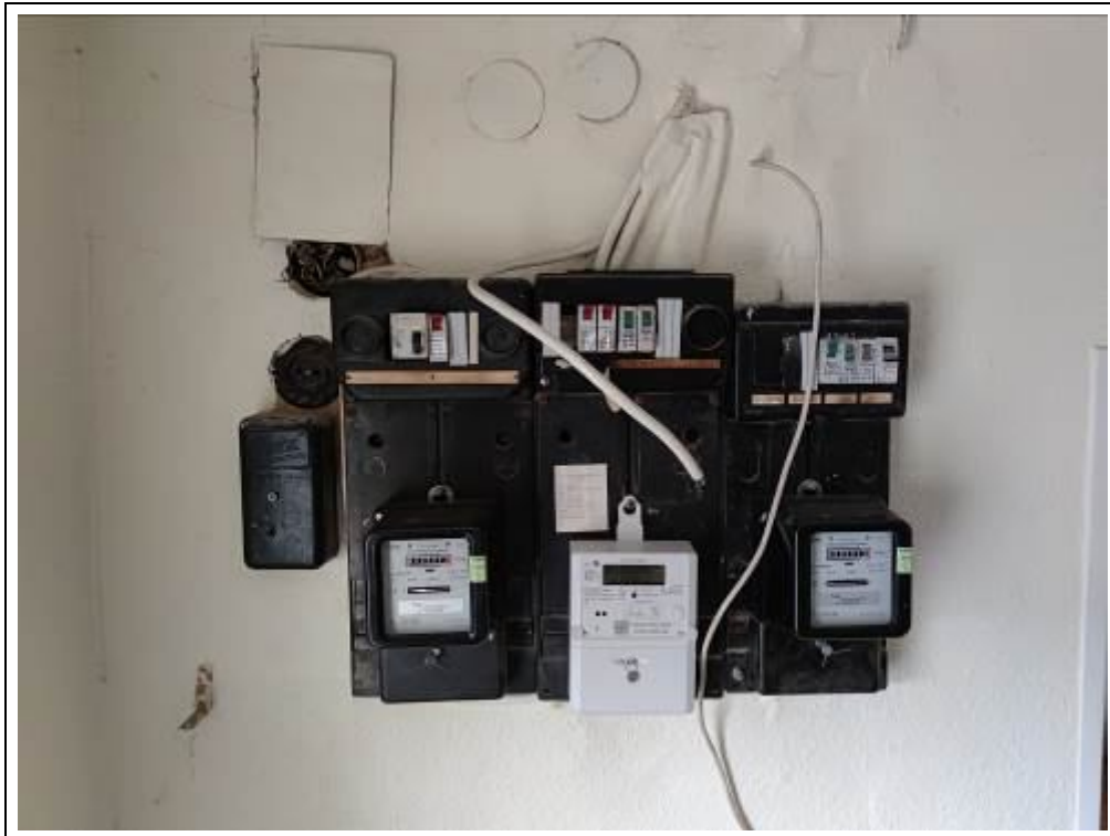
Blick auf den Zustand der Elektroinstallation
