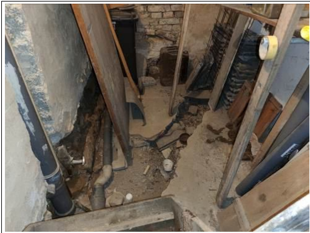
Blick in den Kellerraum im Erdgeschoss
