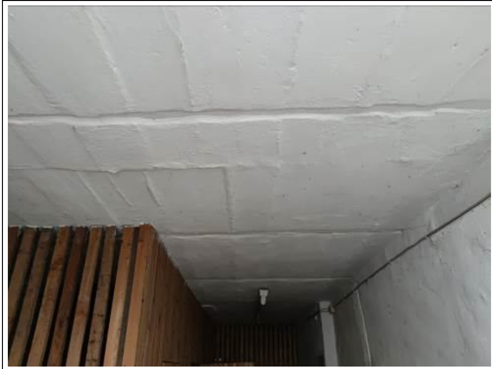
Blick gegen die Decke im Lager- Kellerraum
