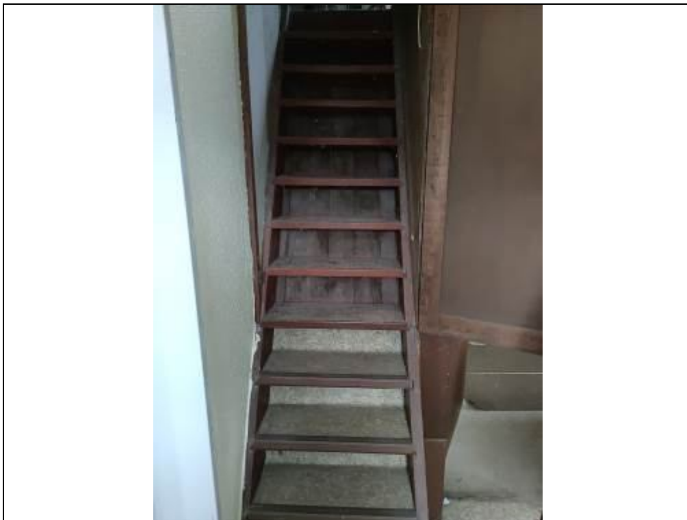
Blick auf die Treppe zum Spitzboden
