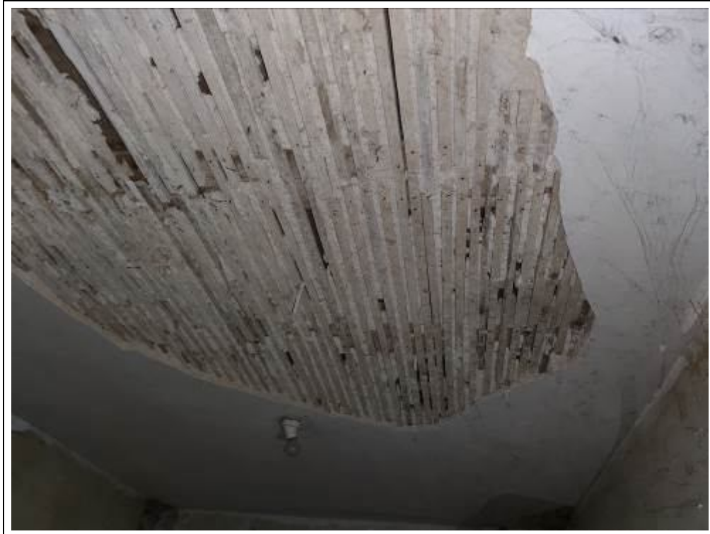
Blick gegen die Decke im Erdgeschoss
