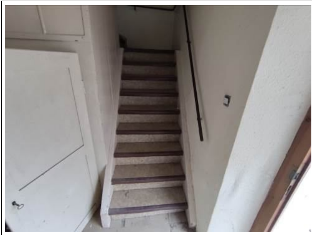
Blick auf die Treppe zum Obergeschoss
