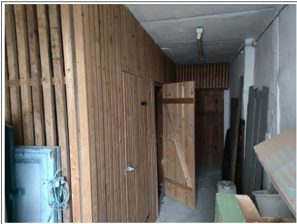
Blick in den Kellerraum
