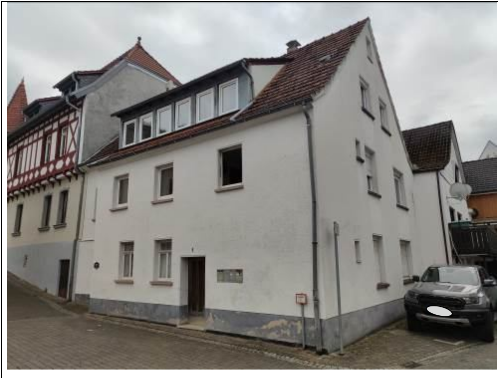
Blick auf das Bewertungsobjekt von Nordwesten
