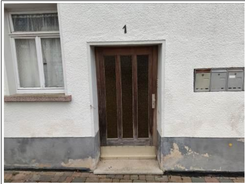
Blick auf die Hauseingangstüre
