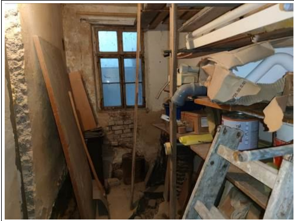
Blick in den Kellerraum im Erdgeschoss
