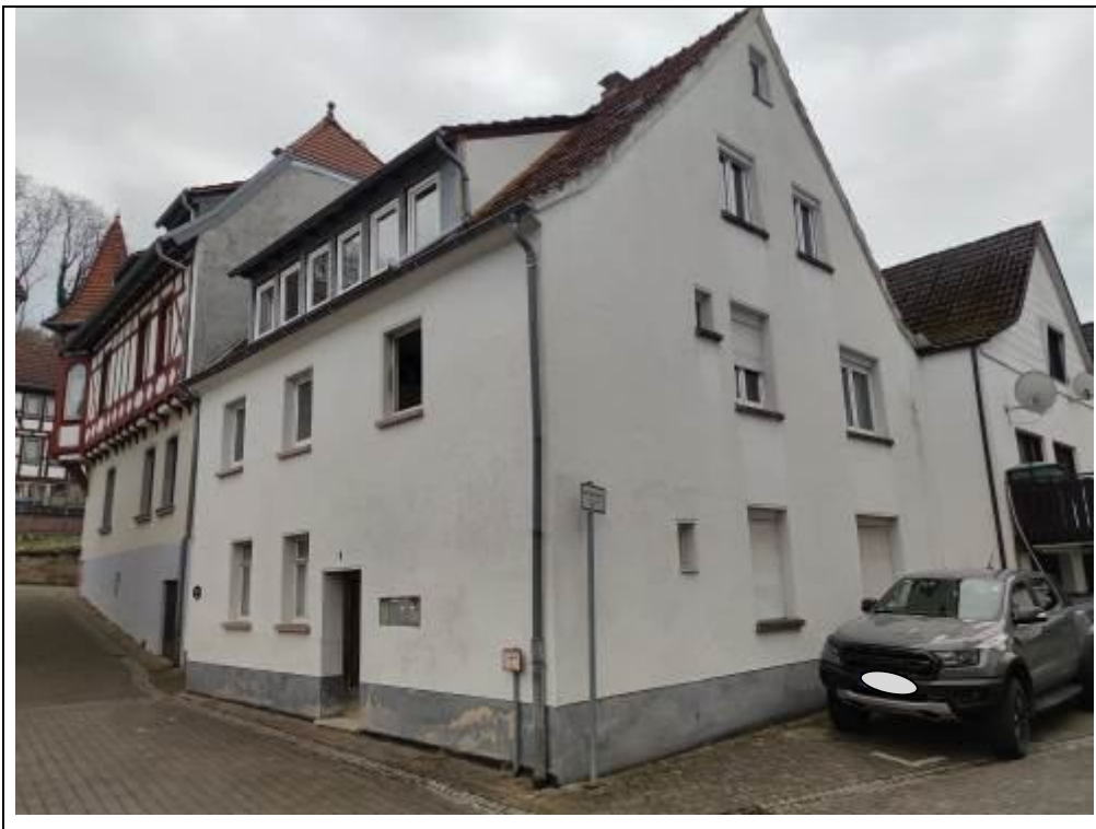
Blick auf das Bewertungsobjekt von Nordwesten
