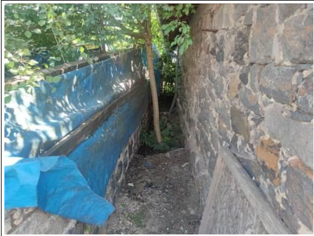
Blick in den Grenzbereich zwischen Flurstück 24/1 und 23/1
