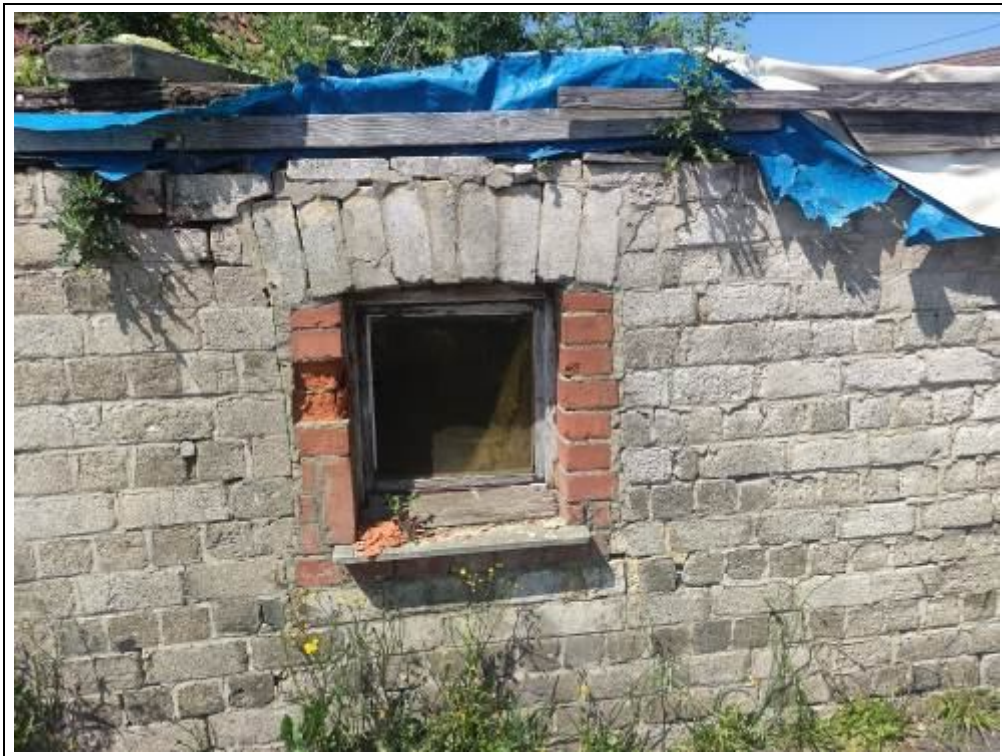
Blick auf ein Holzfenster
