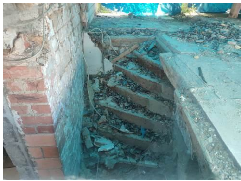
Blick auf die Kellertreppe
