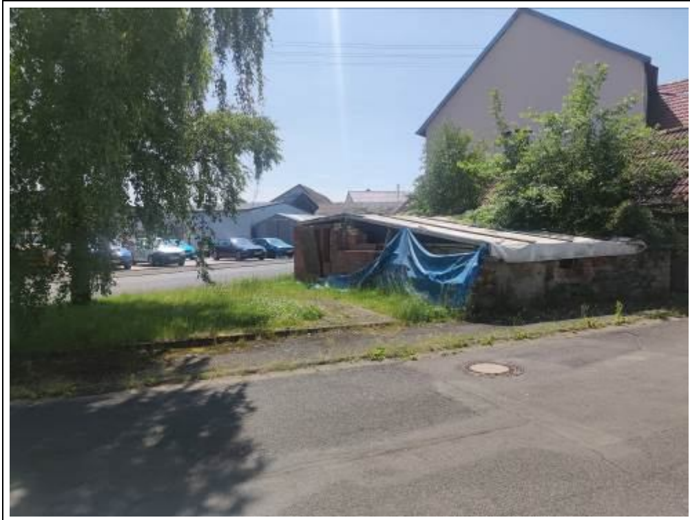
Blick auf das Bewertungsobjekt von Nordosten
