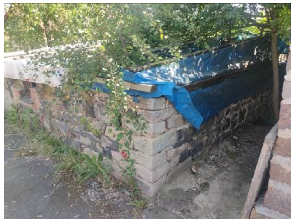
Blick auf das Bewertungsobjekt von Nordwesten
