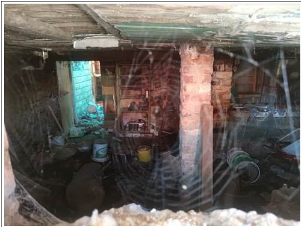
Blick in einen Kellerraum
