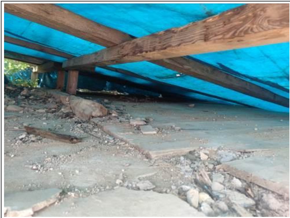
Blick unter die Notüberdachung aus Balken und Folie
