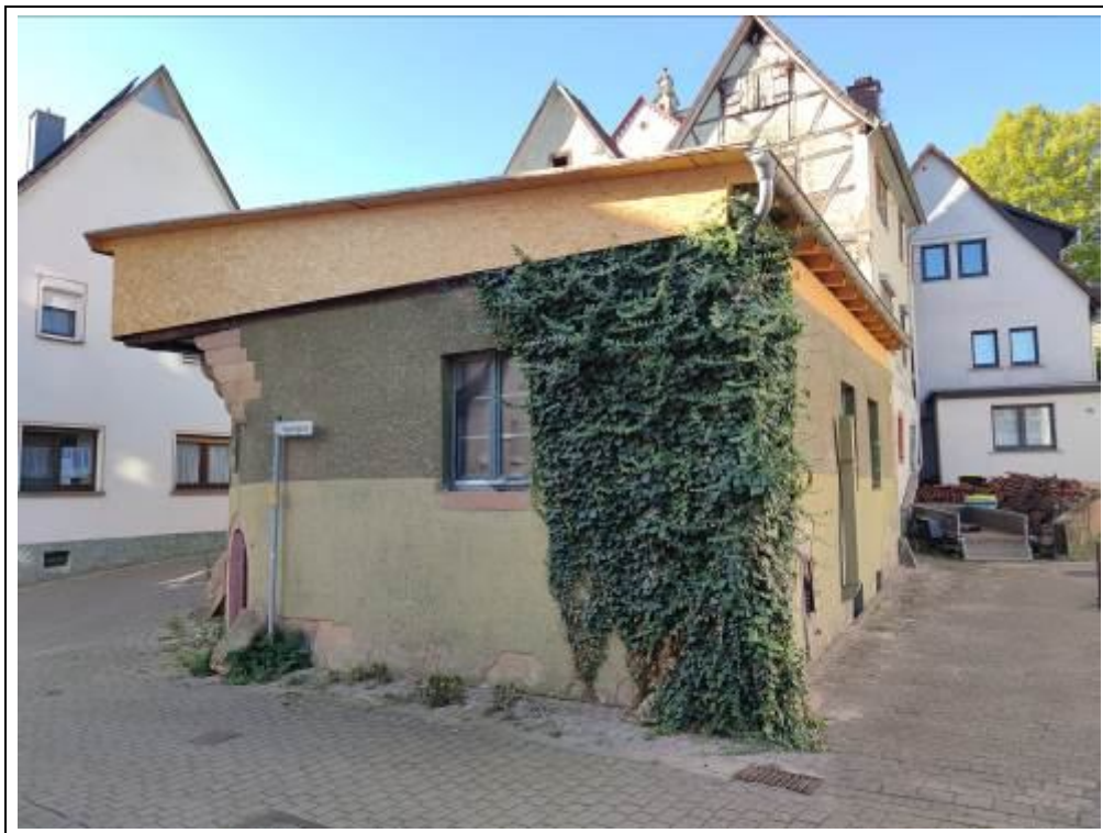
Blick auf das Bewertungsobjekt von Norden
