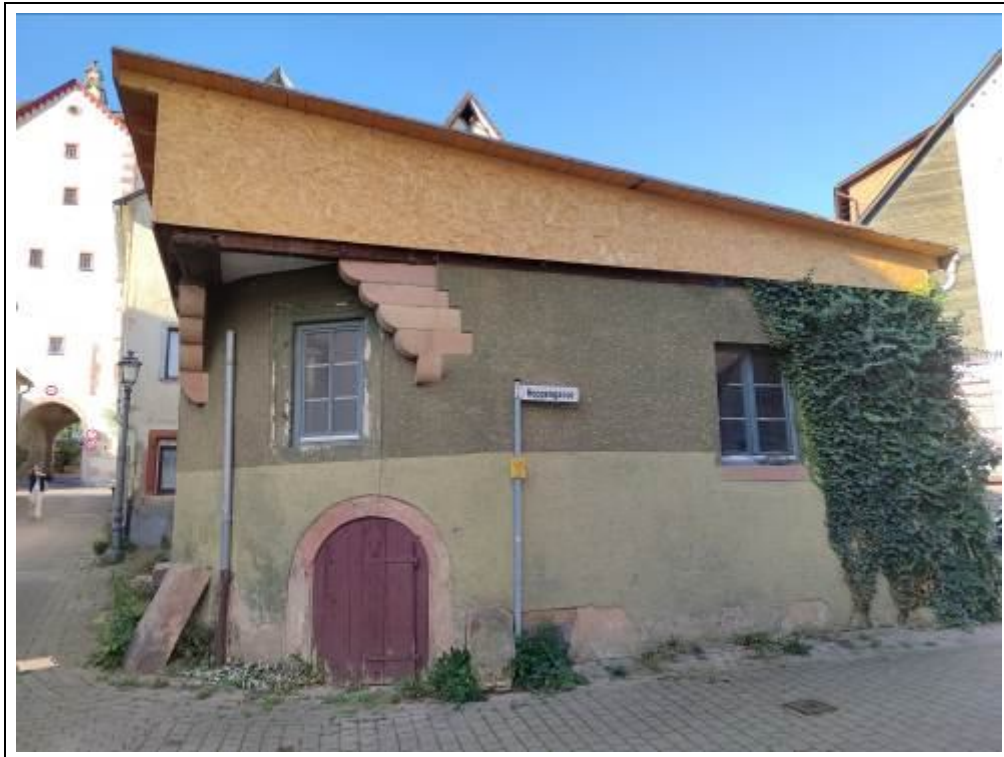
Blick auf das Bewertungsobjekt von Nordosten
