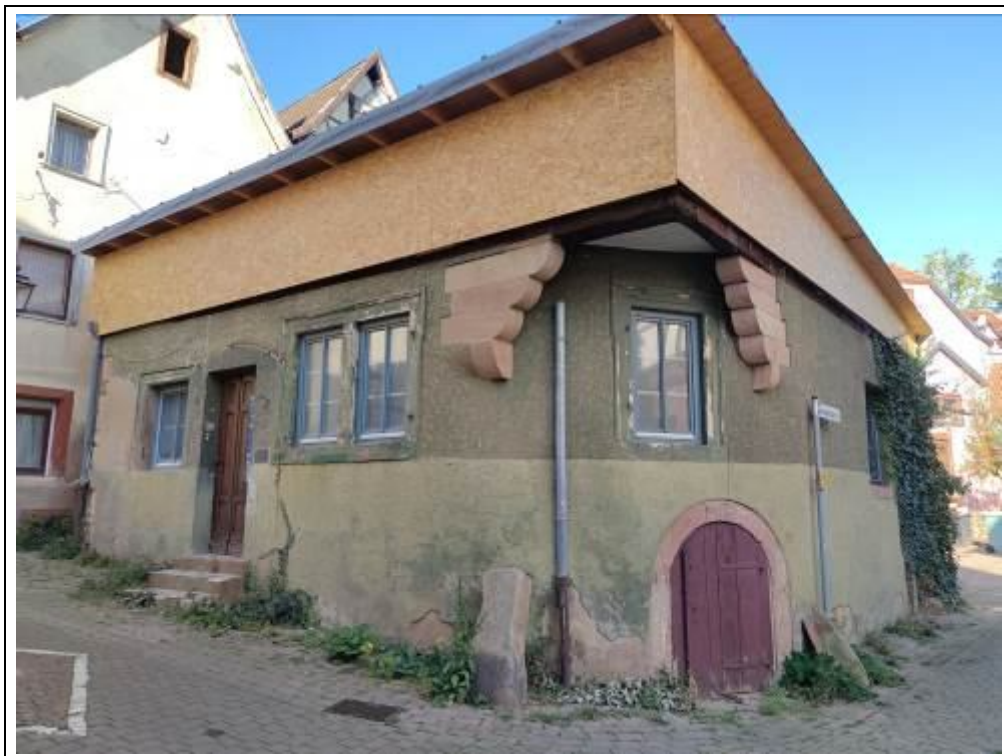
Blick auf das Bewertungsobjekt von Südosten
