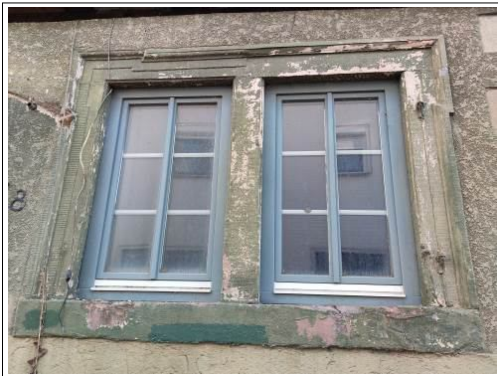
Blick auf die Holzfenster mit Sandsteingewände
