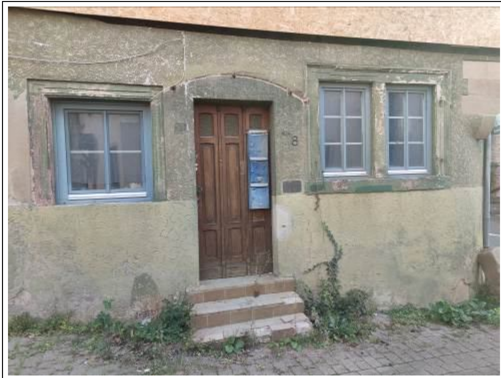
Blick auf den Hauseingang
