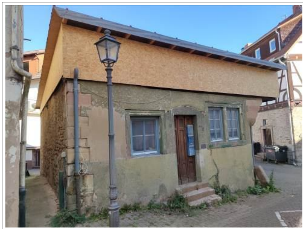
Blick auf das Bewertungsobjekt von Süden
