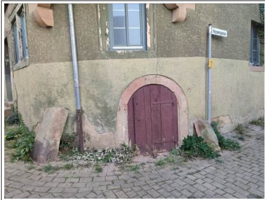
Blick auf das Bewertungsobjekt von Osten (Kellerzugang)
