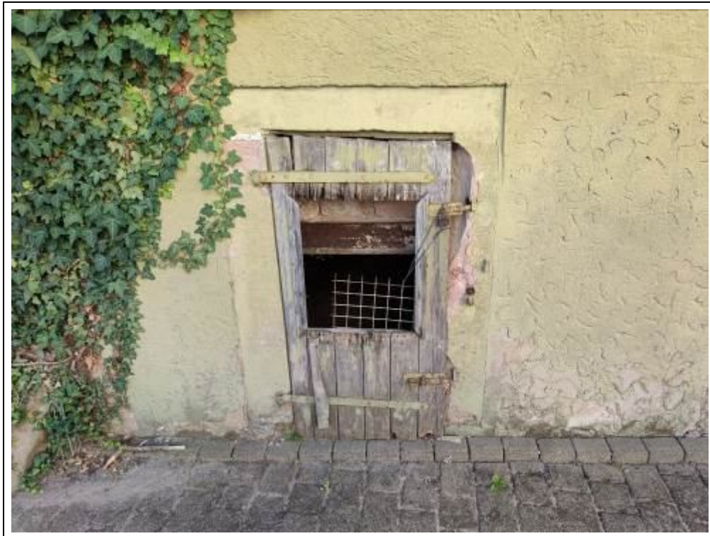
Blick auf eine Zugangsluke zu einem Keller
