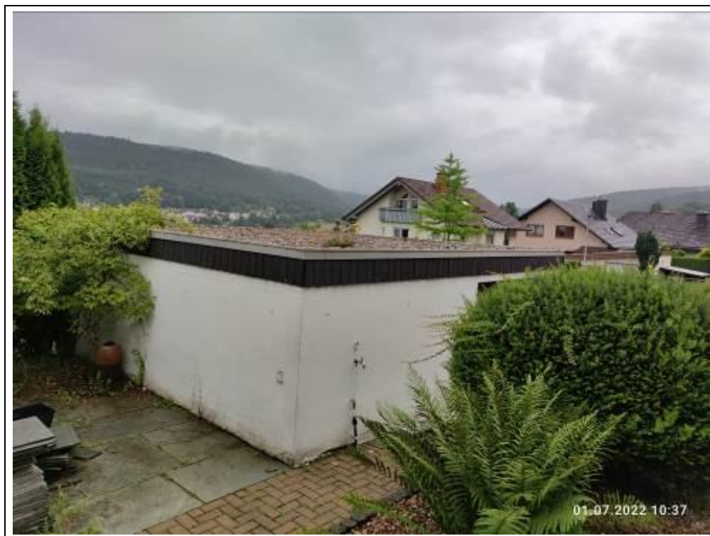
Blick auf die Garage von Nordwesten
