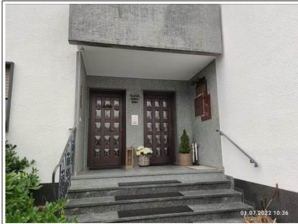
Blick auf den Hauseingangsbereich
