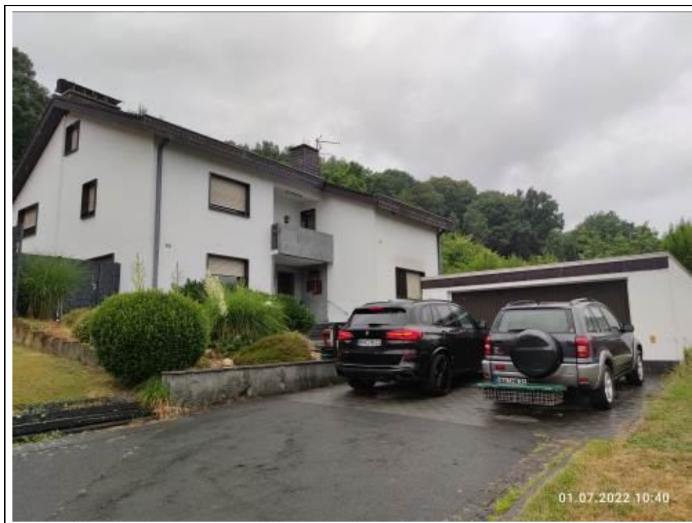
Blick auf die Garage von Südosten
