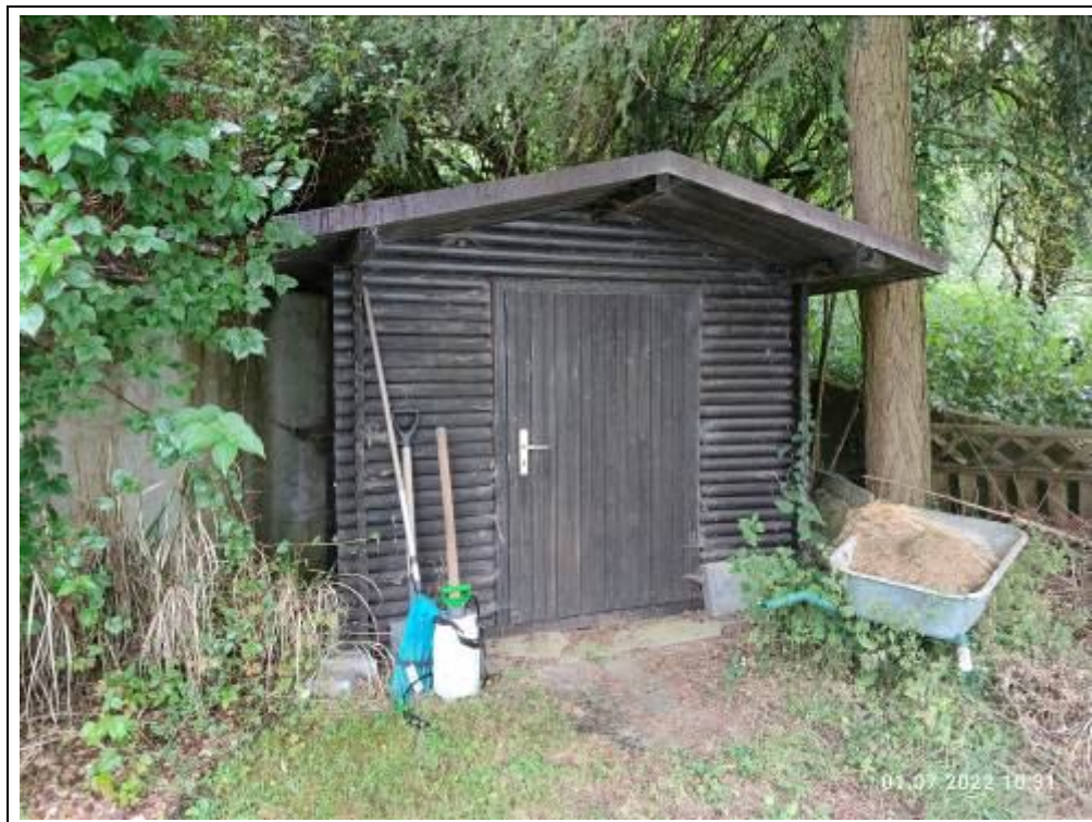
Blick auf die Gartengerätehütte
