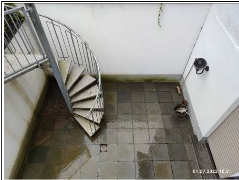
Blick in den Innenhof / Terrasse des Kellergeschosses (Ausgang von der Sauna/Hobbyraum)
