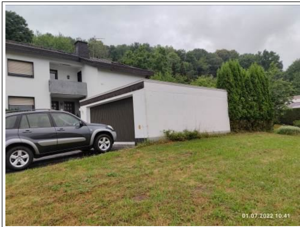
Blick auf die Garage von Osten
