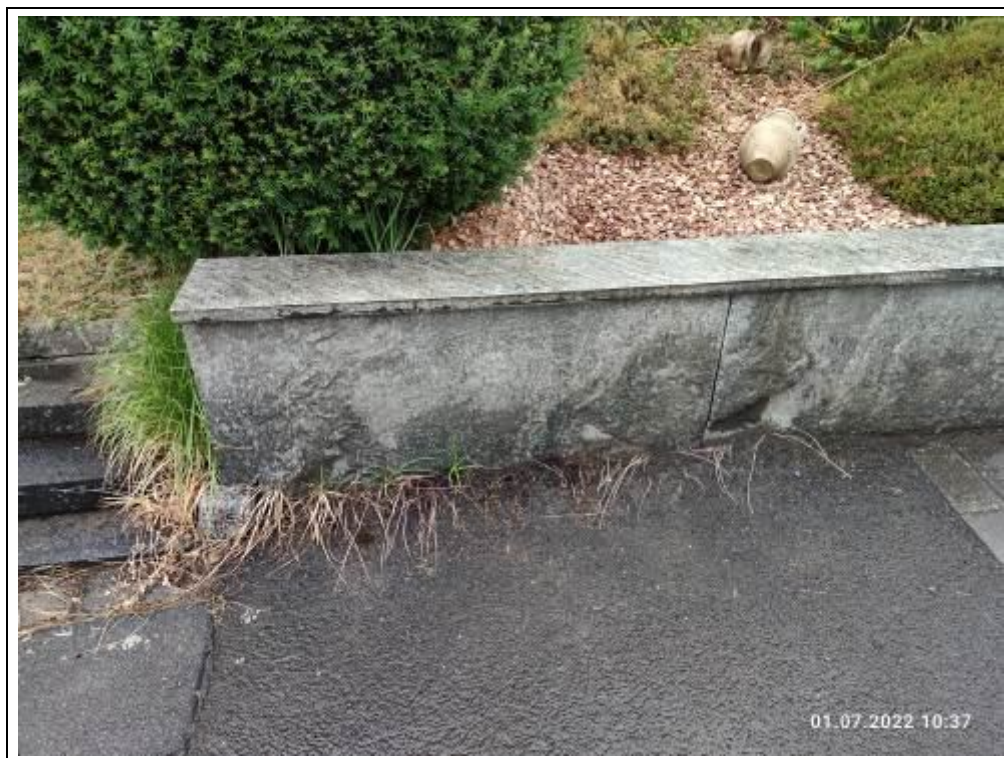
Blick auf eine kleine Abfangungsmauer (mit Granit verkleidet)
