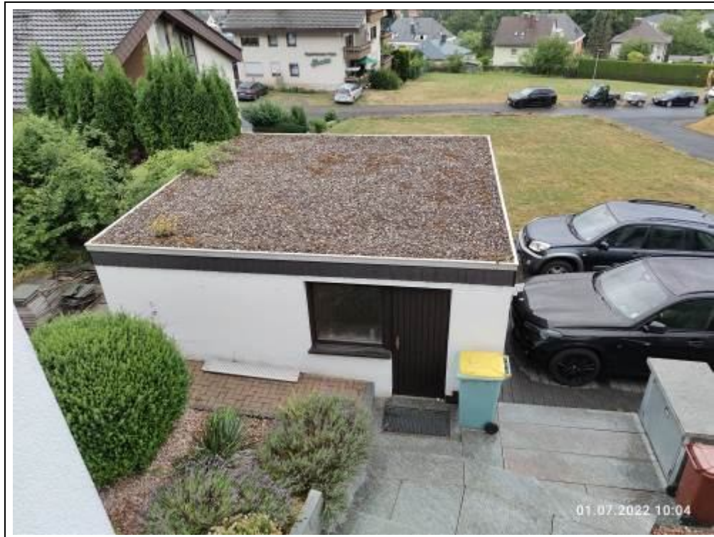
Blick auf die Garage vom Balkon im Obergeschoss
