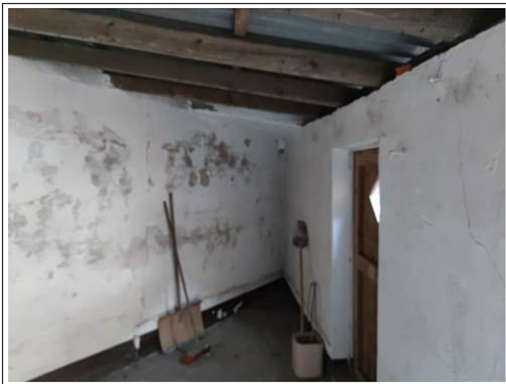
Blick in die Garage
