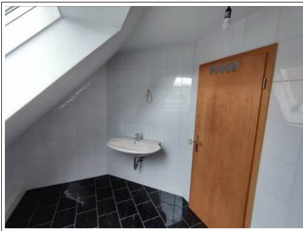
Blick in die Dusche im Dachgeschoss
