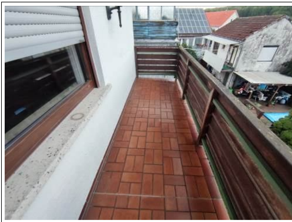
Blick auf den Balkon im Obergeschoss
