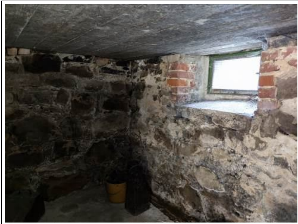
Blick in die nordwestliche Teilunterkellerung
