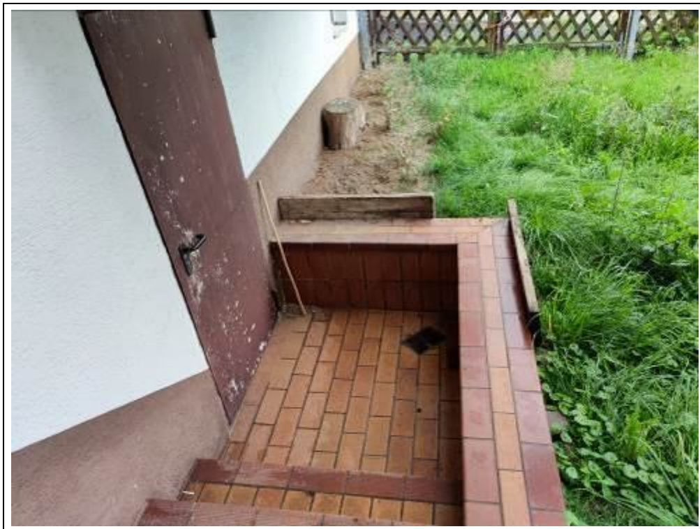
Blick auf den Abgang zur Teilunterkellerung mit Heiz- und Tankraum, befindet sich schon auf Flurstück 25
