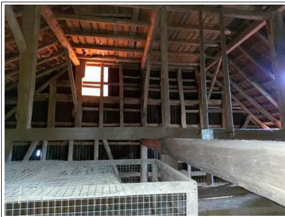
Blick in den Dachstuhlbereich der Scheune
