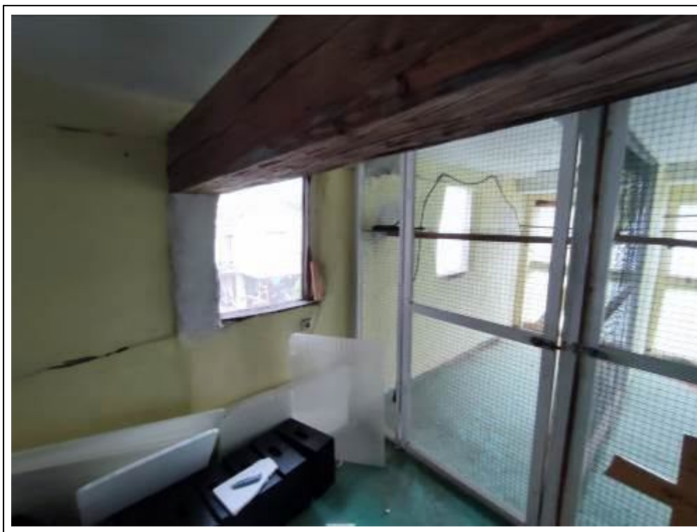
Blick in den Bereich oberhalb der Garage in der Scheune – als Voliere ausgebaut
