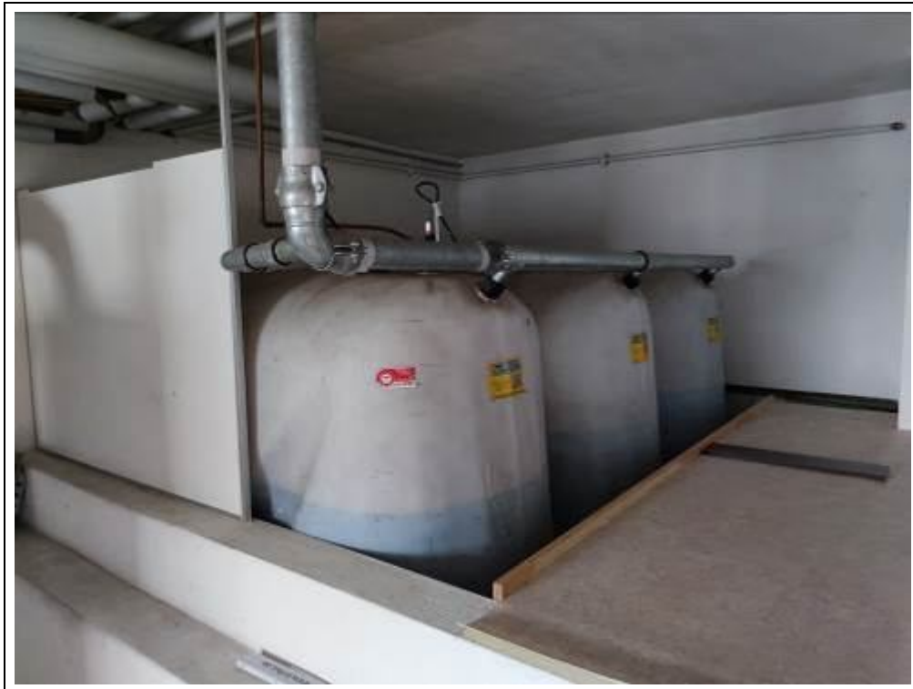
Blick in den abgetrennten Tankraum
