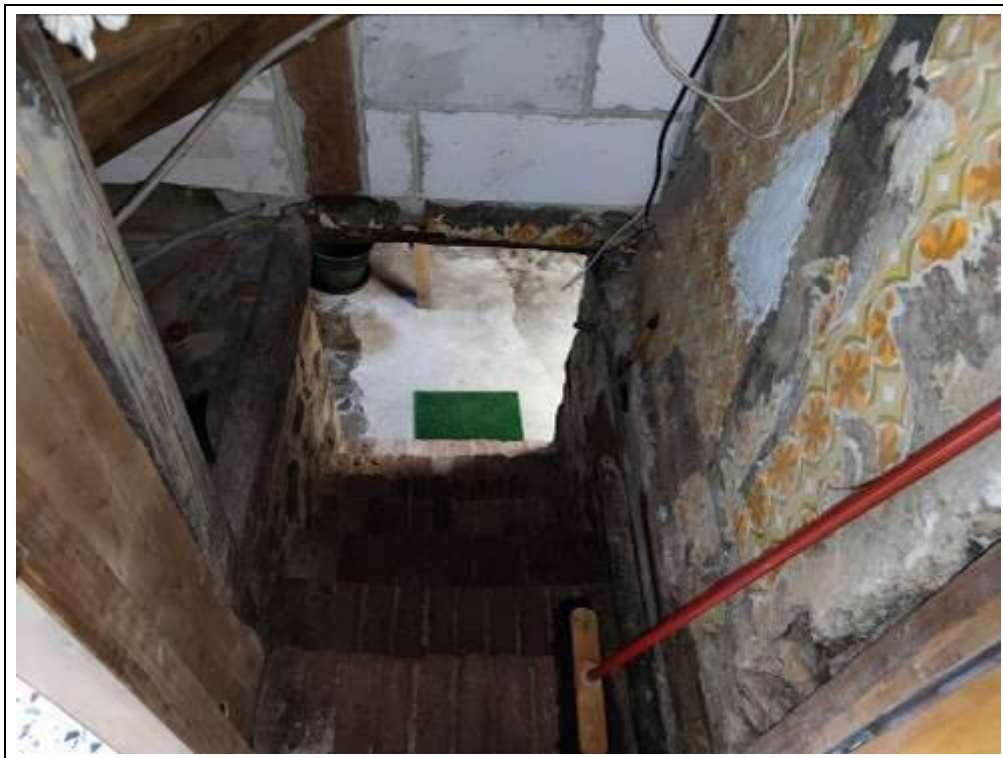
Blick auf Kellertreppe
