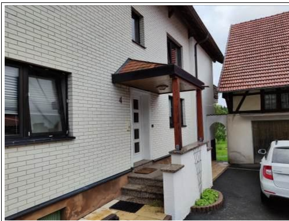
Blick auf den Hauseingang
