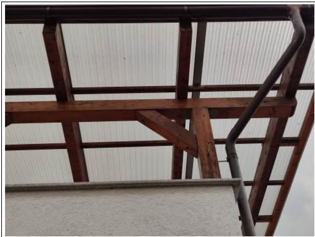
Blick gegen die Dachkonstruktion der Pergola über dem Balkon
