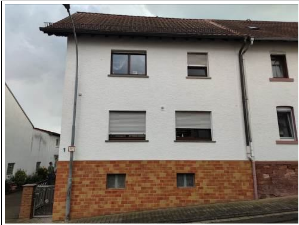
Blick auf das Bewertungsobjekt von Norden
