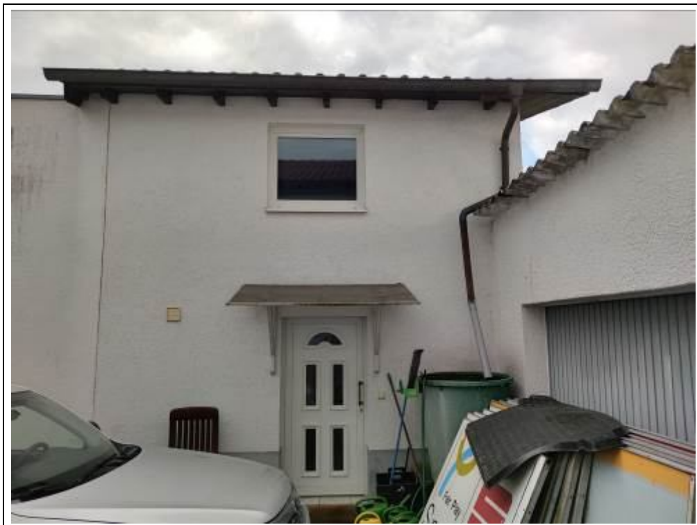
Blick auf das Bewertungsobjekt (Nebengebäude) von Westen
