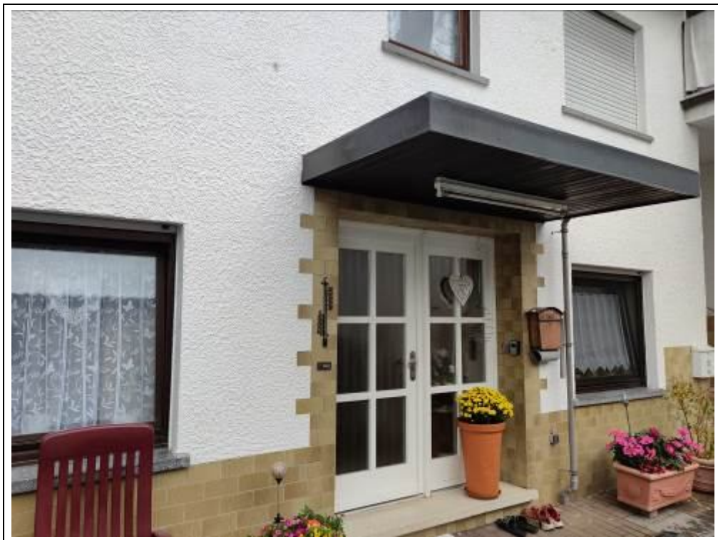
Blick auf den Hauseingang Tiergartenstraße 1A
