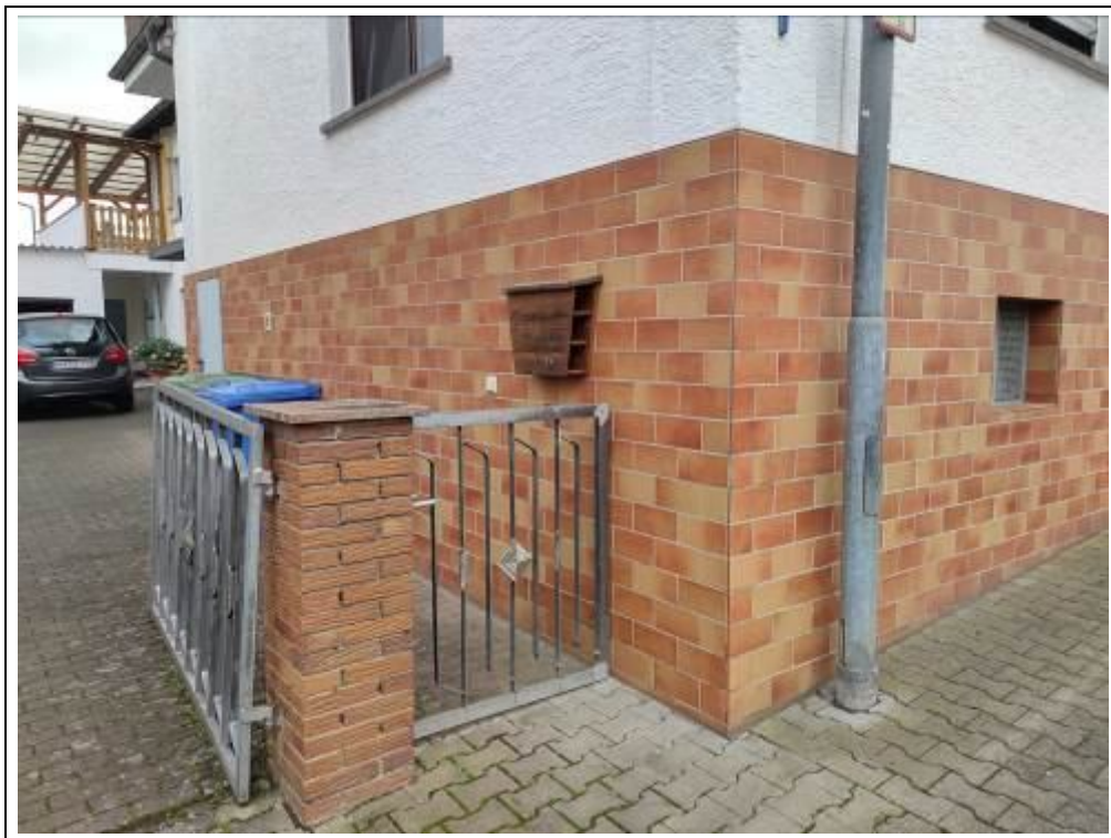
Blick auf den Zugang zum Grundstück und die Kellerverkleidung mit Fliesen
