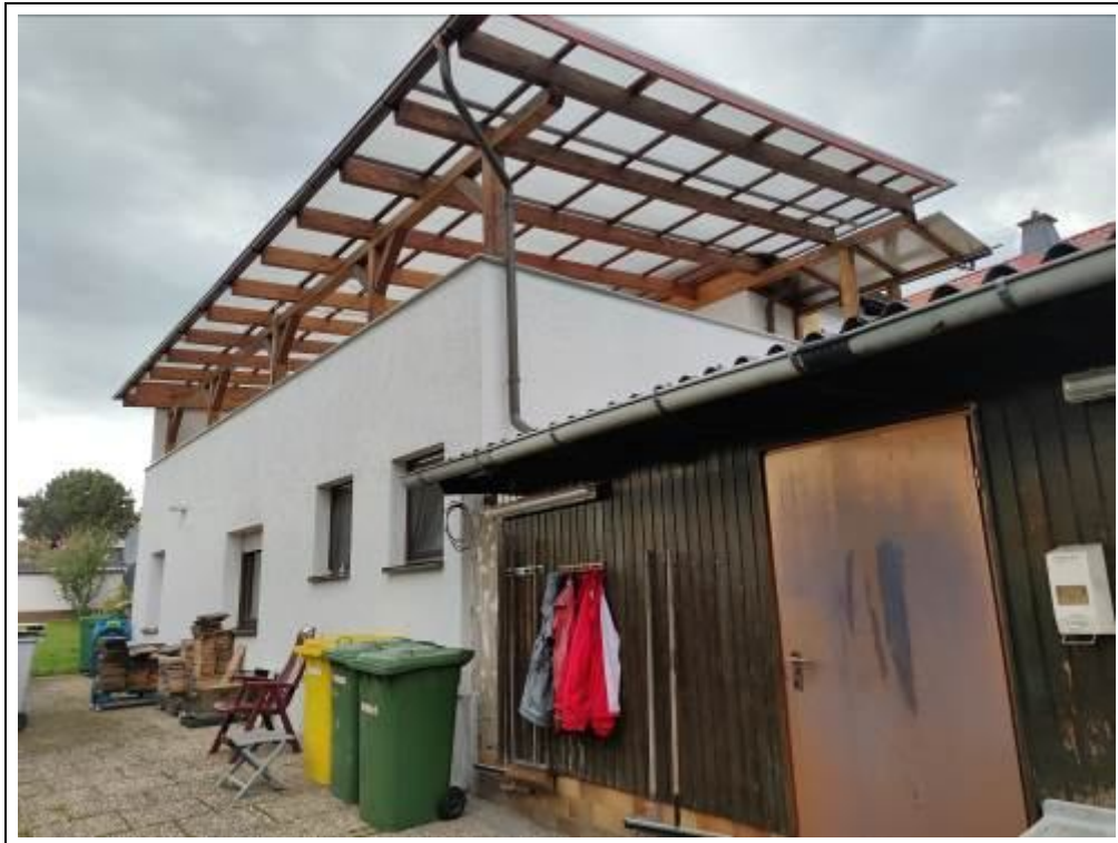
Blick auf das Bewertungsobjekt von Südosten
