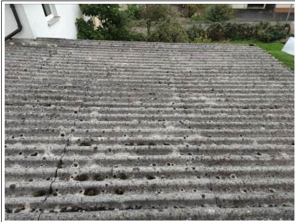
Blick auf die Dacheindeckung der Garage
