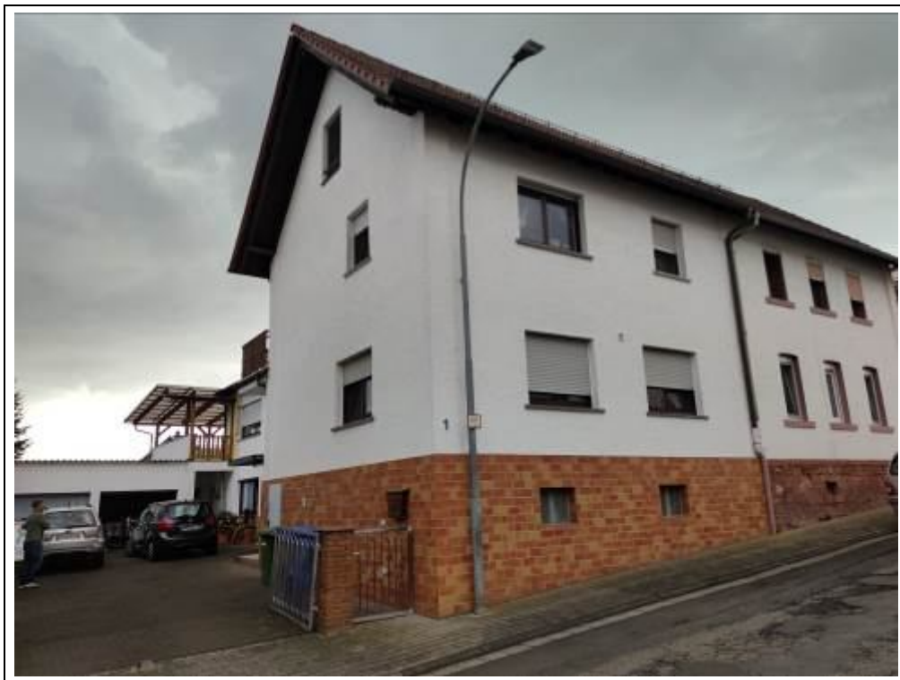
Blick auf das Bewertungsobjekt von Nordosten
