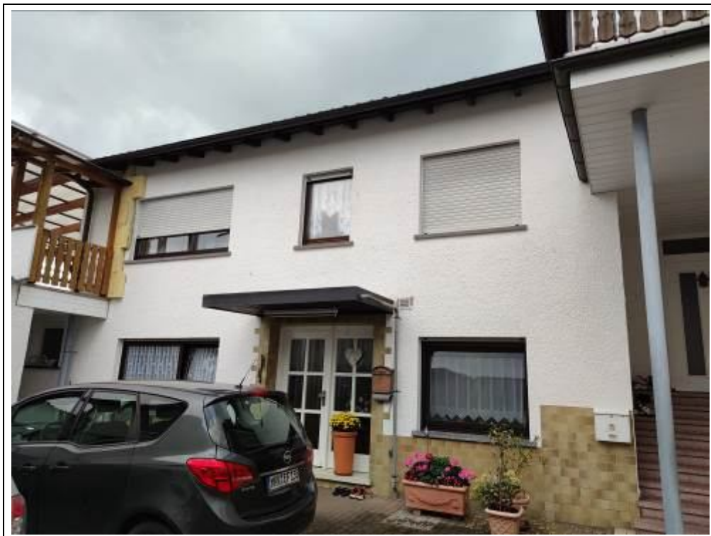
Blick auf das Bewertungsobjekt (Tergartenstraße 1A) von Nordosten (Teilansicht)
