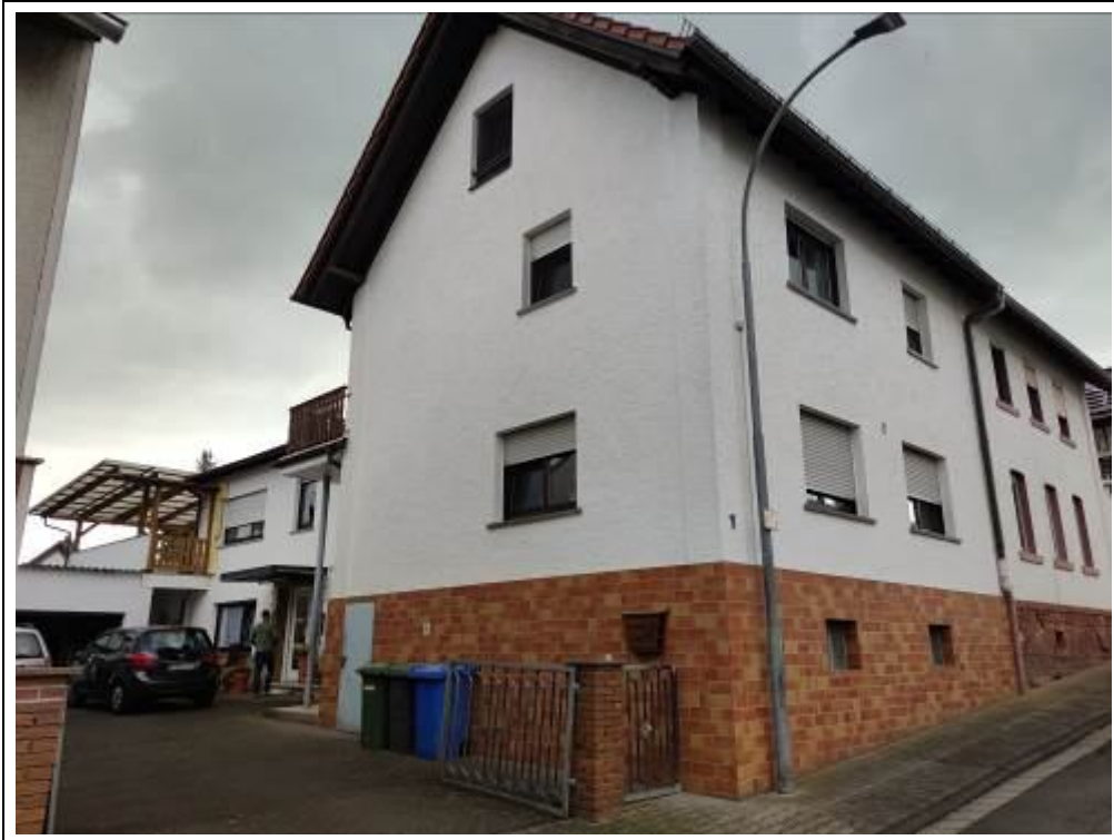
Blick auf das Bewertungsobjekt von Nordosten
