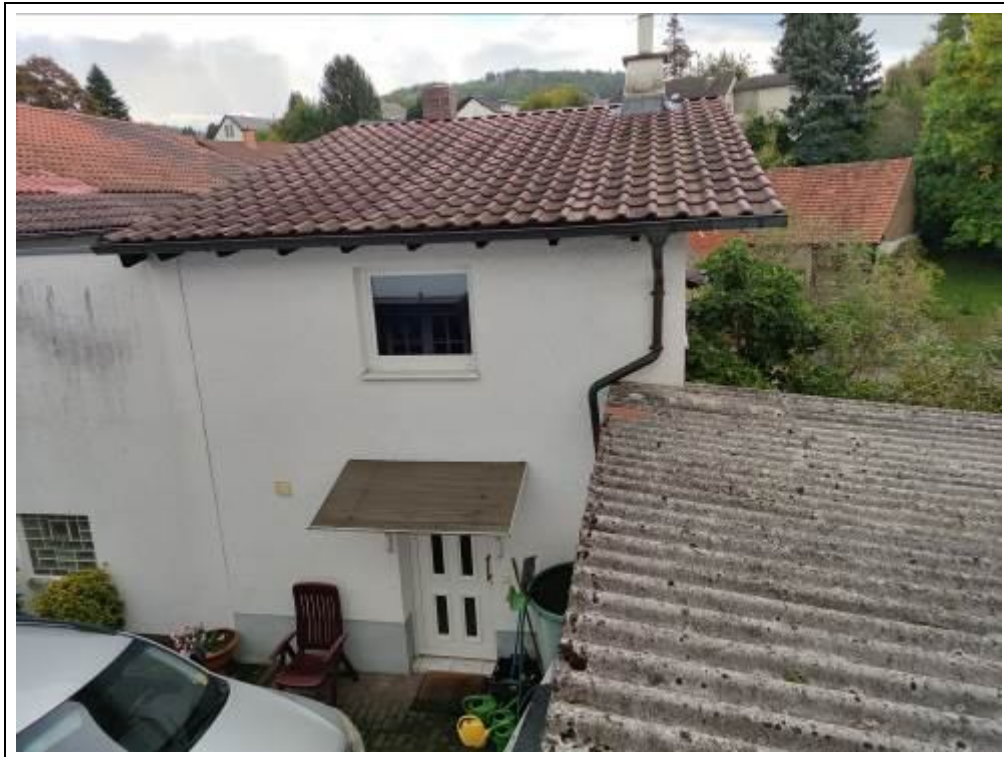
Blick auf das Bewertungsobjekt (Nebengebäude) von Westen
