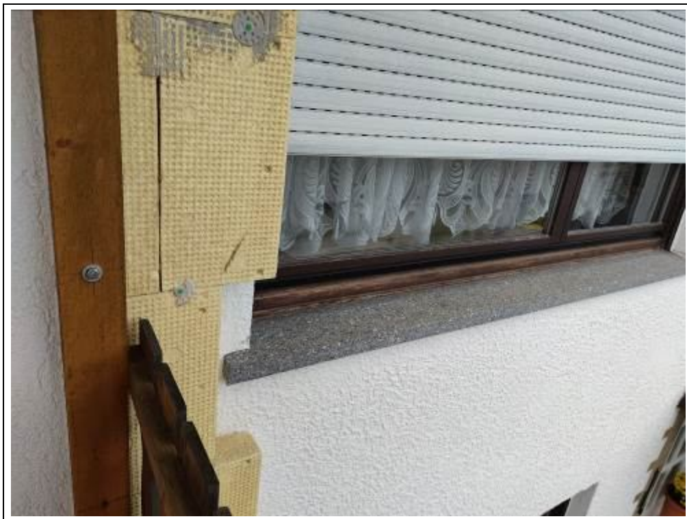
Blick auf begonnenes Vollwärmeverbundsystem (nur an Südseite angebracht)
