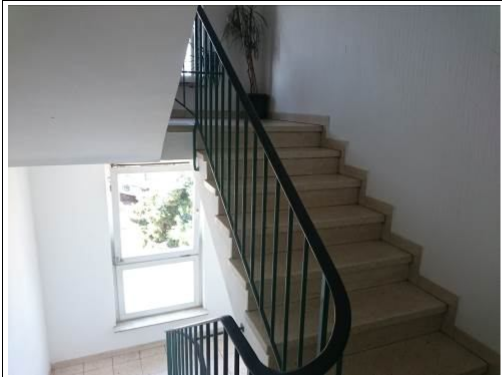
Blick in das Treppenhaus
