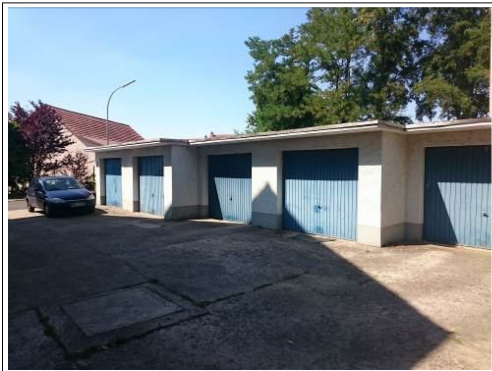
Blick auf die Teileigentume der Garagen
