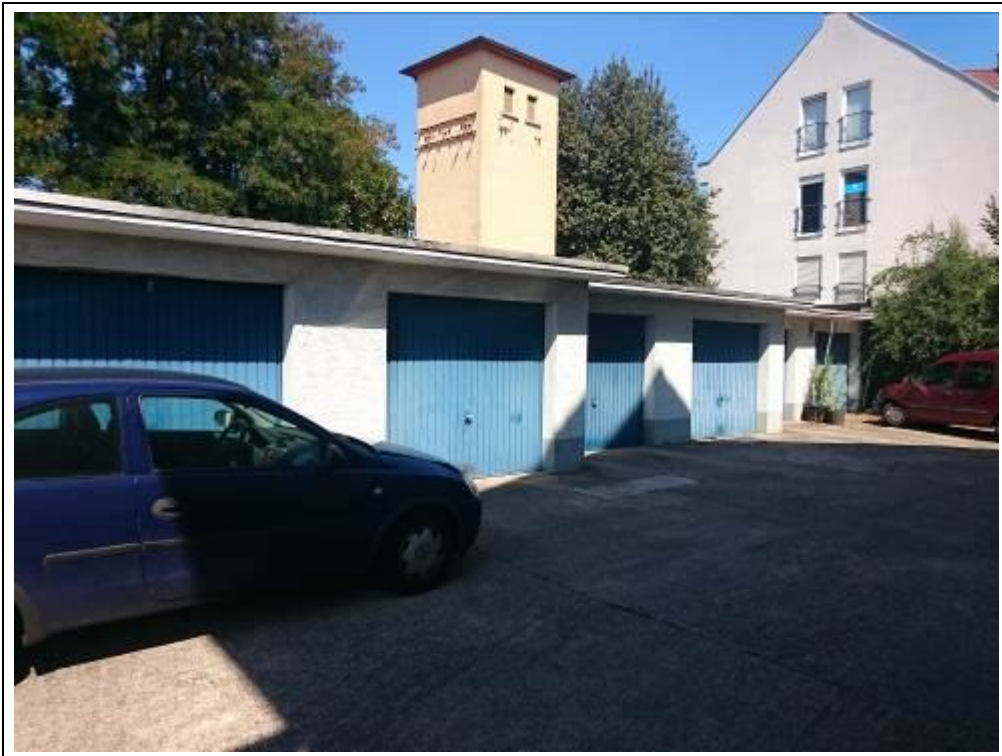
Blick auf die Teileigentume der Garagen
