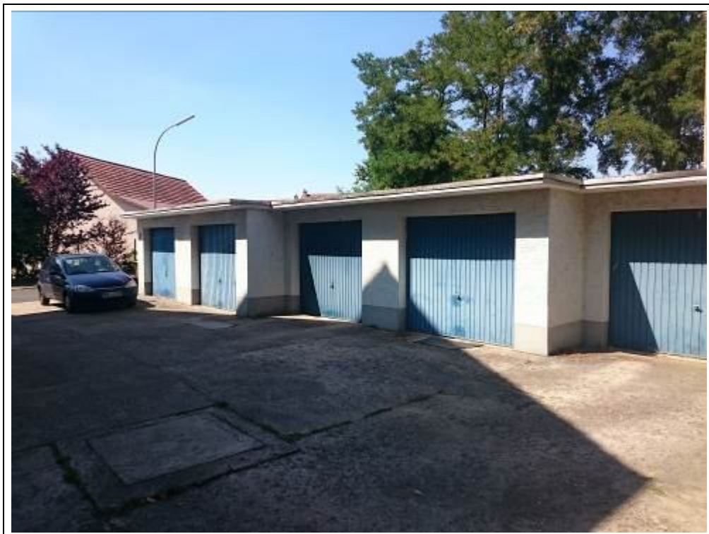
Blick auf die Teileigentume der Garagen
