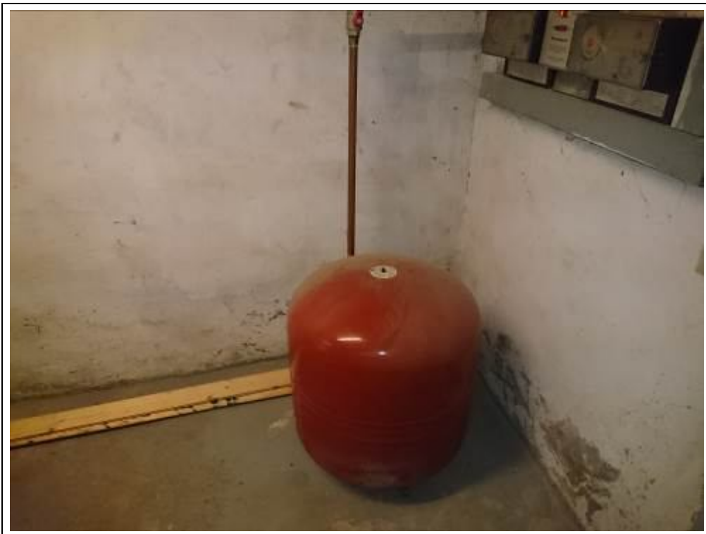
Feuchtigkeitsschäden an den Kellerwänden
