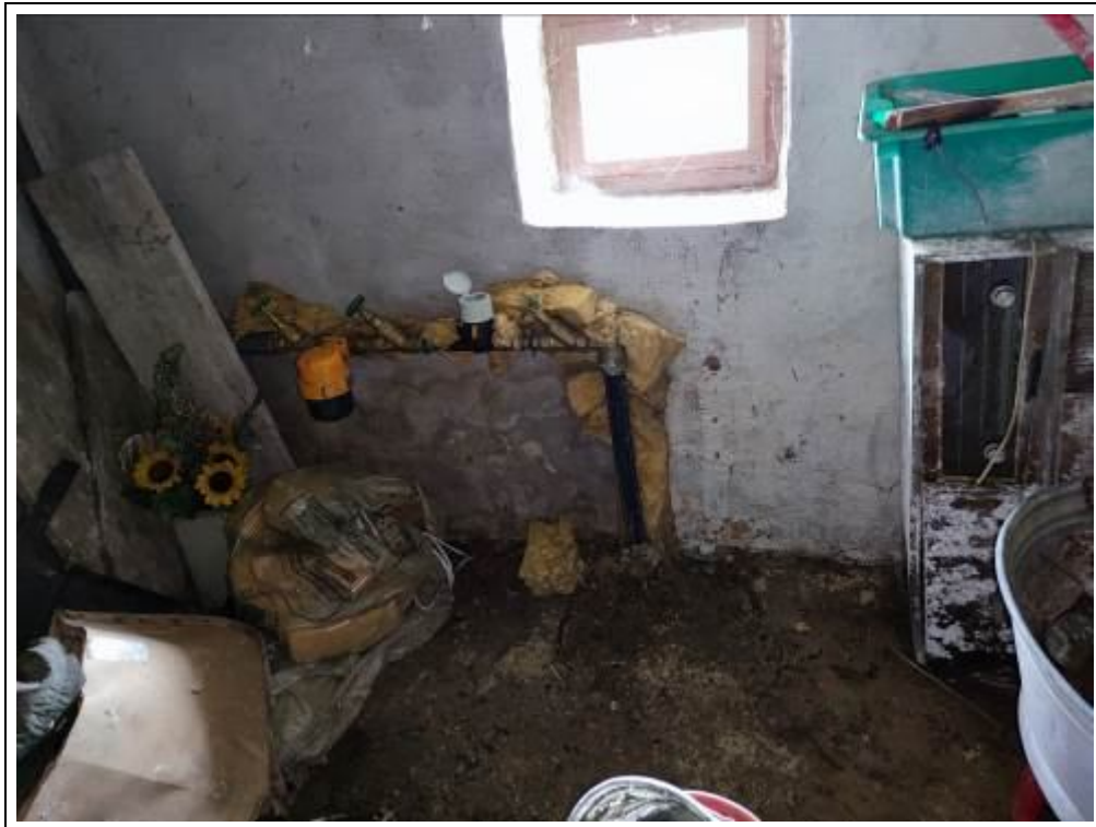
Blick in einen Kellerraum
