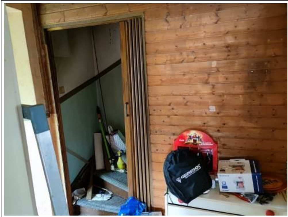
Blick auf die Verkleidung der Treppenhauswand
