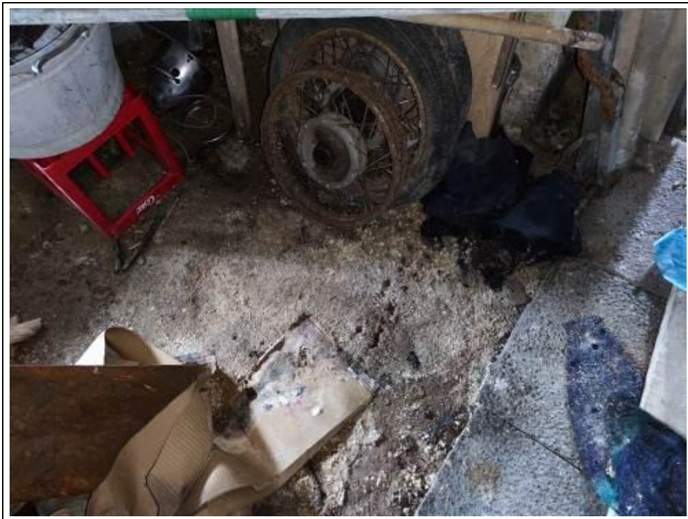
Blick auf den Boden im Keller (teilweise Erdreich)
