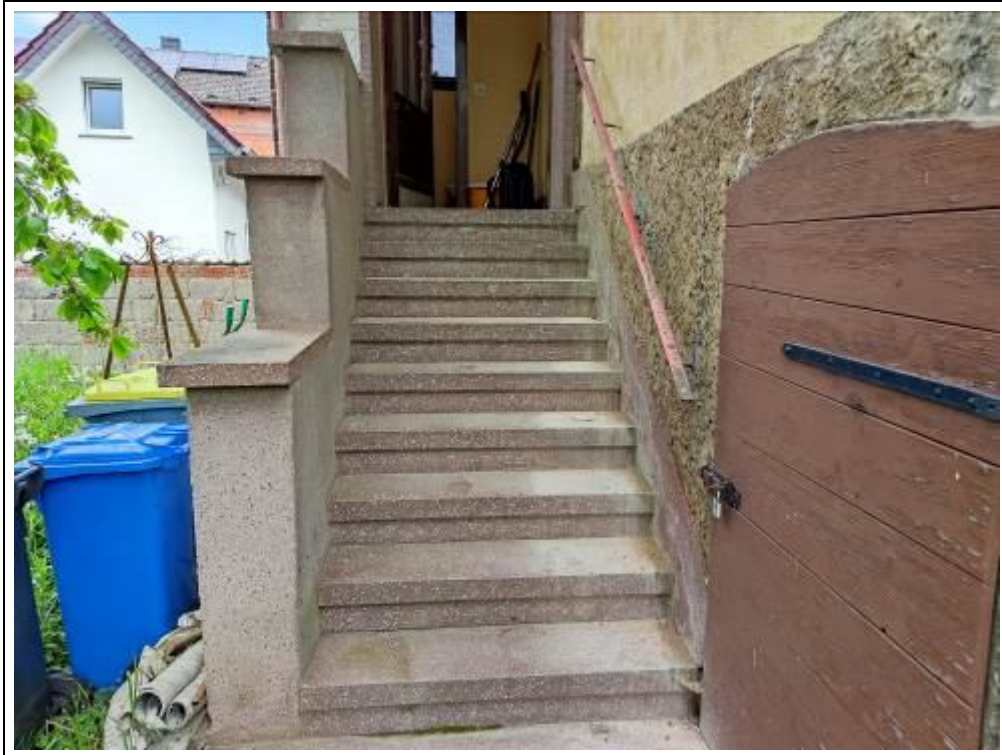
Blick auf die Hauseingangstreppe
