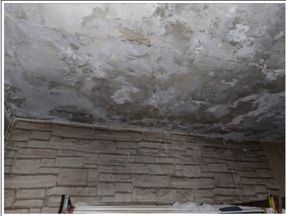
Blick gegen die Decke in der Küche
