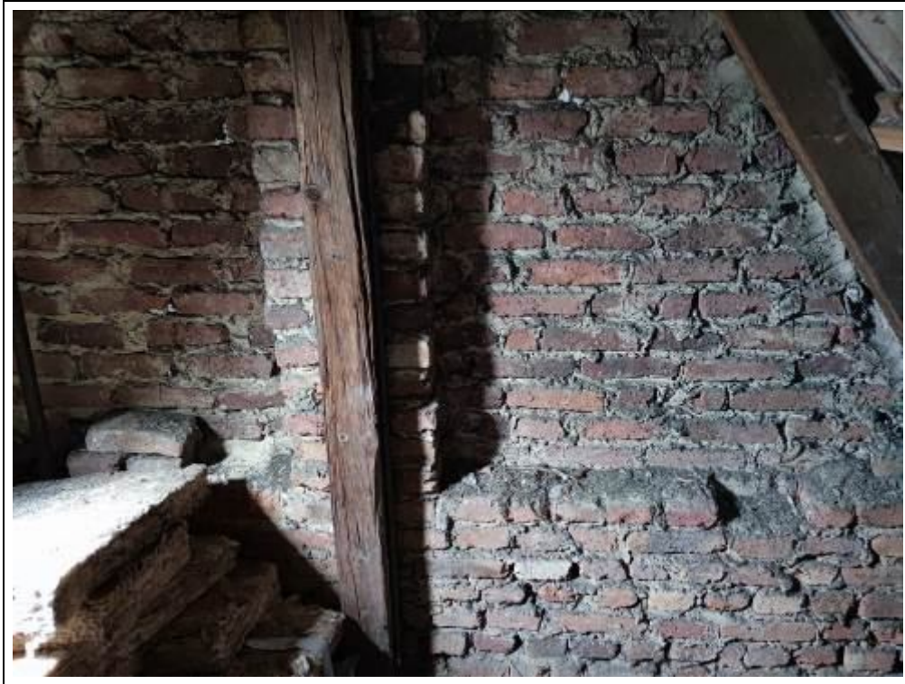
Blick auf das Giebelmauerwerk im Spitzboden
