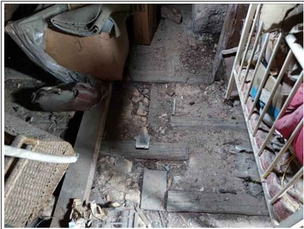
Blick auf den Boden im Spitzboden
