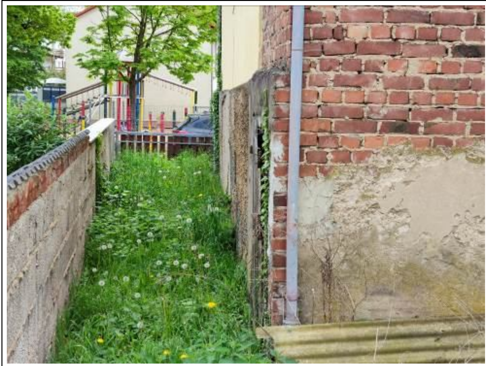
Blick in den östlichen Grenzbereich
