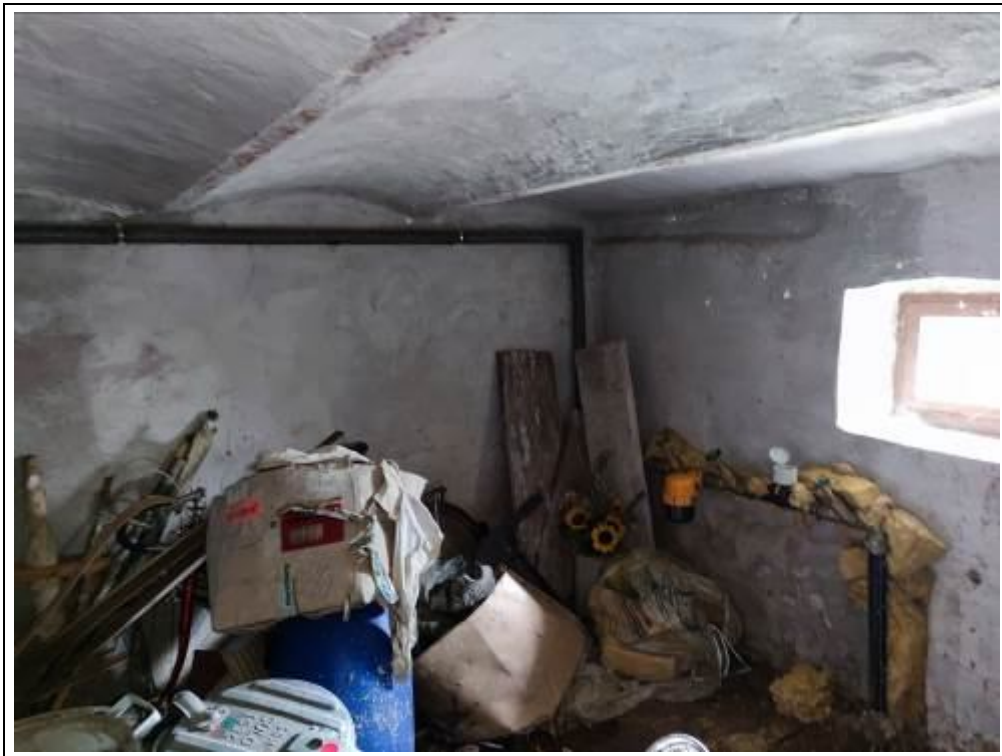
Blick in den Keller
