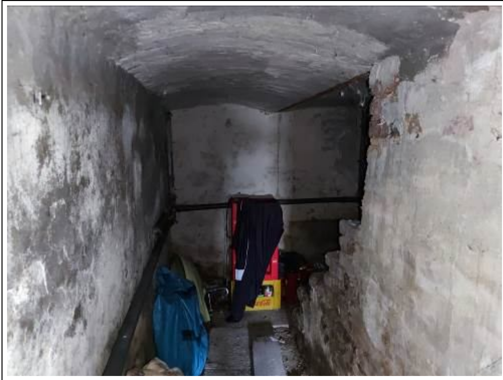
Blick in den Keller
