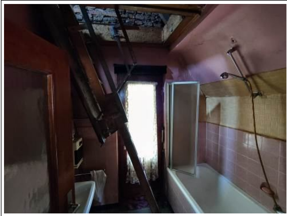
Blick in das Bad im Dachgeschoss mit Einschubtreppe zum Spitzboden
