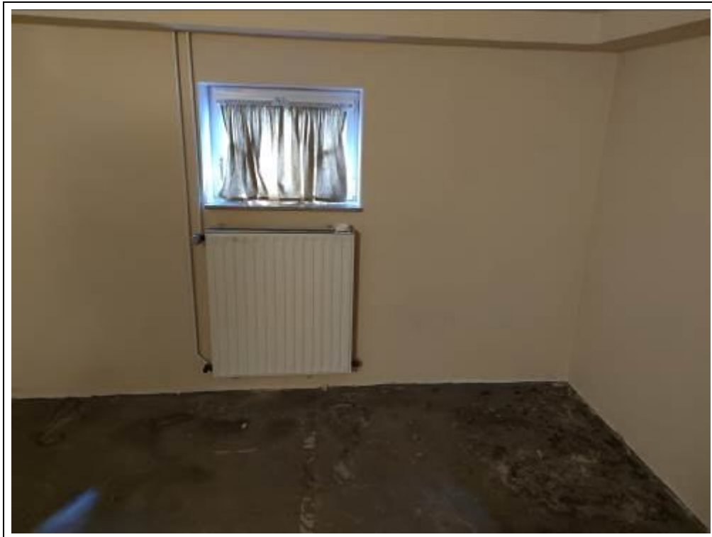
Blick in einen Kellerraum
