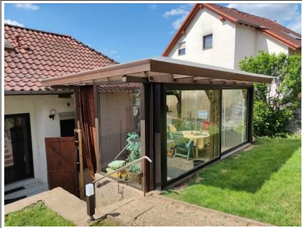
Blick auf den angebauten Wintergarten von Nordosten
