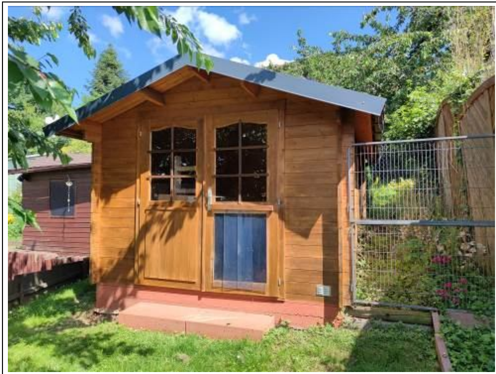
Blick auf ein Gartengerätehaus
