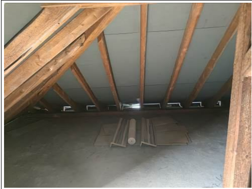
Blick in den Dachboden
