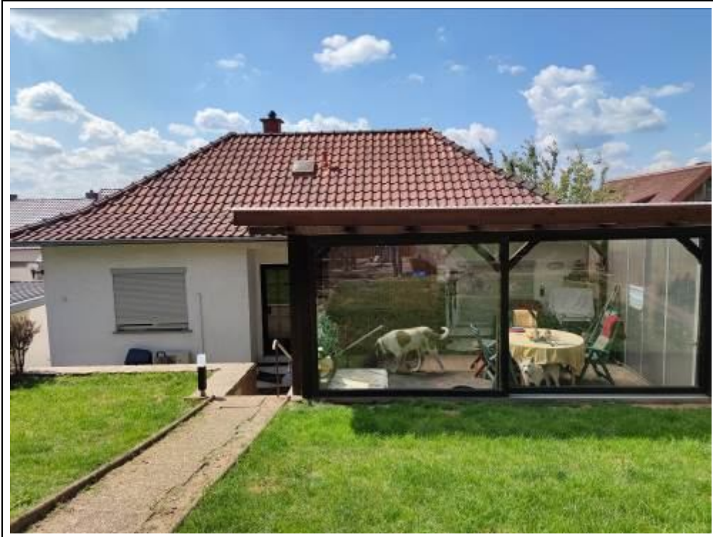
Blick auf das Wohnhaus von Norden
