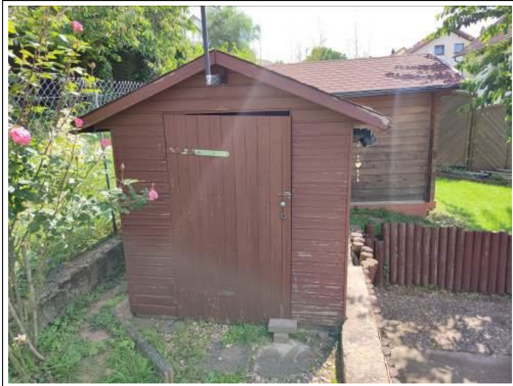
Blick auf ein Gartengerätehaus
