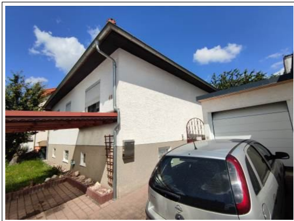
Blick auf das Wohnhaus von Südosten
