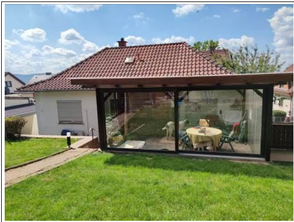
Blick auf das Wohnhaus von Norden
