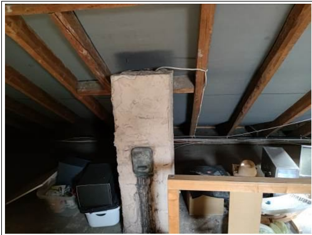
Blick in den Dachboden mit einem tlw. Abgebrochenen Schornstein
