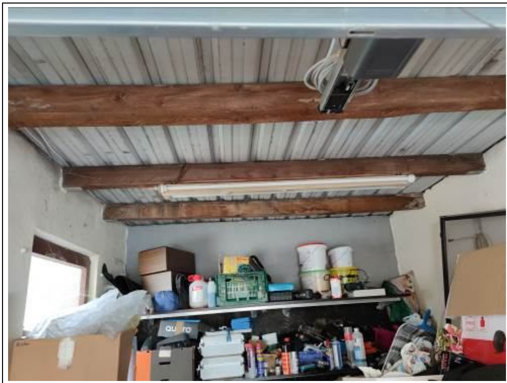
Blick gegen die Dachkonstruktion in der Garage
