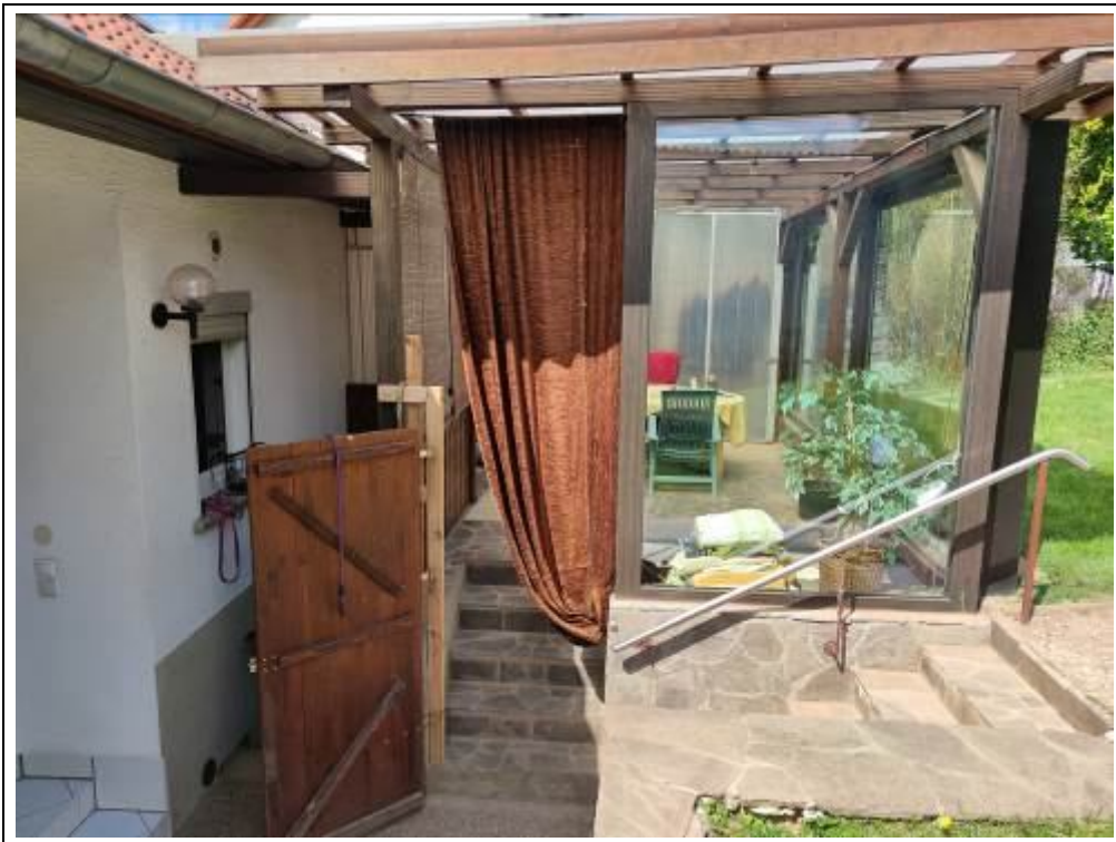
Blick auf den angebauten Wintergarten
