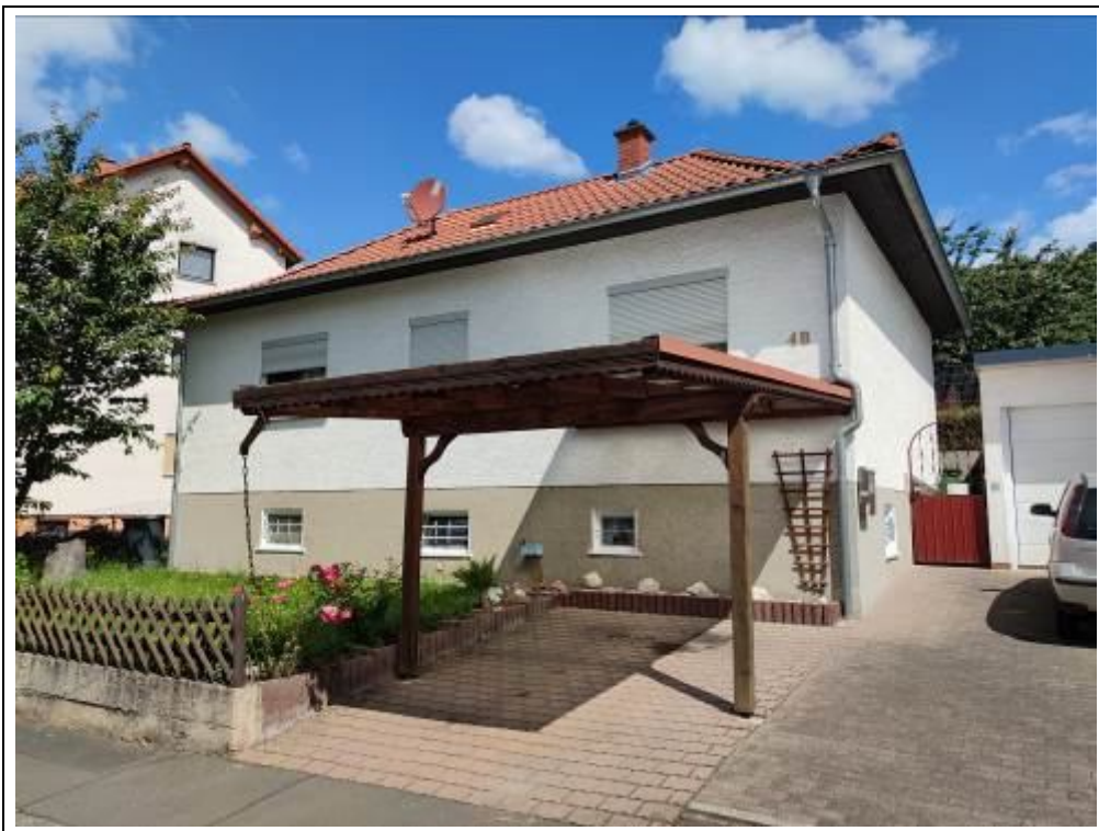
Blick auf das Wohnhaus von Südosten
