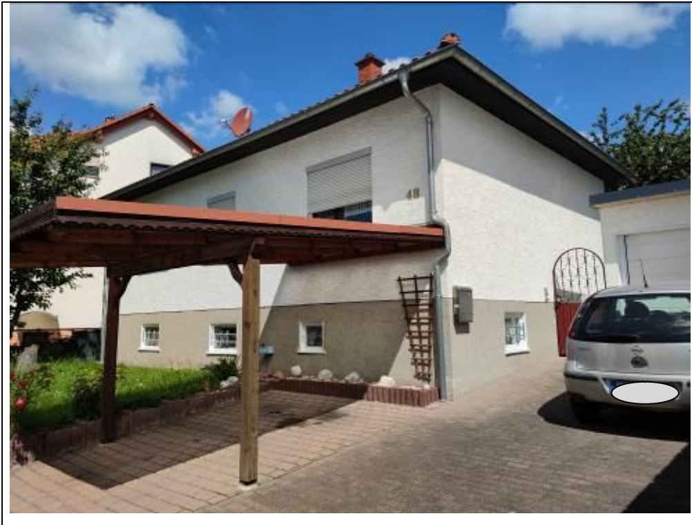
Blick auf das Wohnhaus von Südosten
