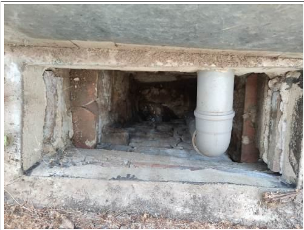
Blick in den Revisionschacht
