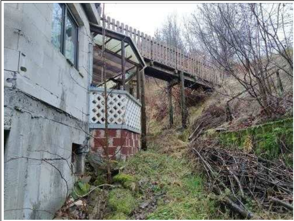
Blick vom Hofbereich in den südwestlichen Gartenbereich
