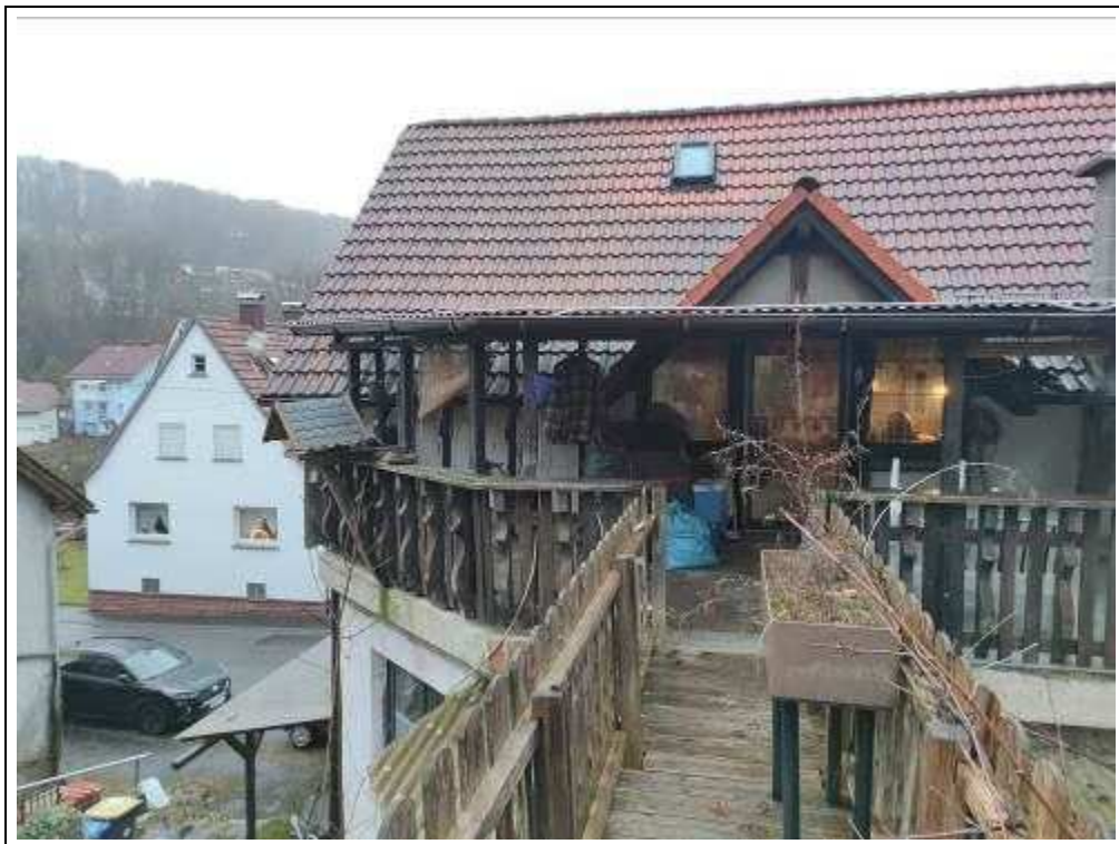
Blick auf das Bewertungsobjekt von Südwesten
