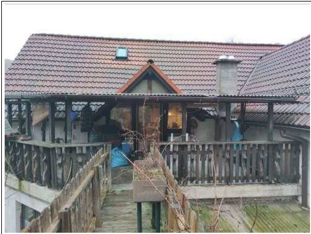
Blick auf das Bewertungsobjekt von Südwesten
