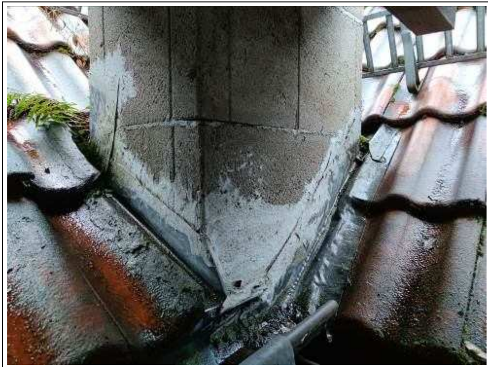
Blick auf die Eindichtung des Kamins
