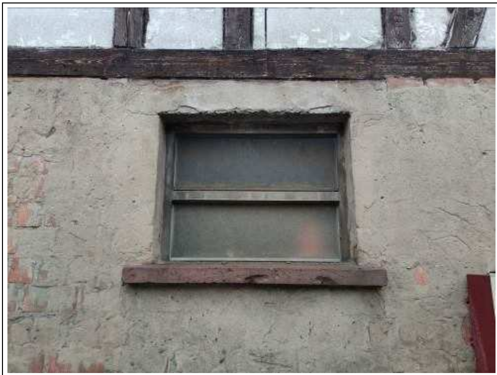
Blick auf ein Kellerfenster
