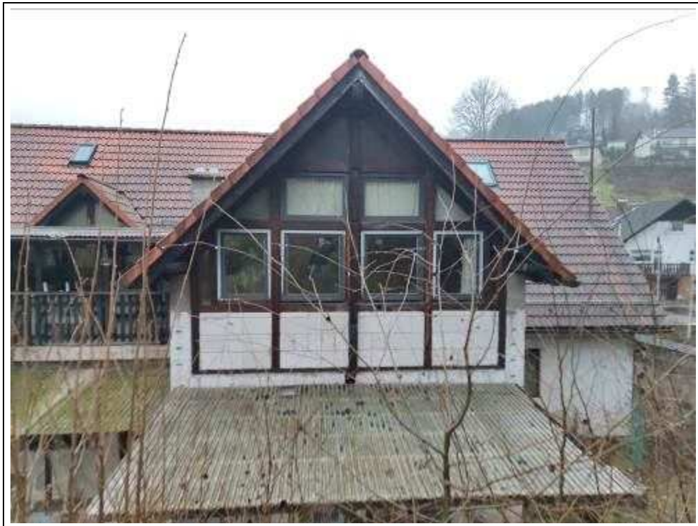
Blick auf das Bewertungsobjekt von Südwesten
