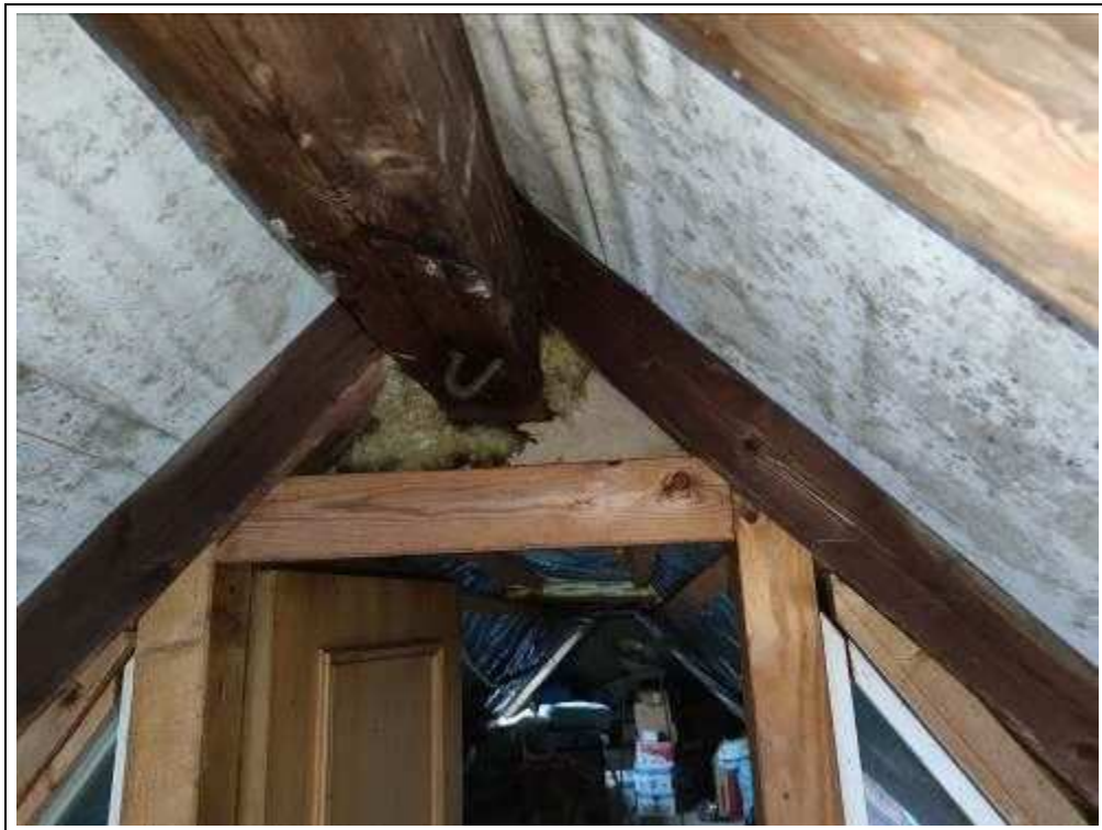
Blick auf die Außenwandkonstruktion (Giebelkonstruktion) im Bereich des Balkons im Spitzboden
