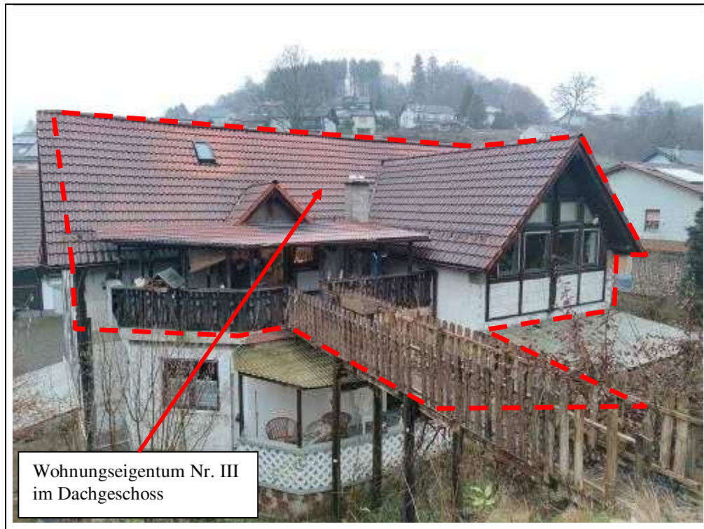
Blick auf das Bewertungsobjekt von Südwesten
