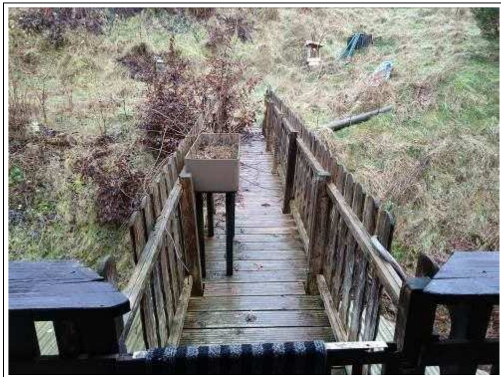
Blick auf den Steg / Brücke zum Gartenbereich (im Sondereigentum Wohnung III)
