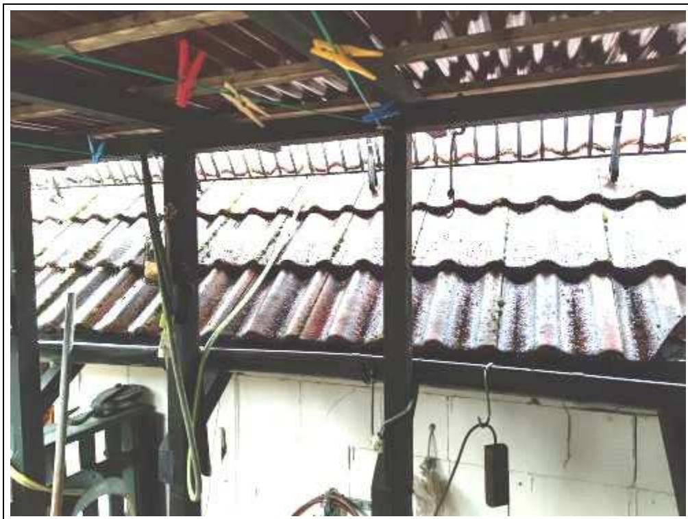
Blick auf die „schlanke“ Konstruktion der Balkonüberdachung
