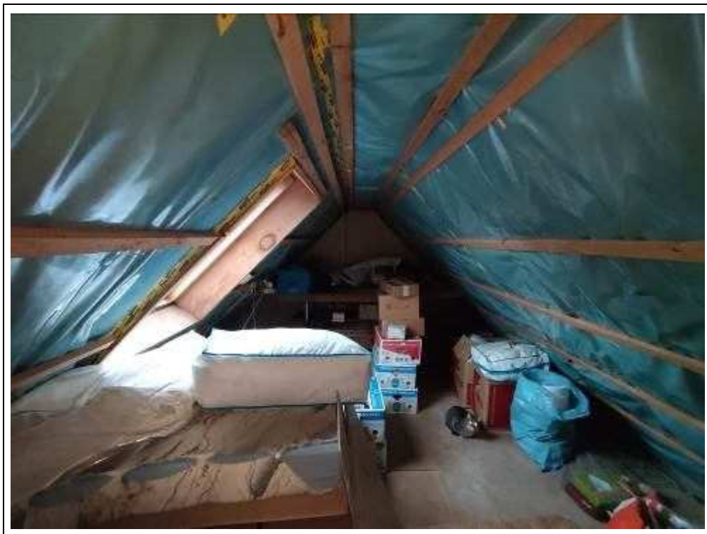
Blick in den nicht ausgebauten Teil des Spitzbodens
