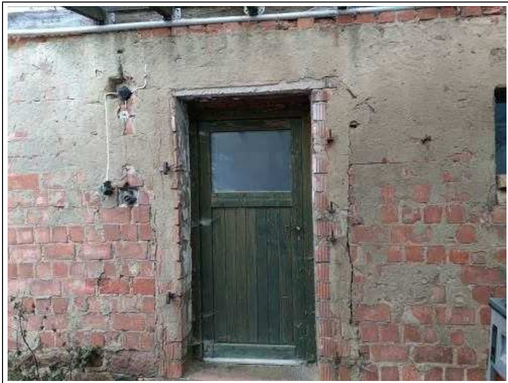
Blick auf den Zugang von Außen zum Kellerraum III
