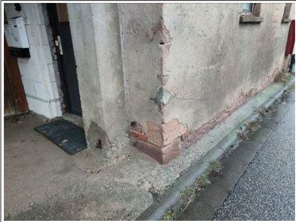
Blick auf den Zustand der Außenwand (Altbestand)
