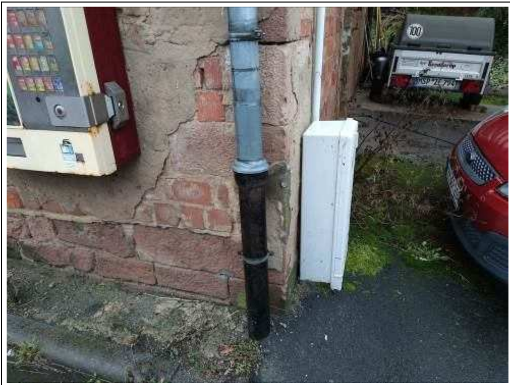
Blick auf den Zustand der Außenwand (Altbestand)
