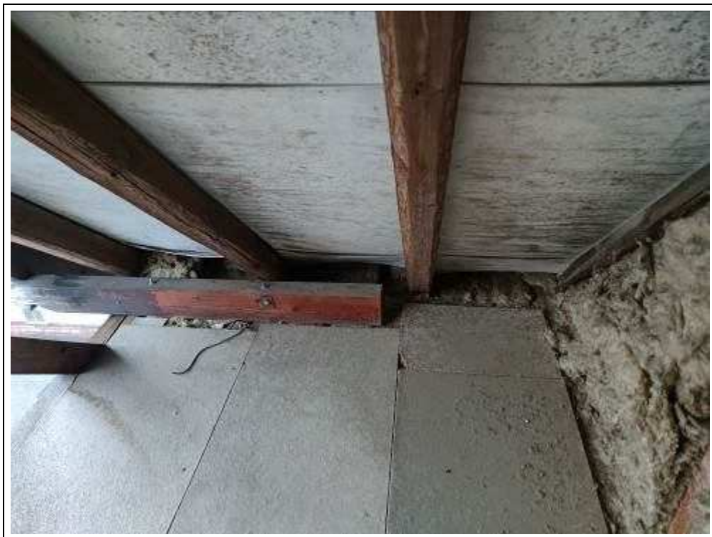
Blick auf die Spanplatten auf dem Balkon im Spitzboden
