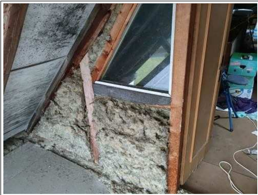
Blick auf die Außenwand des Spitzbodens
