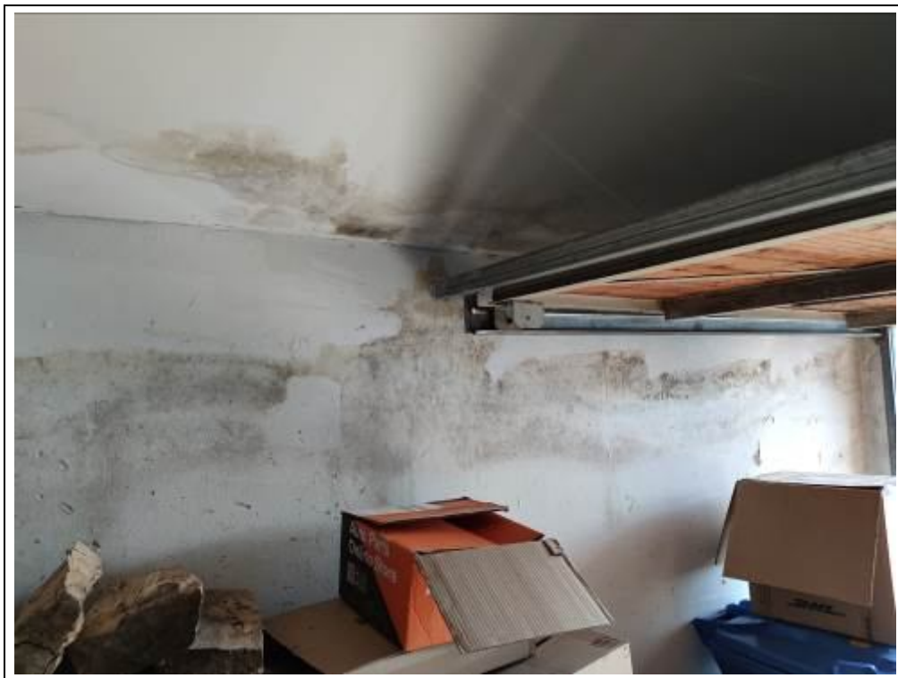
Blick auf Feuchtigkeitsschäden an der Garagenaußenwand
