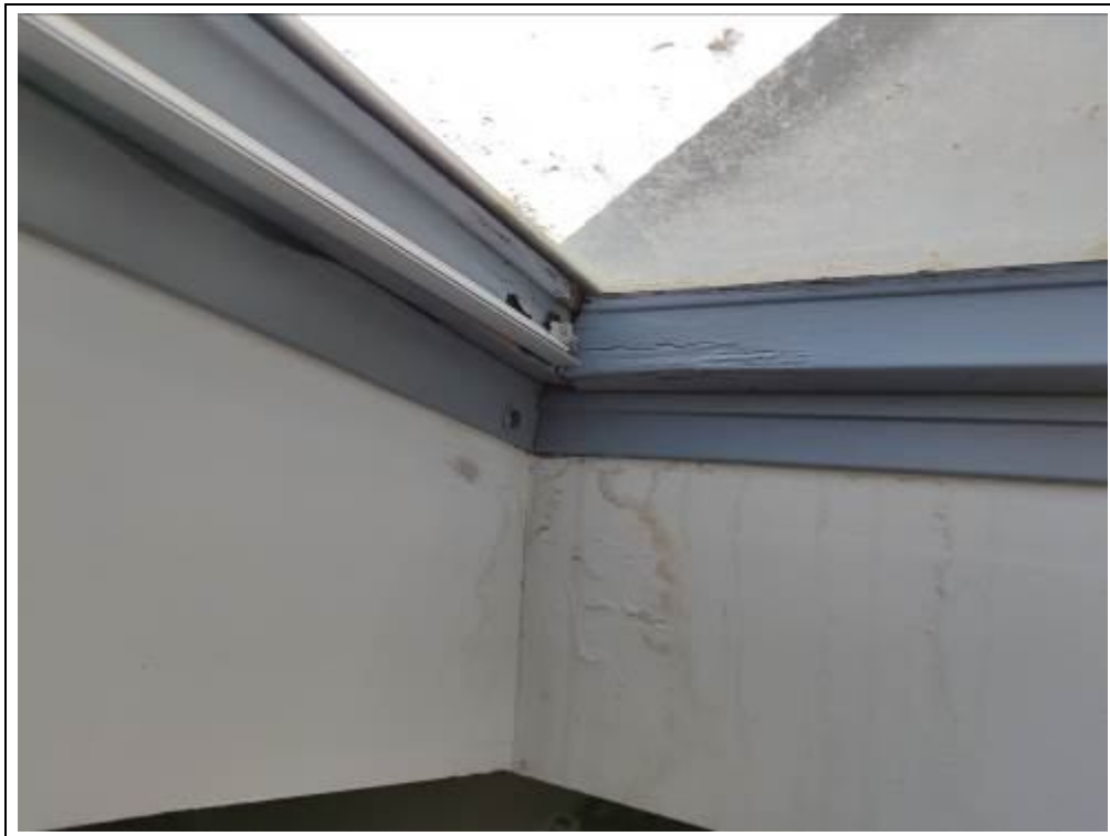
Blick auf Feuchtigkeitsschäden an undichten Dachfenstern
