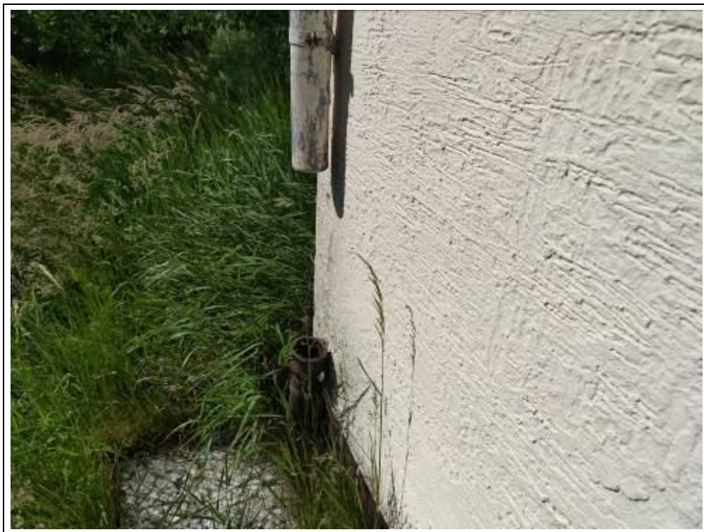
Blick auf ein nicht verbundenes Regenfallrohr (Gefahr von Feuchtigkeitsschäden an den Grundmauern)
