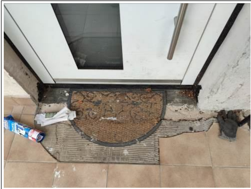
Blick auf Fliesenschäden im Bereich des Hauseingangs
