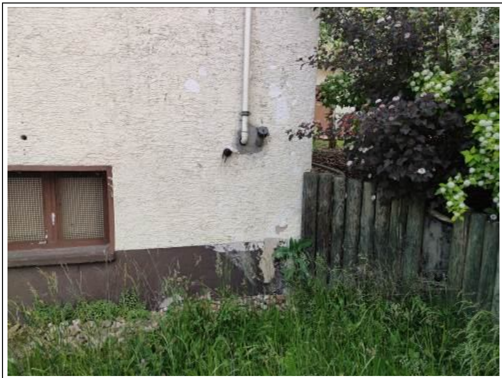
Blick auf den Öleinfüllstutzen und die Entlüftung
