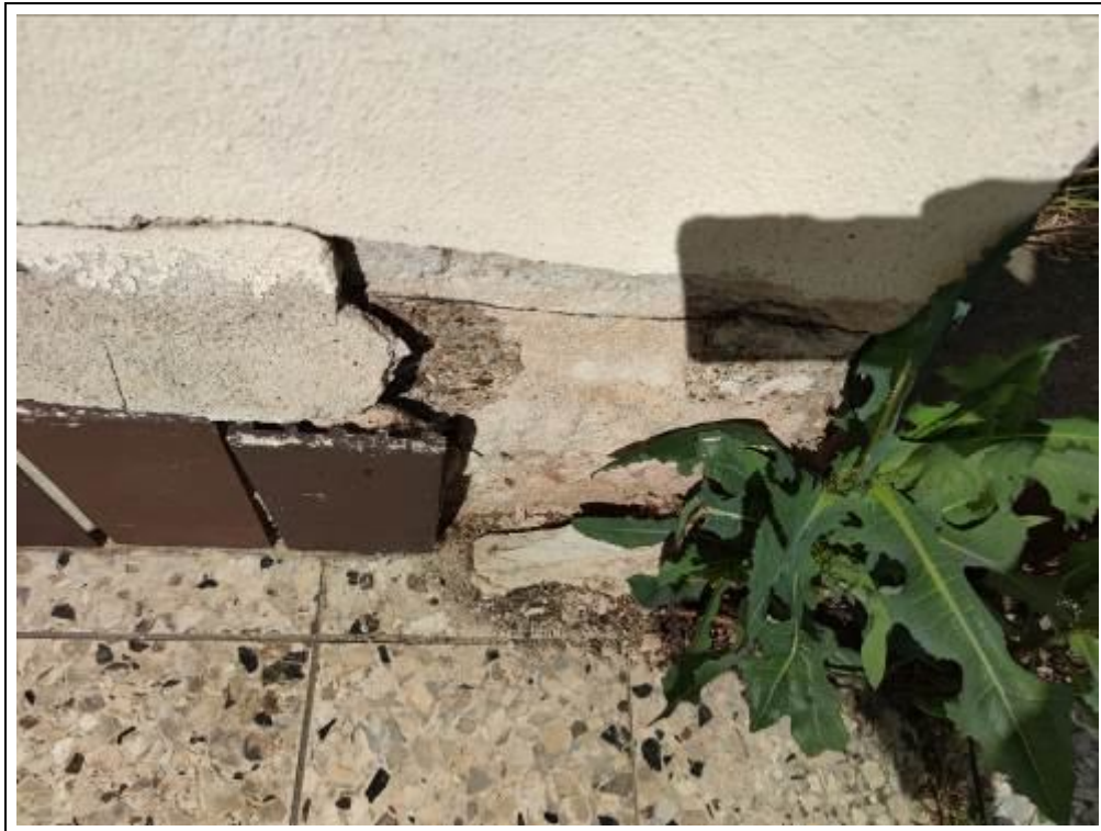
Blick auf Schäden an der Sockelverkleidung
