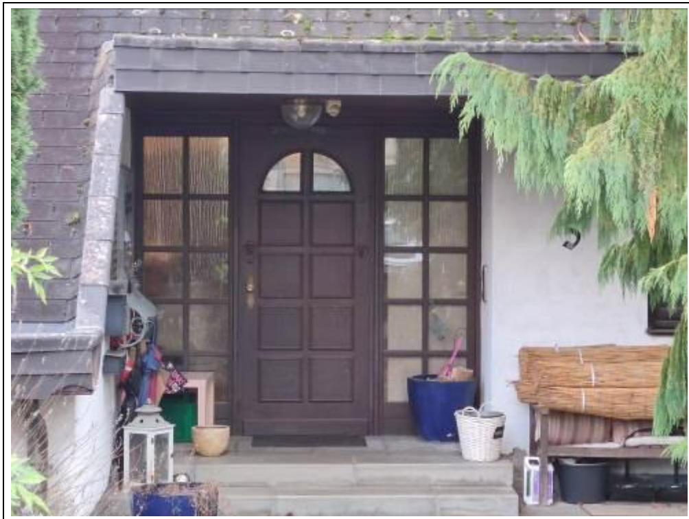
Blick auf die Hauseingangstüre
