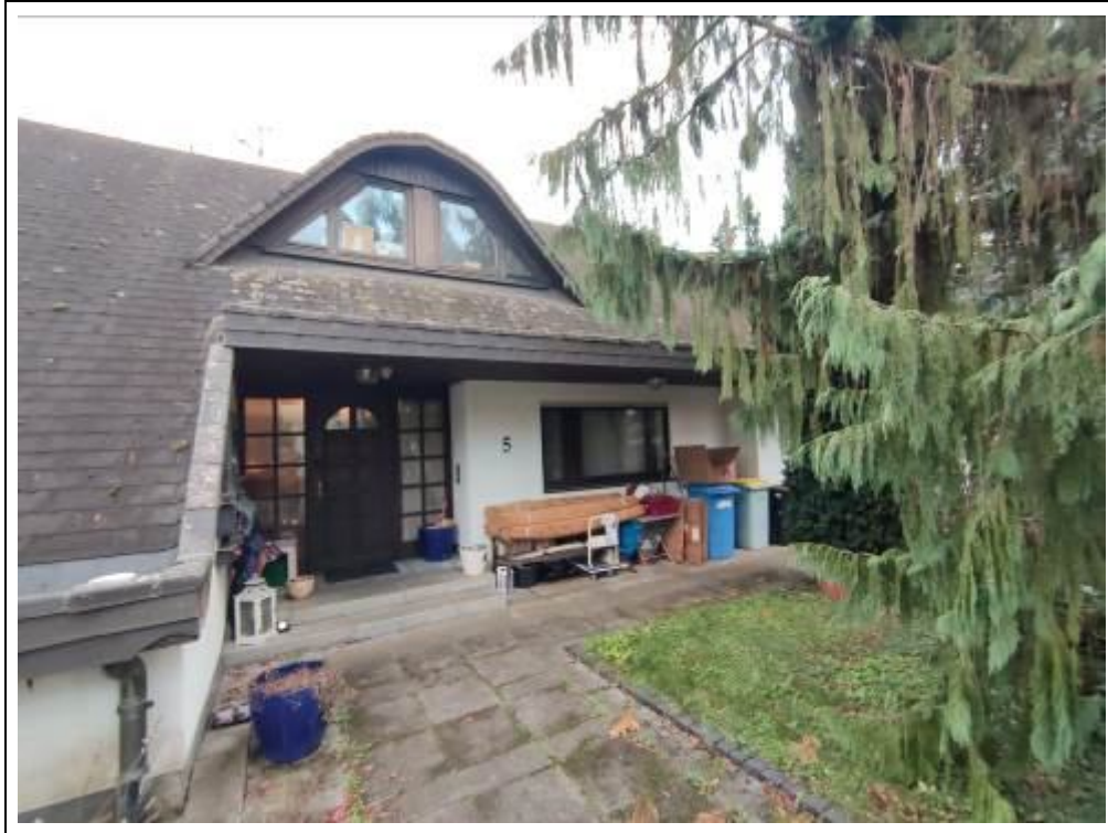
Blick auf das Bewertungsobjekt von Norden
