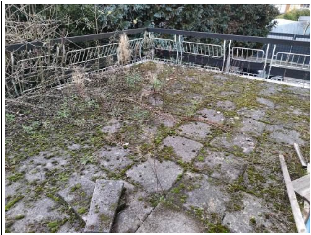
Blick auf die Betonsteinplatten des Balkons über der Garage
