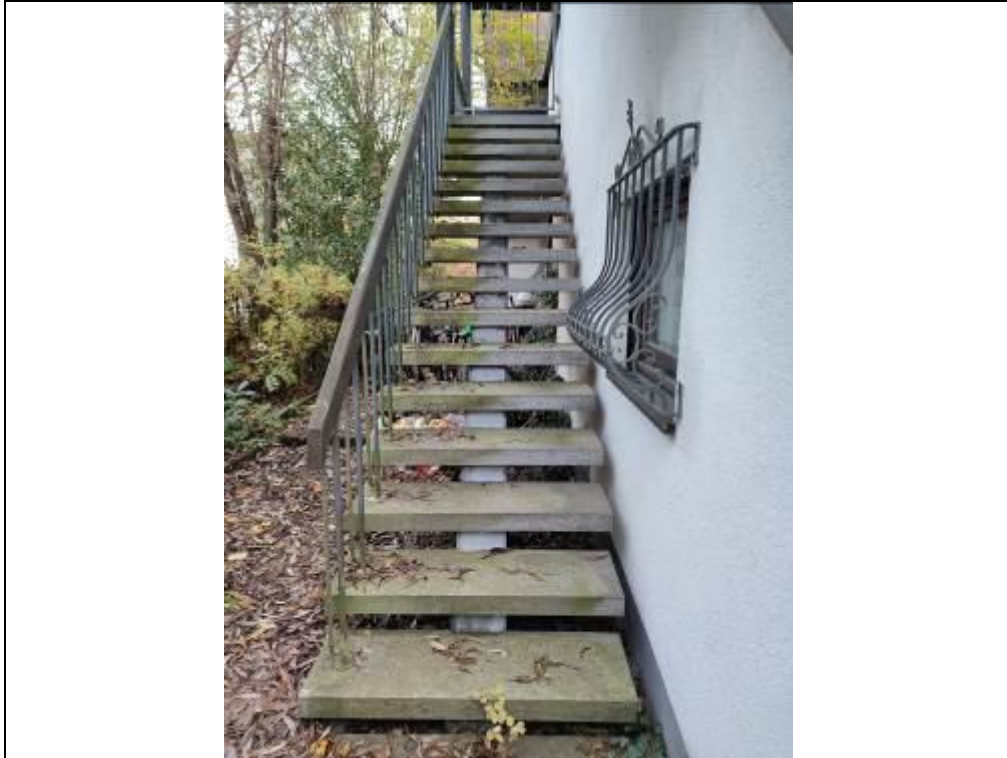
Blick auf die Treppe zum Eingang im Dachgeschoss
