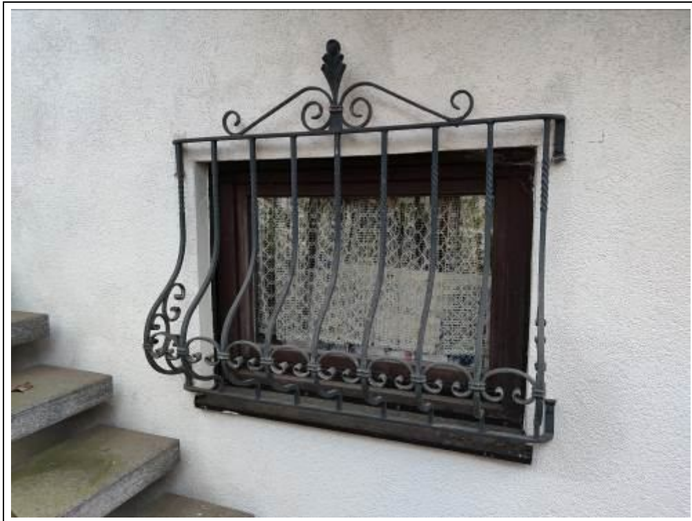
Blick auf Fenstergitter im Erdgeschoss
