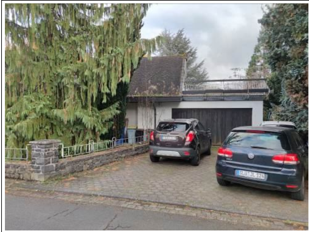
Blick auf das Bewertungsobjekt von Nordwesten
