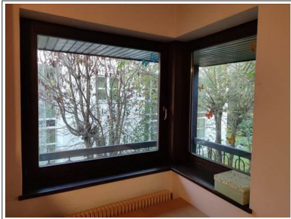
Blick auf Fenster aus dem Baujahr (Eckausbildung)
