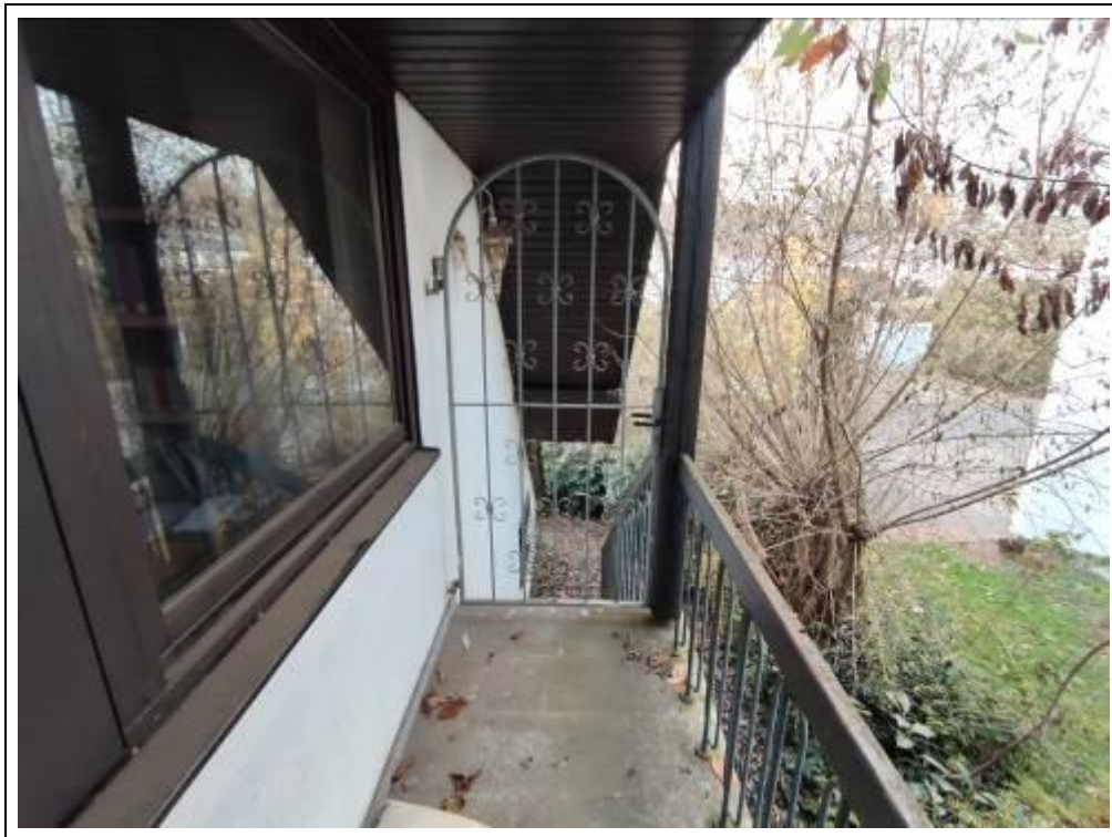
Blick auf den Zugang zum Dachgeschosseingang
