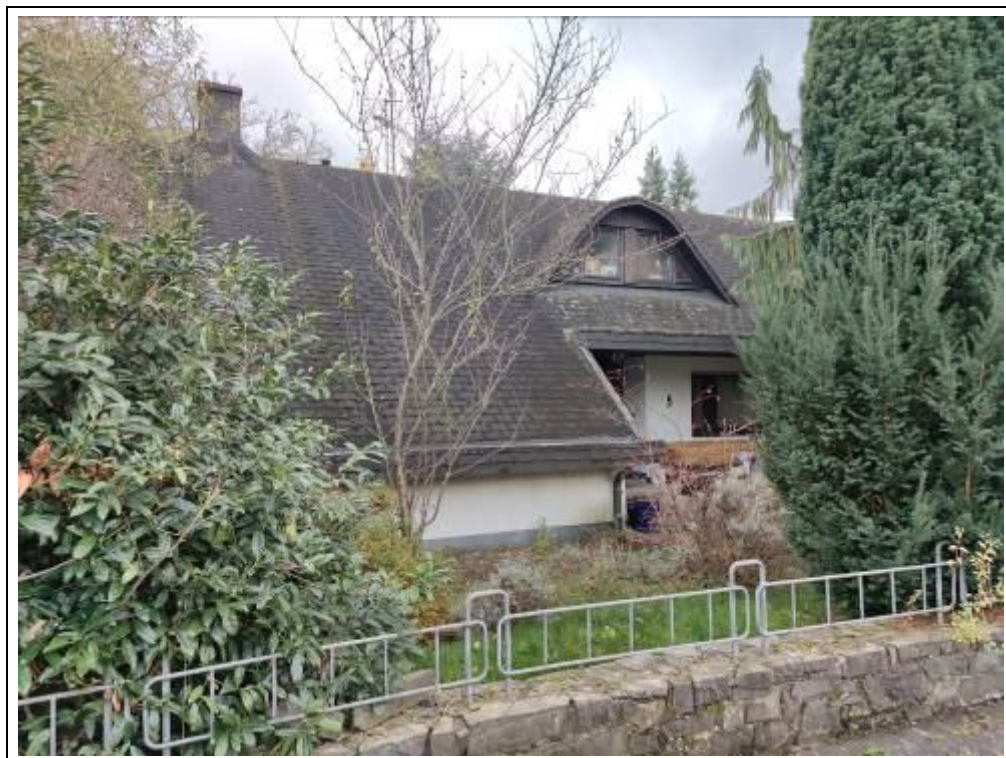
Blick auf das Bewertungsobjekt von Norden
