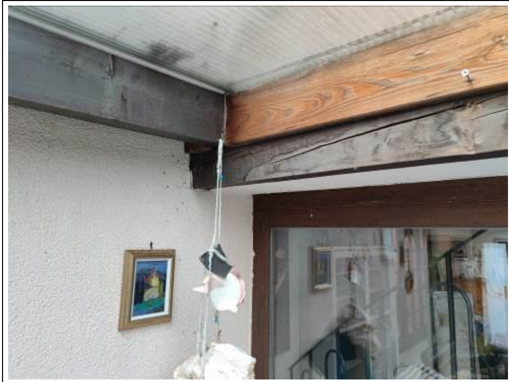
Blick gegen die Dachkonstruktion des Wintergartens
