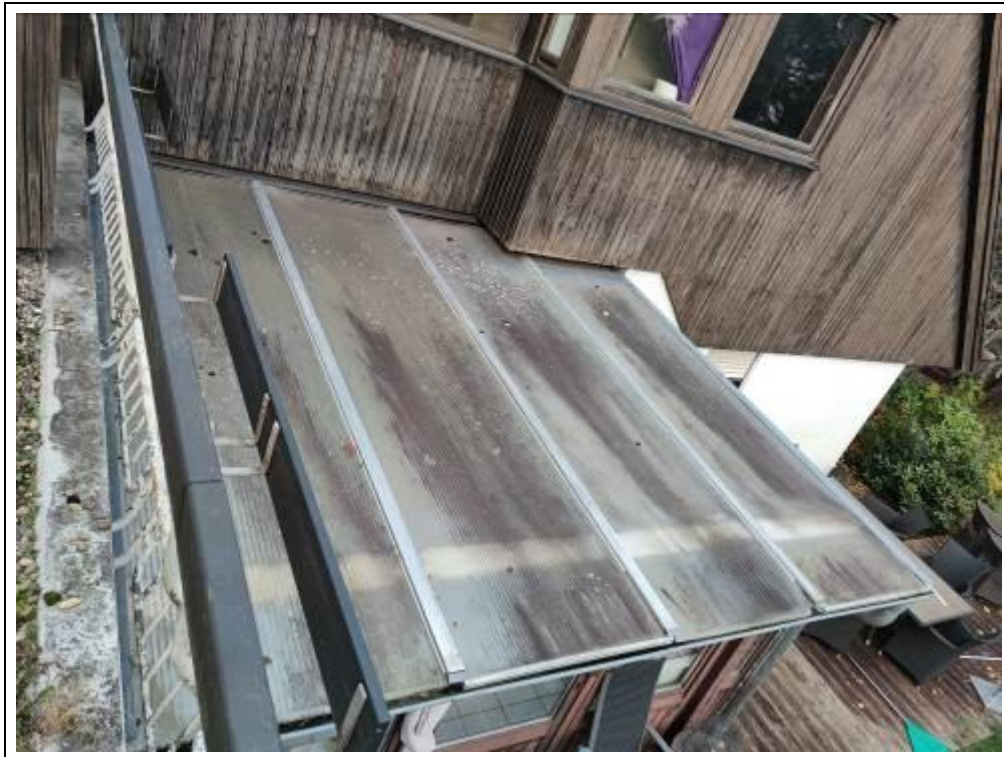
Blick auf die Dacheindeckung des Wintergartens
