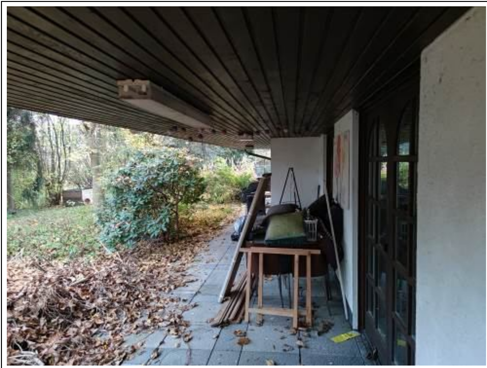
Blick auf die Terrasse vor dem Wohnzimmer im Südosten
