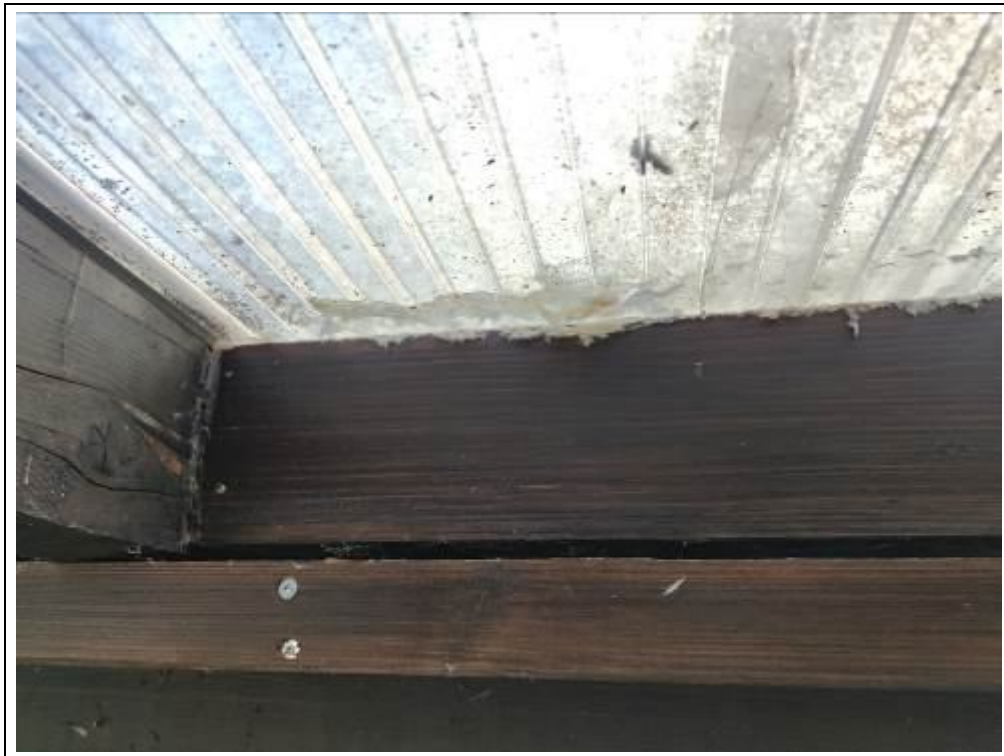
Blick gegen die Dacheindeckung mit Doppelstegplatten des Wintergartens
