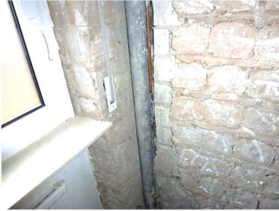
Bad EG Teil- Rohbau
