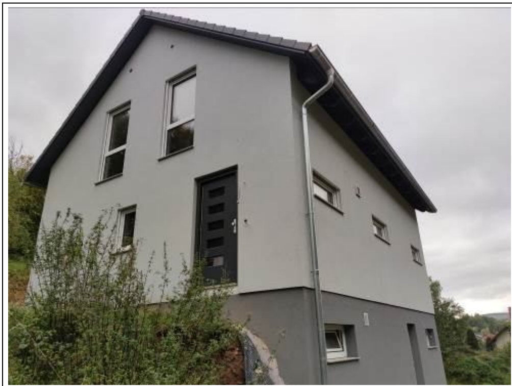
Blick auf das Bewertungsobjekt von Norden
