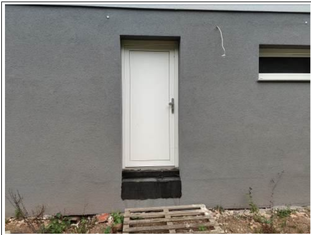
Blick auf den Kellernebeneingang
