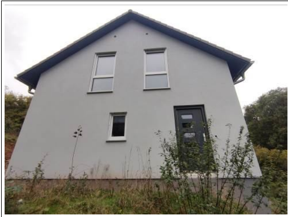
Blick auf das Bewertungsobjekt von Nordosten
