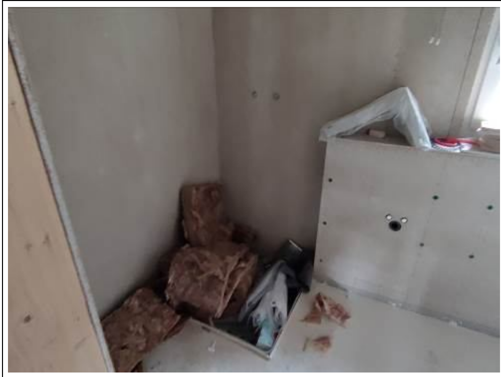
Blick in die Dusche / WC
