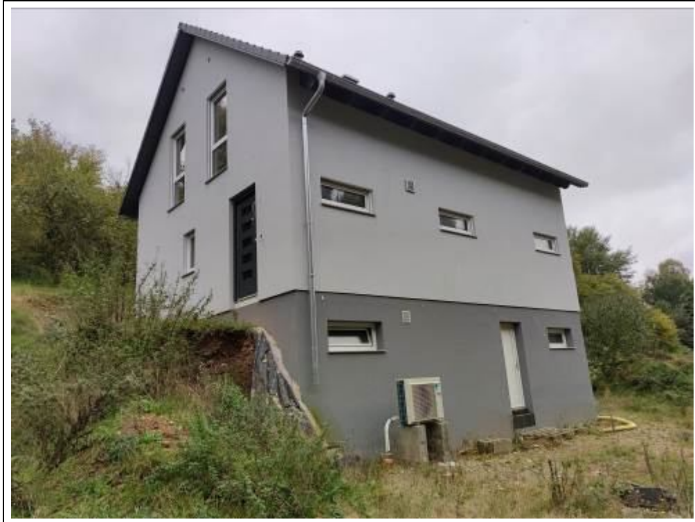
Blick auf das Bewertungsobjekt von Norden
