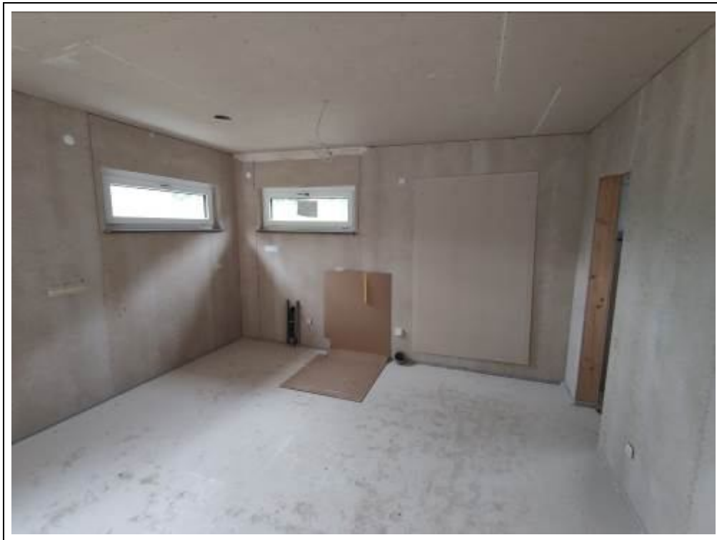
Blick in die offene Küche
