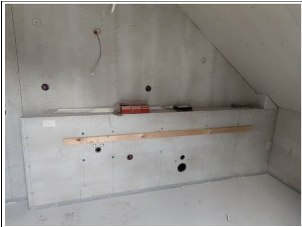
Blick in das Bad im Dachgeschoss
