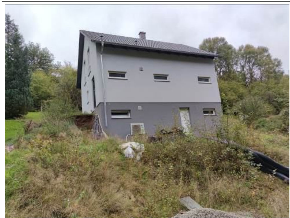
Blick auf das Bewertungsobjekt von Nordwesten
