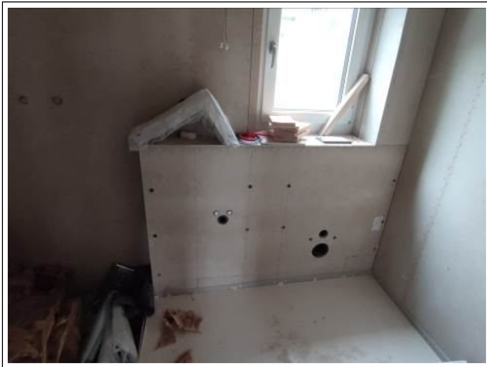
Blick in die Dusche / WC
