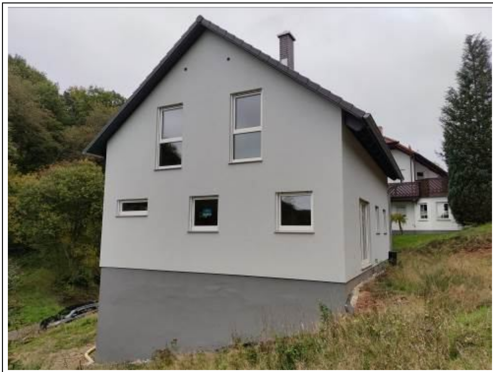
Blick auf das Bewertungsobjekt von Südwesten
