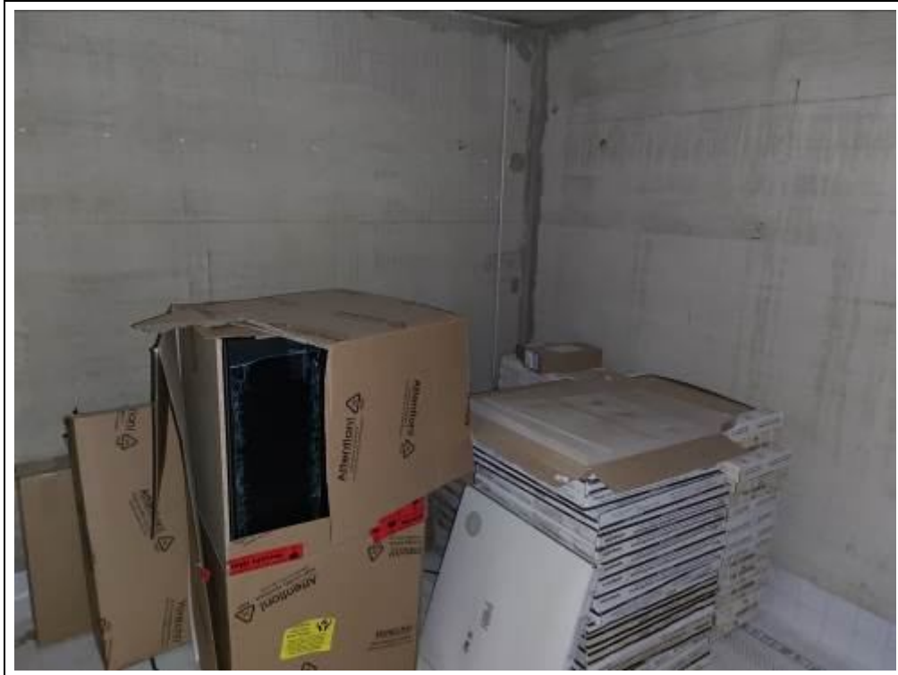
Blick in einen Kellerraum
