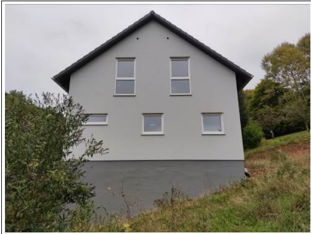
Blick auf das Bewertungsobjekt von Südwesten
