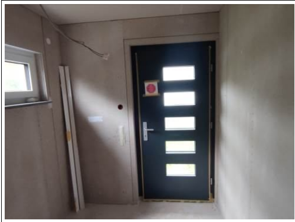
Blick auf die Hauseingangstüre
