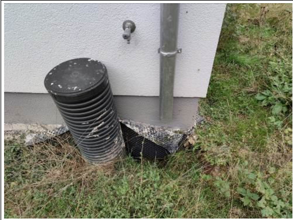
Blick auf nicht angeschlossene Regenrohre
