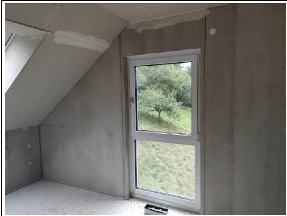
Blick in das Schlafzimmer im Dachgeschoss
