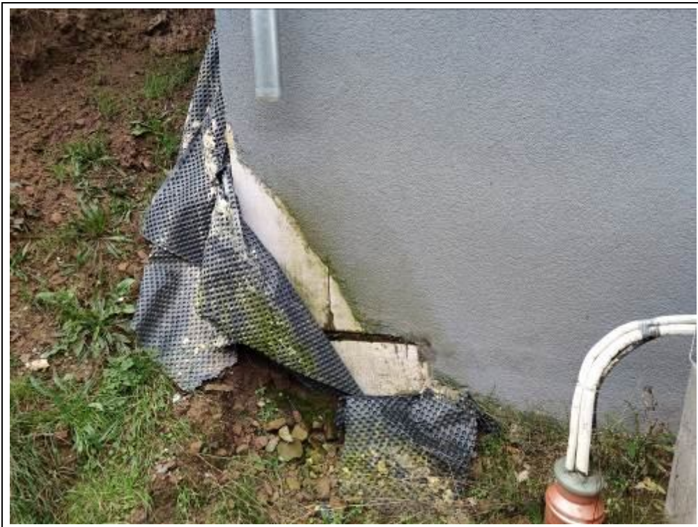
Blick auf nicht angeschlossene Regenrohre
