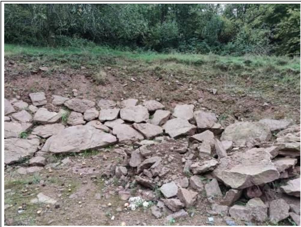
Blick auf provisorische Hangsicherung im geplanten Terrassenbereich
