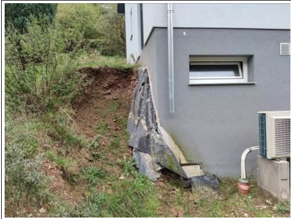
Blick auf den Bereich für die geplante Außentreppe zum Hauseingang im Erdgeschoss
