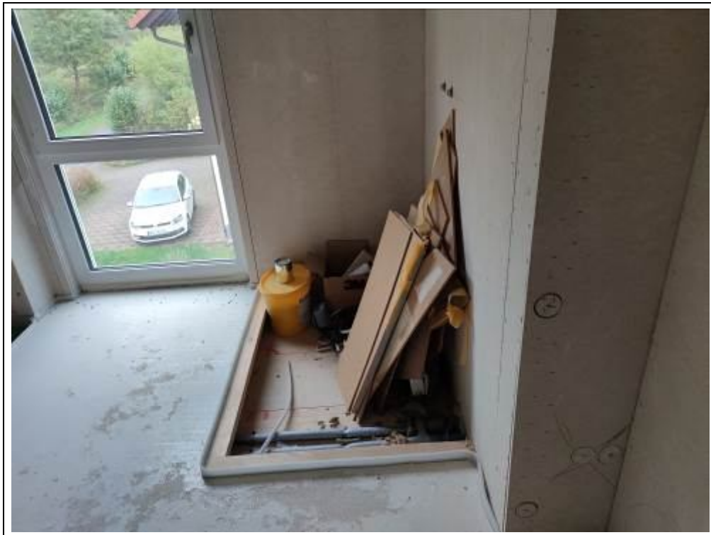
Blick in das Bad im Dachgeschoss
