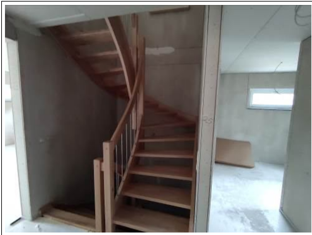
Blick auf die Treppe zum Dachgeschoss
