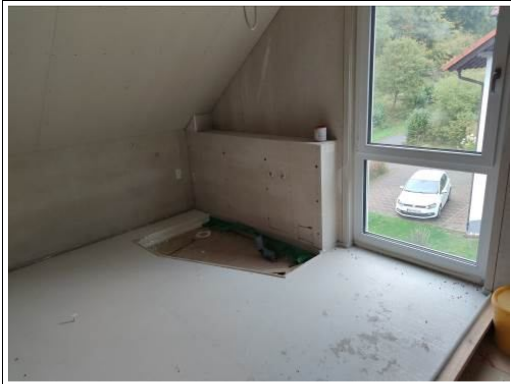
Blick in das Bad im Dachgeschoss
