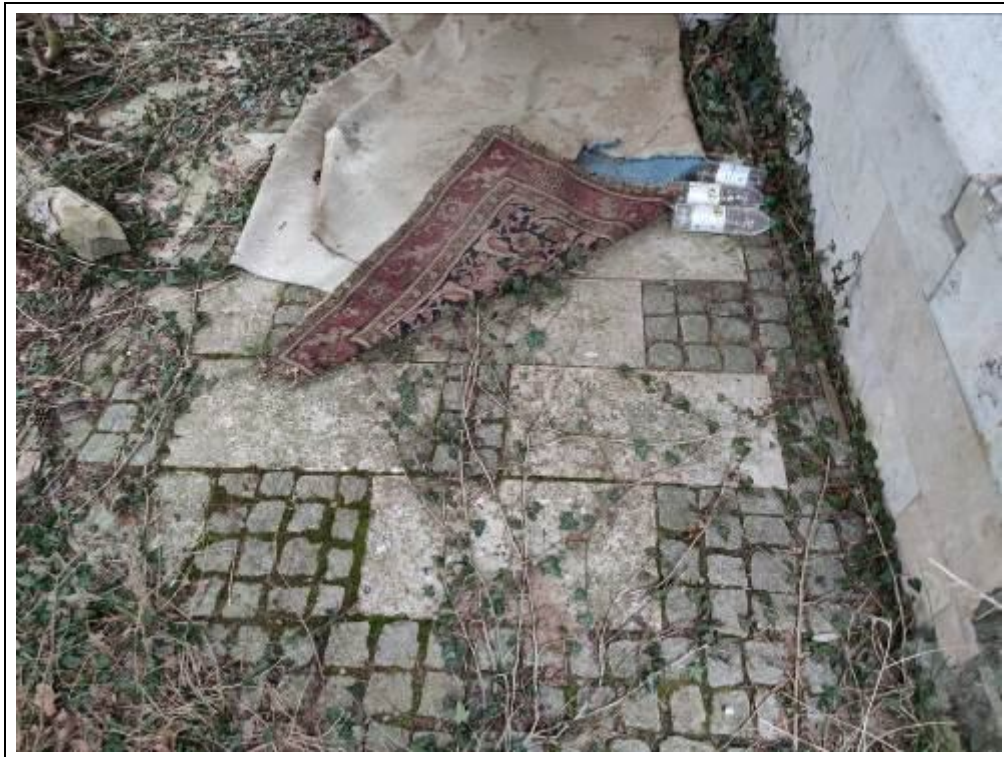
Blick auf die Hofbefestigung im Bereich der überdachten Terrasse
