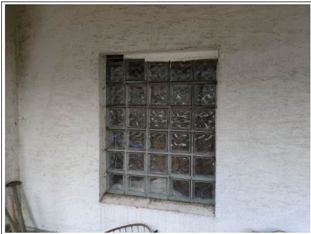
Blick auf Glasbausteine als Belichtung
