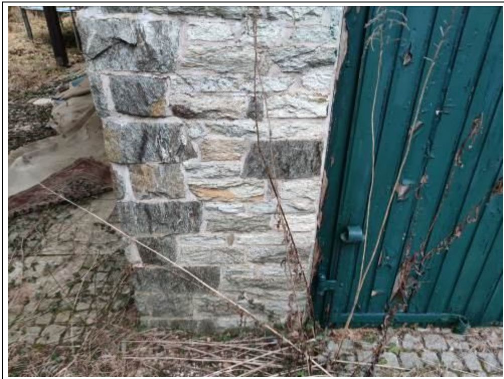
Blick auf die Natursteinverkleidung auf der Westseite
