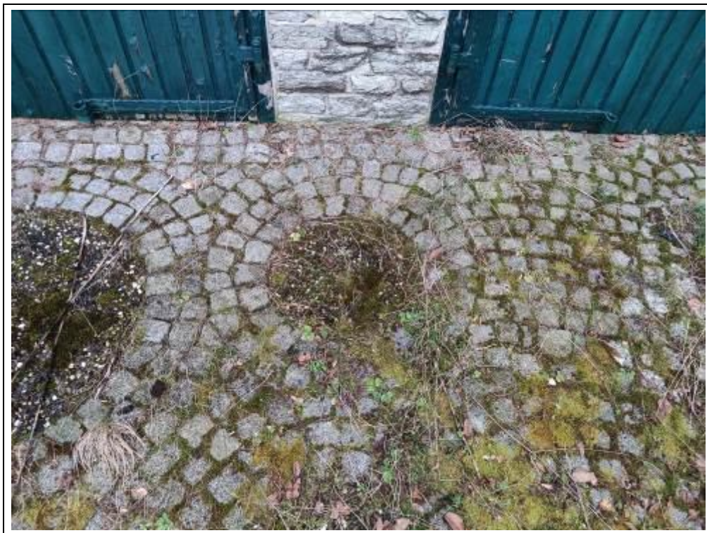
Blick auf die Hofbefestigung
