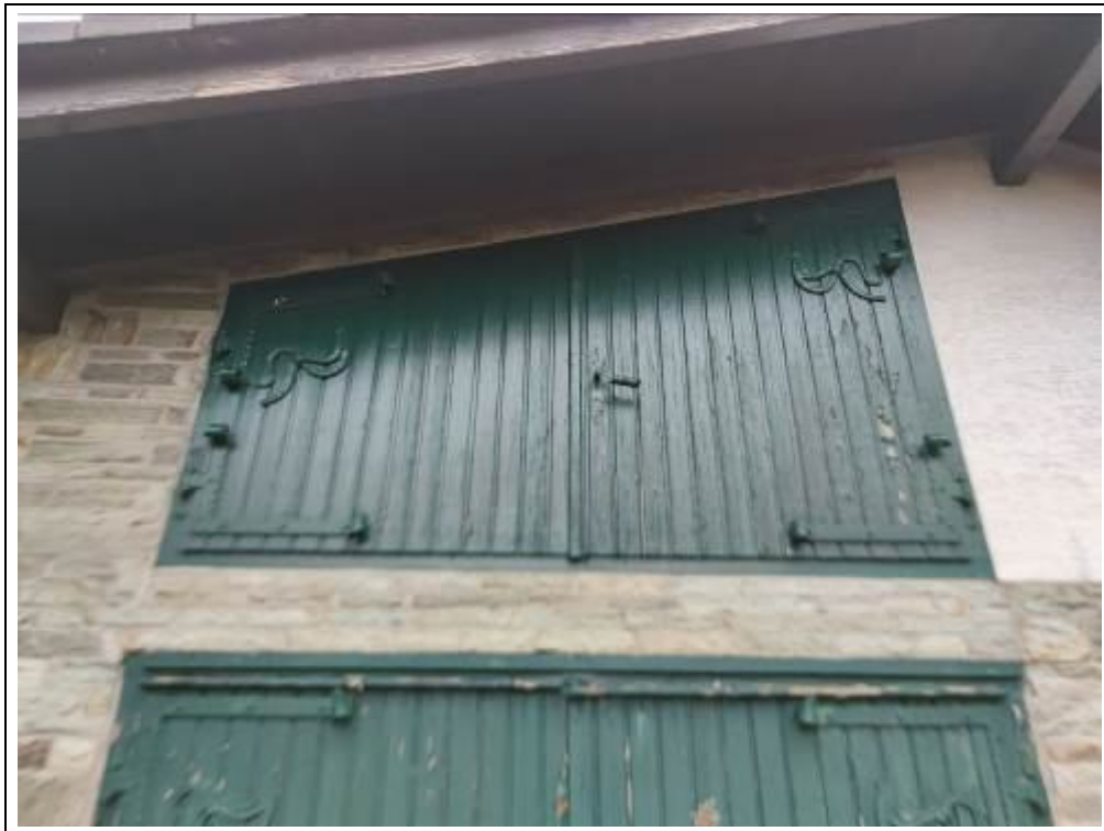
Blick auf die zweiflügelige Luke als Zugang zum Dachgeschoss
