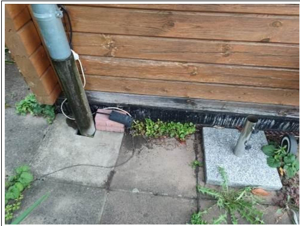
Blick auf den Sockelbereich
