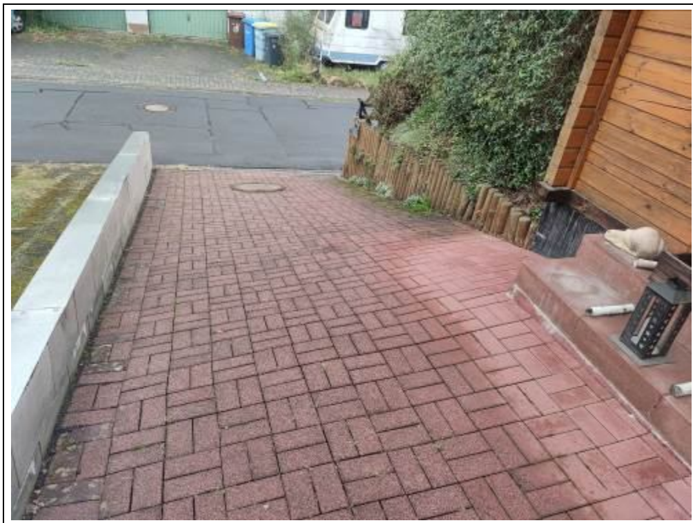
Blick auf die Zufahrt mit Stahlbetonmauer und Holzpalisadenabfangung der Terrasse
