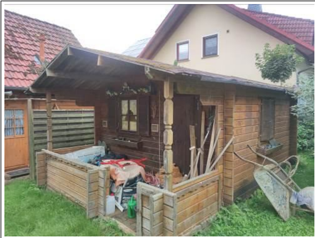
Blick auf das Gartenhaus von Osten
