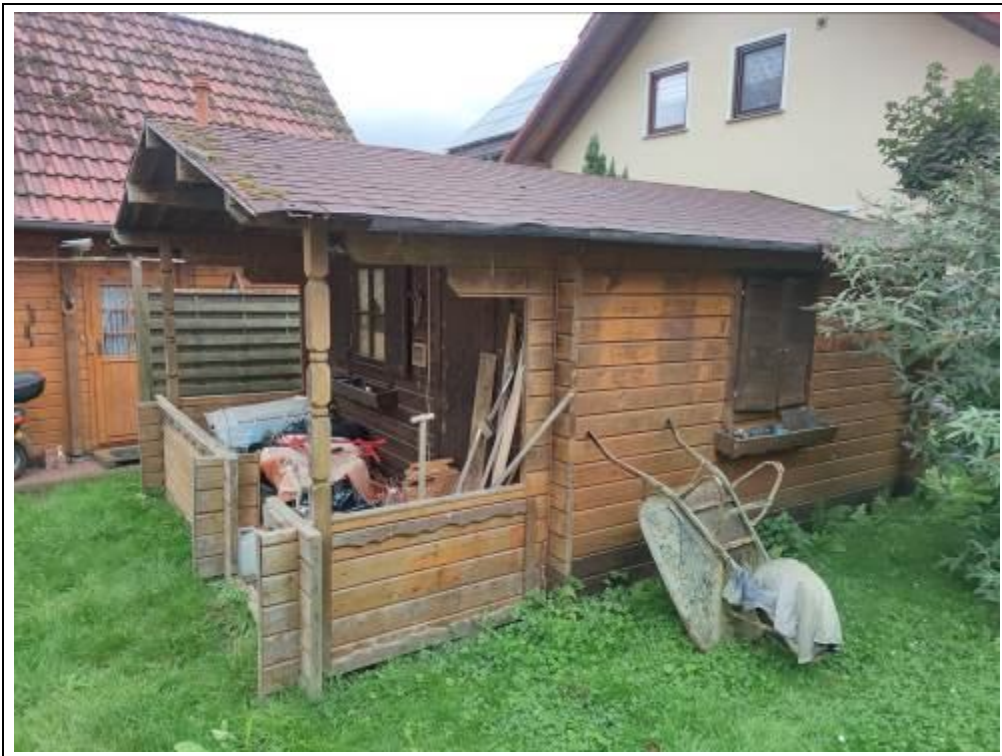
Blick auf das Gartenhaus von Nordosten
