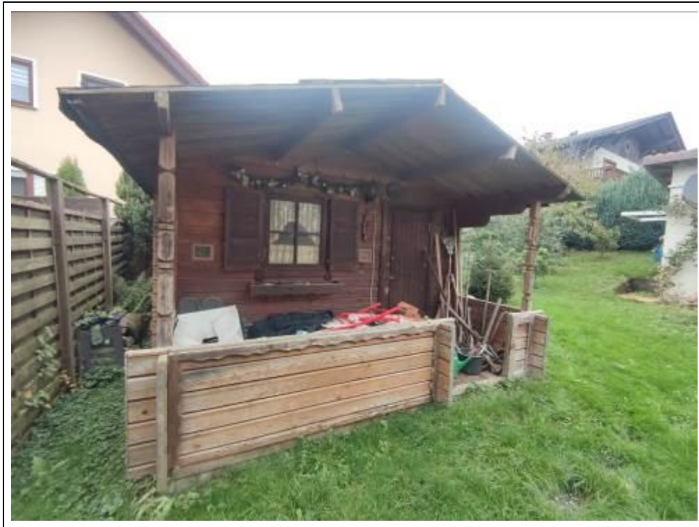
Blick auf das Gartenhaus von Süden
