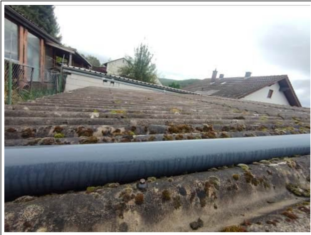
Blick auf die Dacheindeckung der Garage
