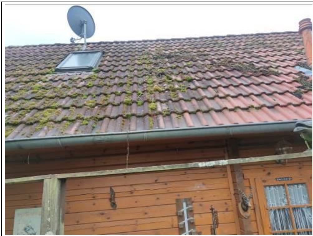
Blick auf die Dacheindeckung des Hauses
