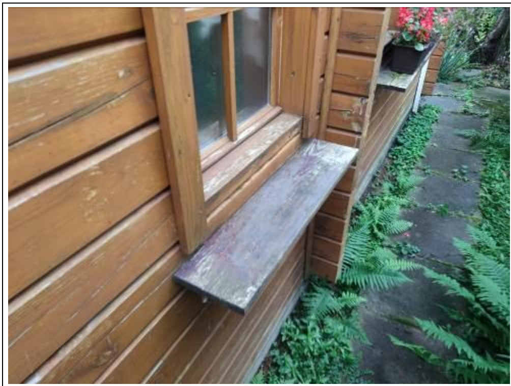
Blick auf den Zustand der Außenfassade
