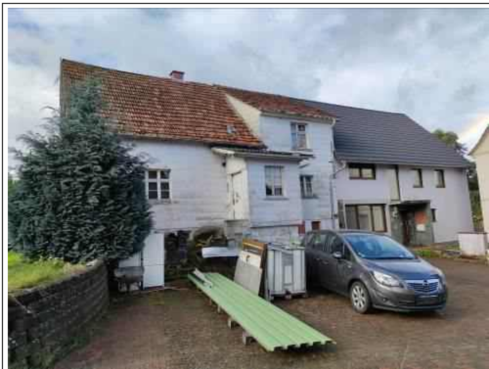
Blick auf das Bewertungsobjekt von Nordosten
