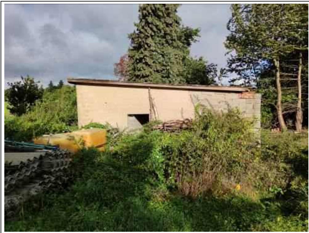
Blick auf die Reste des abgebrochenen Hühnerstall von Südosten
