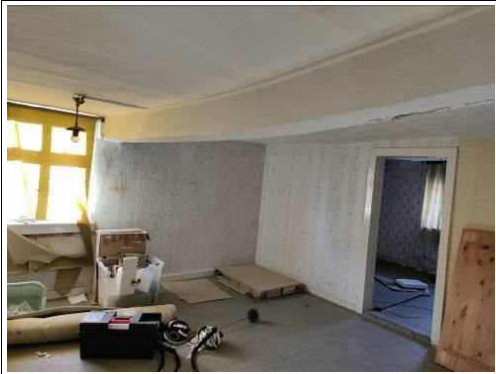
Blick in ein Zimmer im Erdgeschoss des Altbaus
