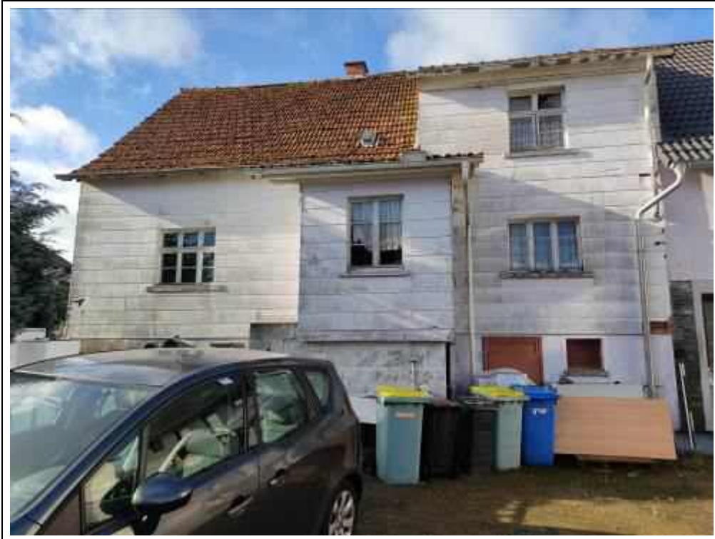
Blick auf das Bewertungsobjekt von Nordosten (Teilansicht Altbau)
