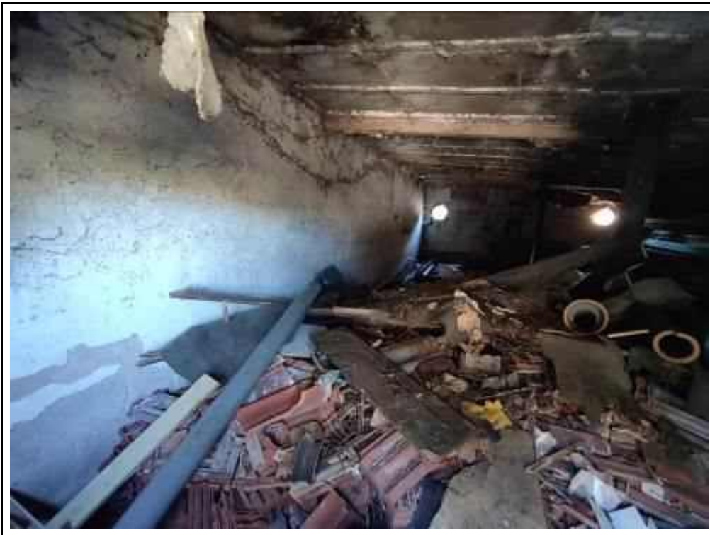
Blick in das Erdgeschoss des Hühnerstalls
