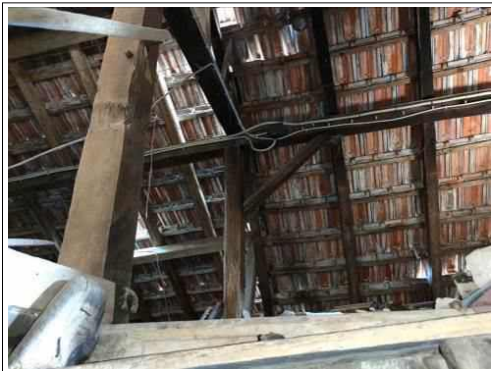
Blick in das Dachgeschoss des Altbaus
