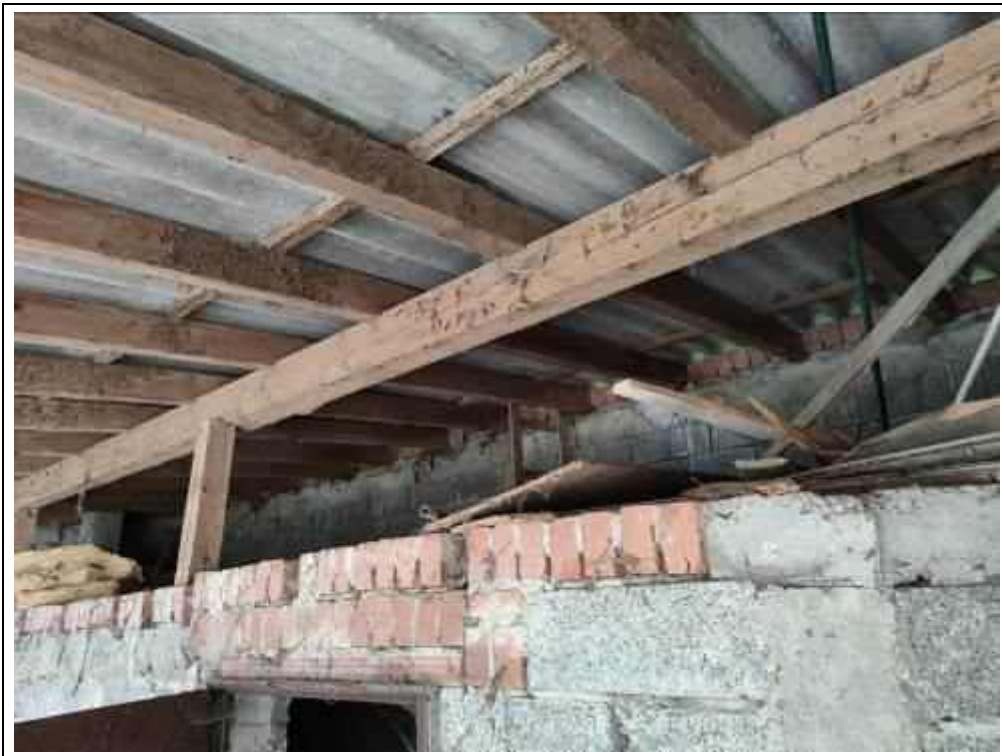
Blick gegen die alte Dachkonstruktion
