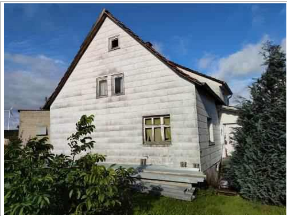
Blick auf das Bewertungsobjekt von Osten (Altbau)
