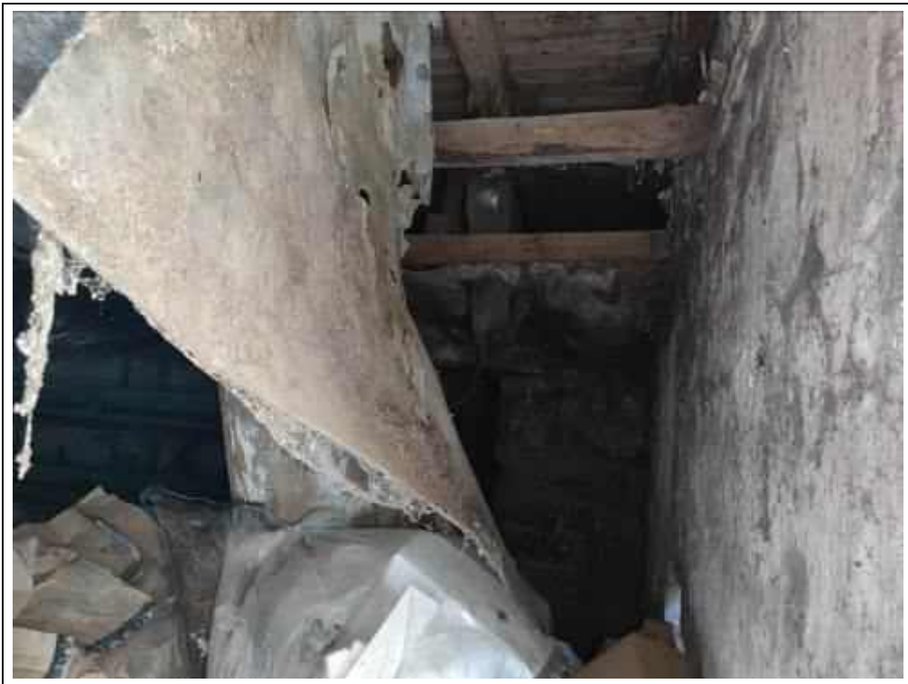
Blick in das Erdgeschoss des Hühnerstalls
