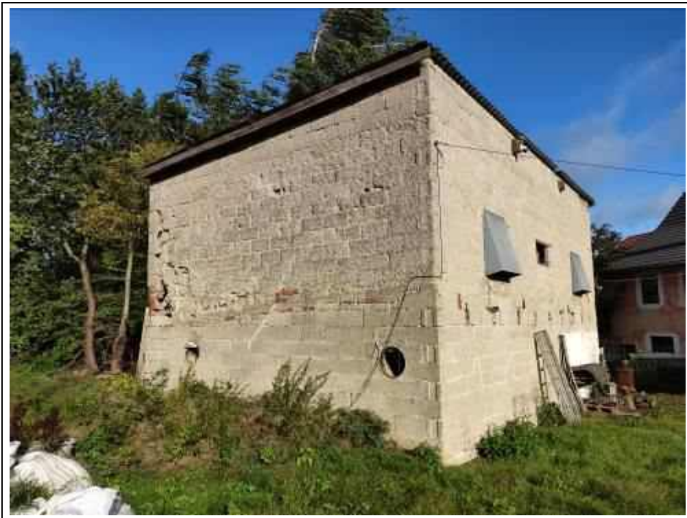
Blick auf den ehemaligen Hühnerstall von Südosten
