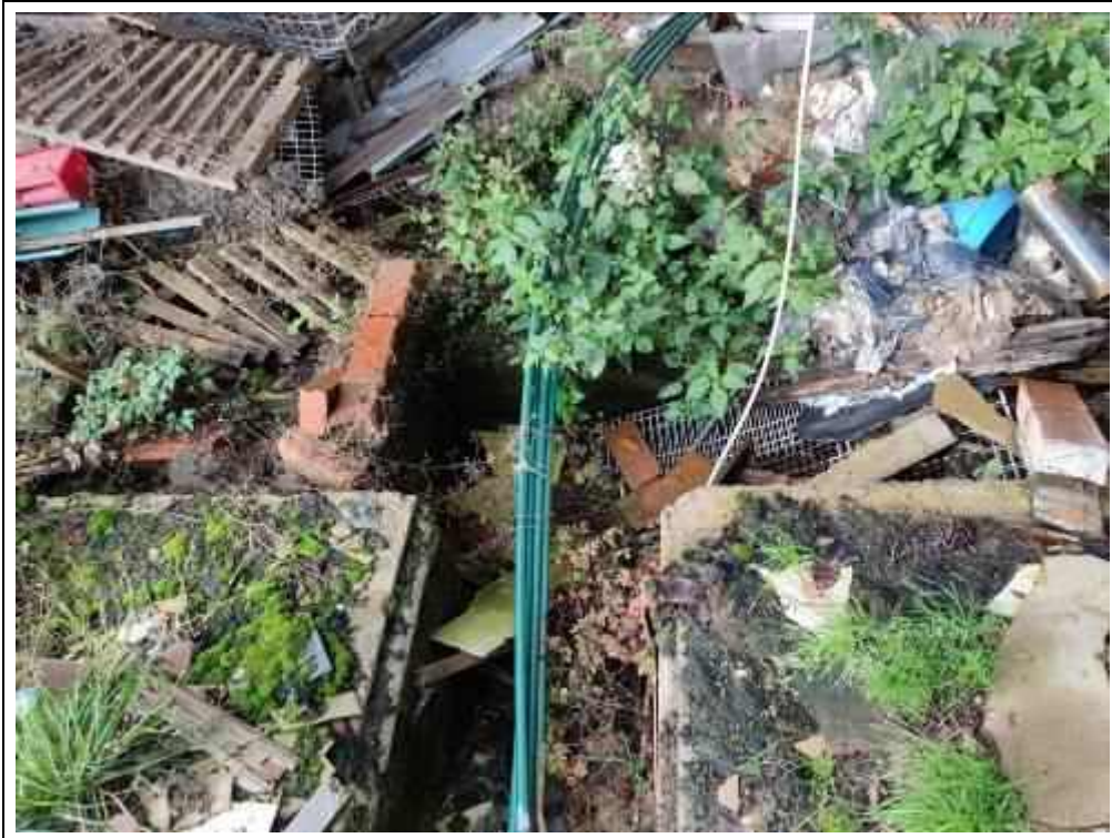
Blick auf Reste der Bodenplatte und Bodenkanäle)
