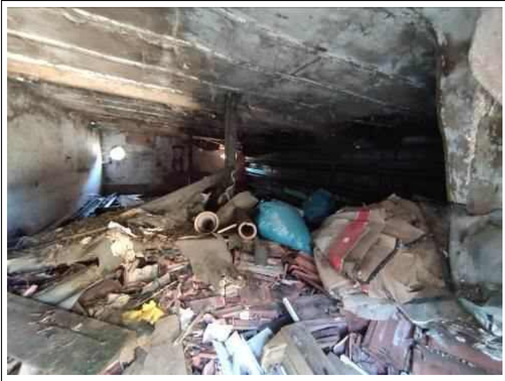
Blick in das Erdgeschoss des Hühnerstalls
