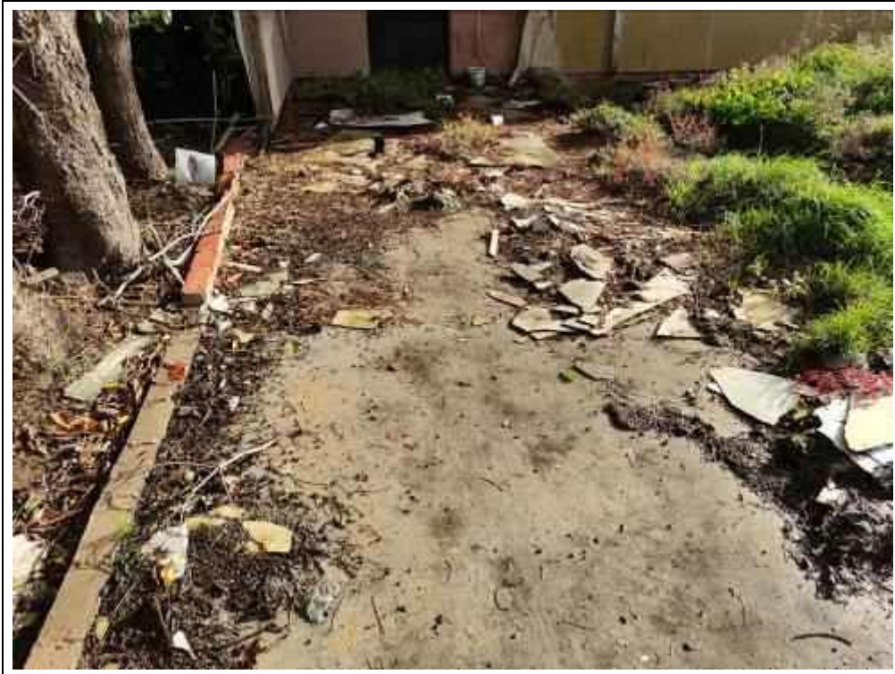
Blick auf Reste der alten Bodenplatte
