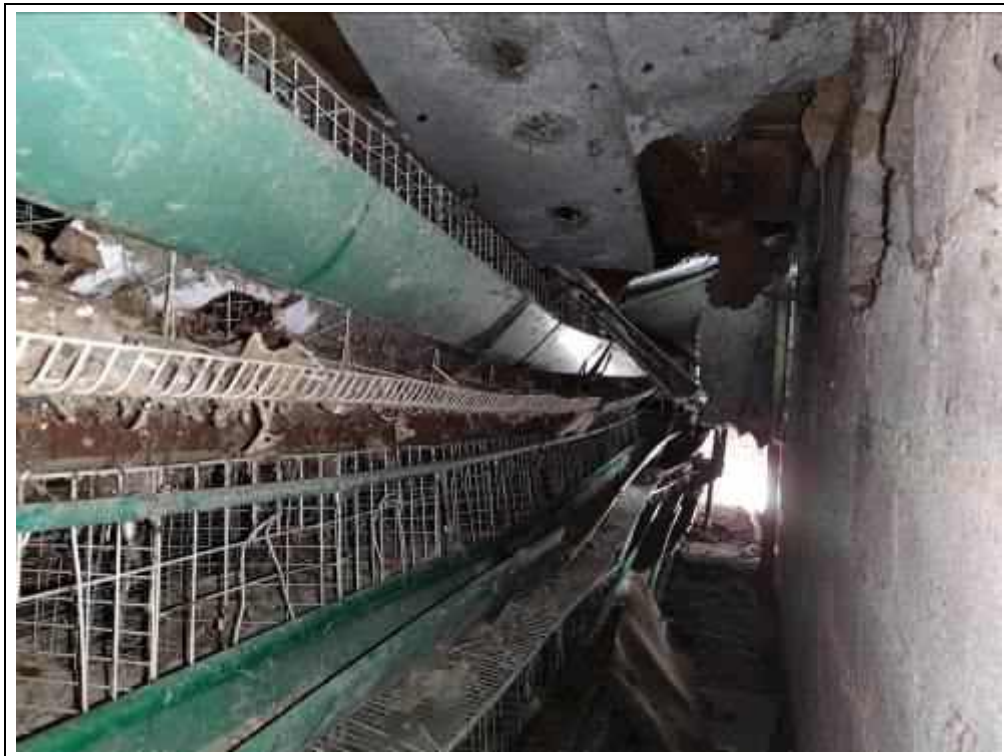
Blick in das Obergeschoss des Hühnerstalls
