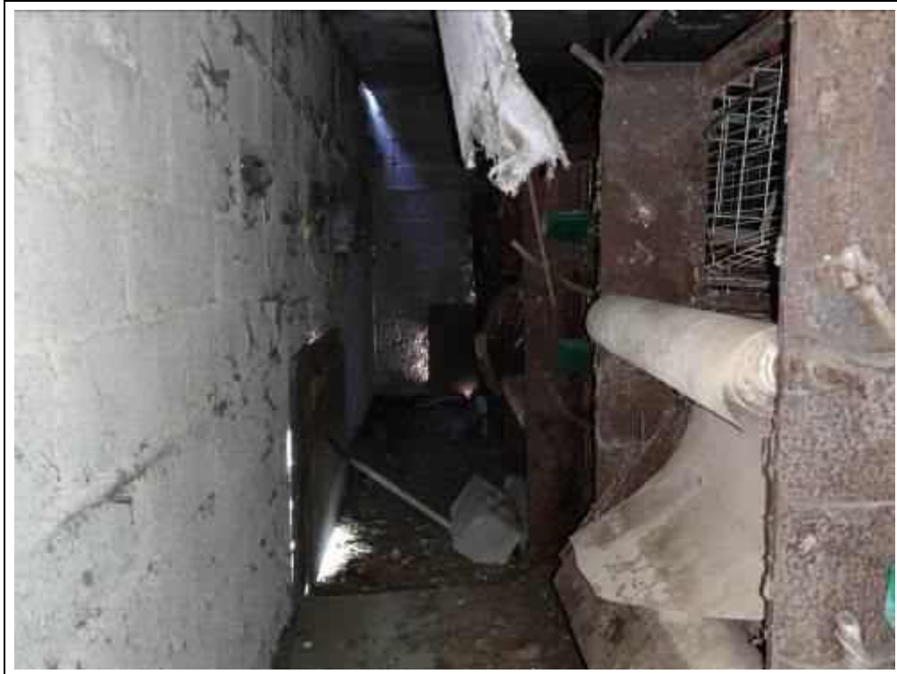
Blick in das Obergeschoss des Hühnerstalls
