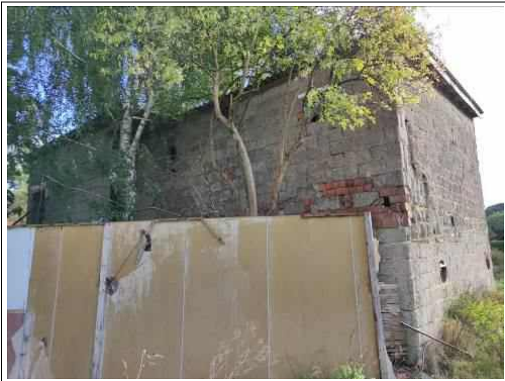
Blick auf den ehemaligen Hühnerstall von Südwesten
