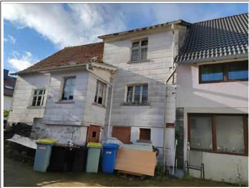
Blick auf das Bewertungsobjekt von Norden (Teilansicht Altbau)
