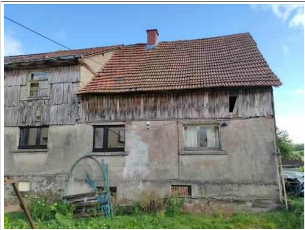
Blick auf das Bewertungsobjekt von Südwesten (Teilansicht Altbau)
