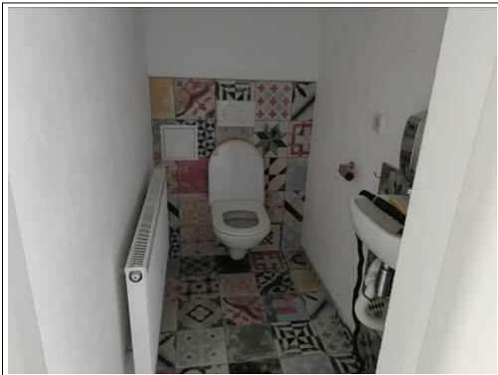
Blick in das WC im Erdgeschoss
