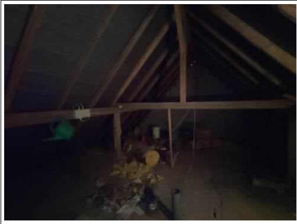
Blick in das Dachgeschoss
