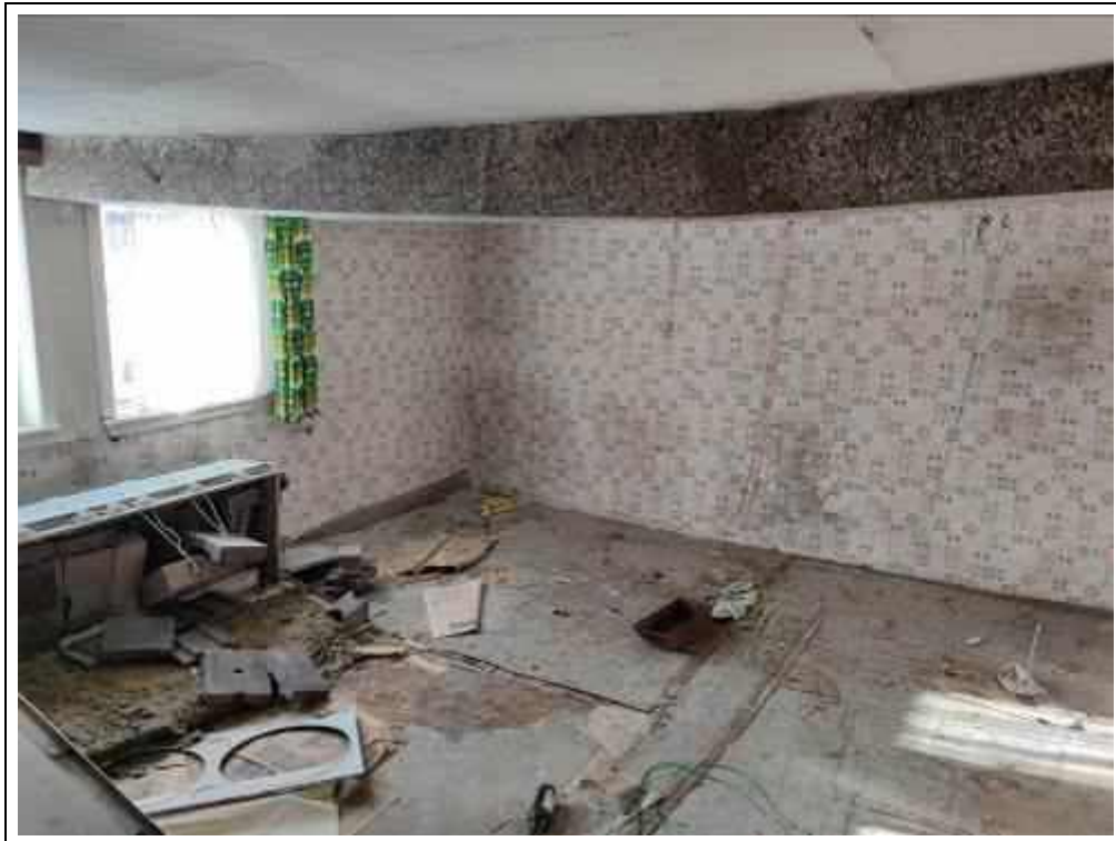
Blick in ein Zimmer im Dachgeschoss des Altbaus
