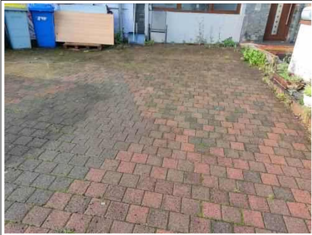
Blick in den gepflasterten Hofbereich
