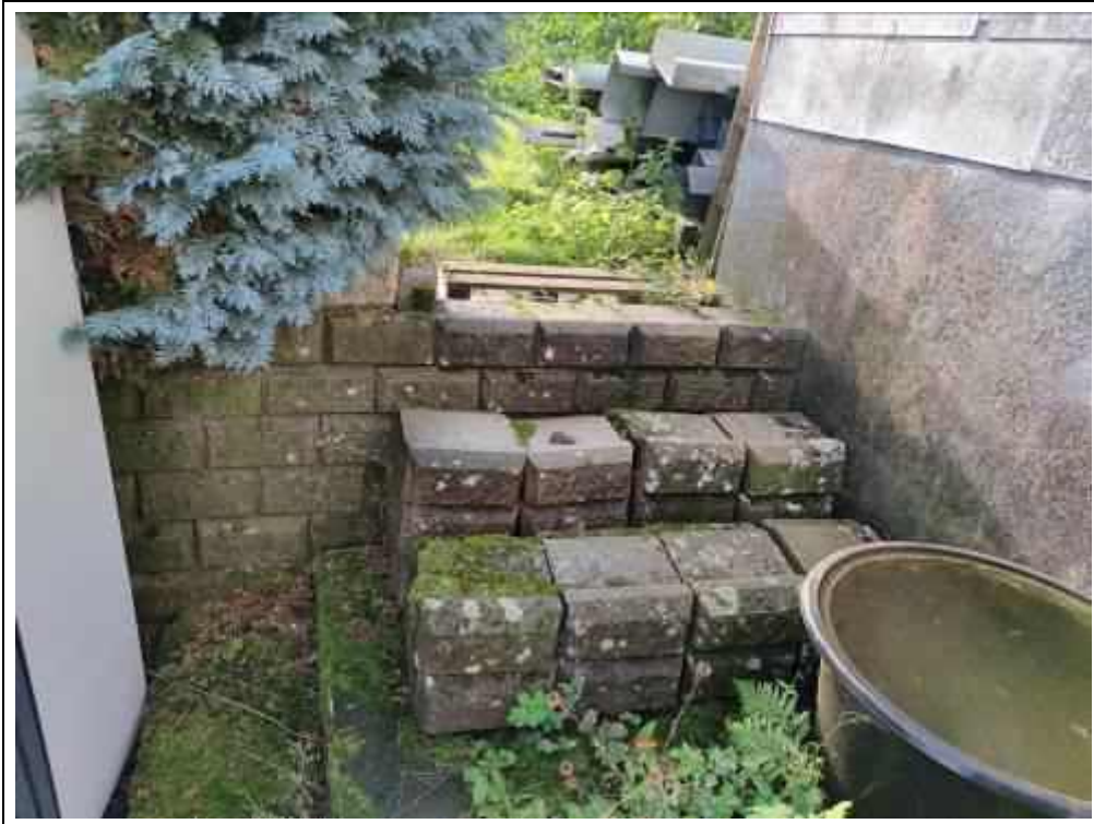
Blick auf eine Nottreppe im Außenbereich des alten Wohnhauses
