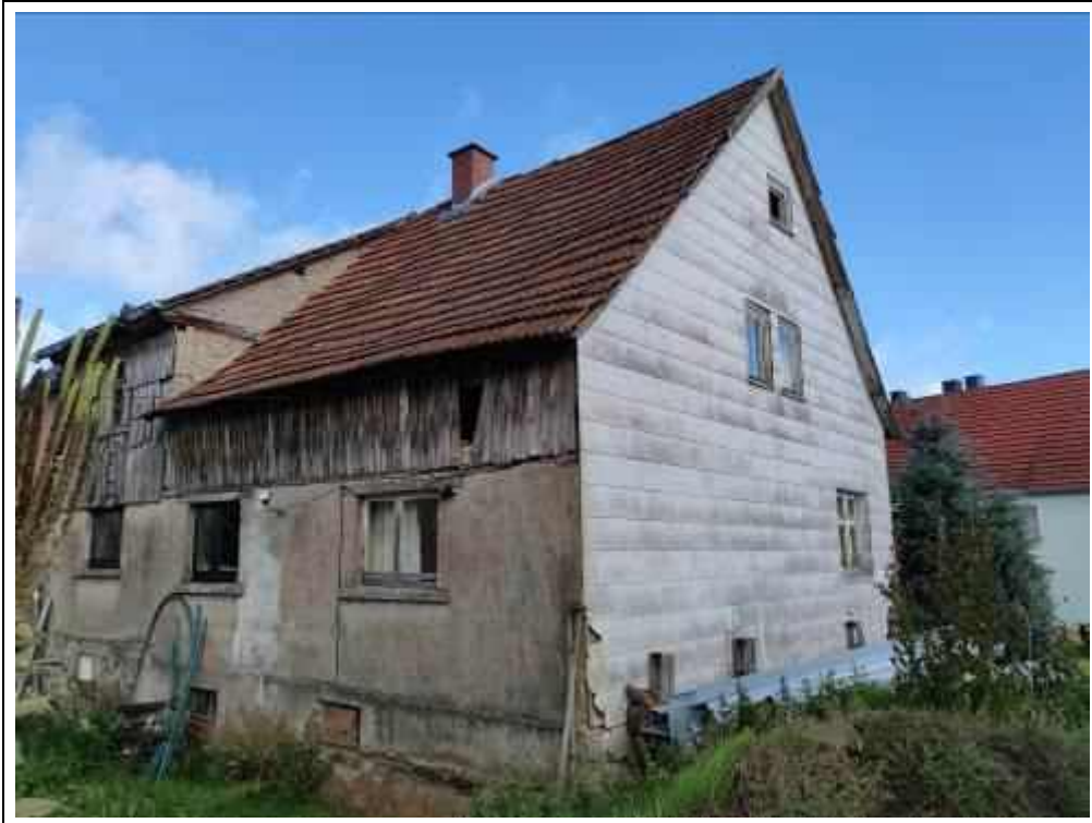
Blick auf das Bewertungsobjekt von Südosten (Teilansicht Altbau)
