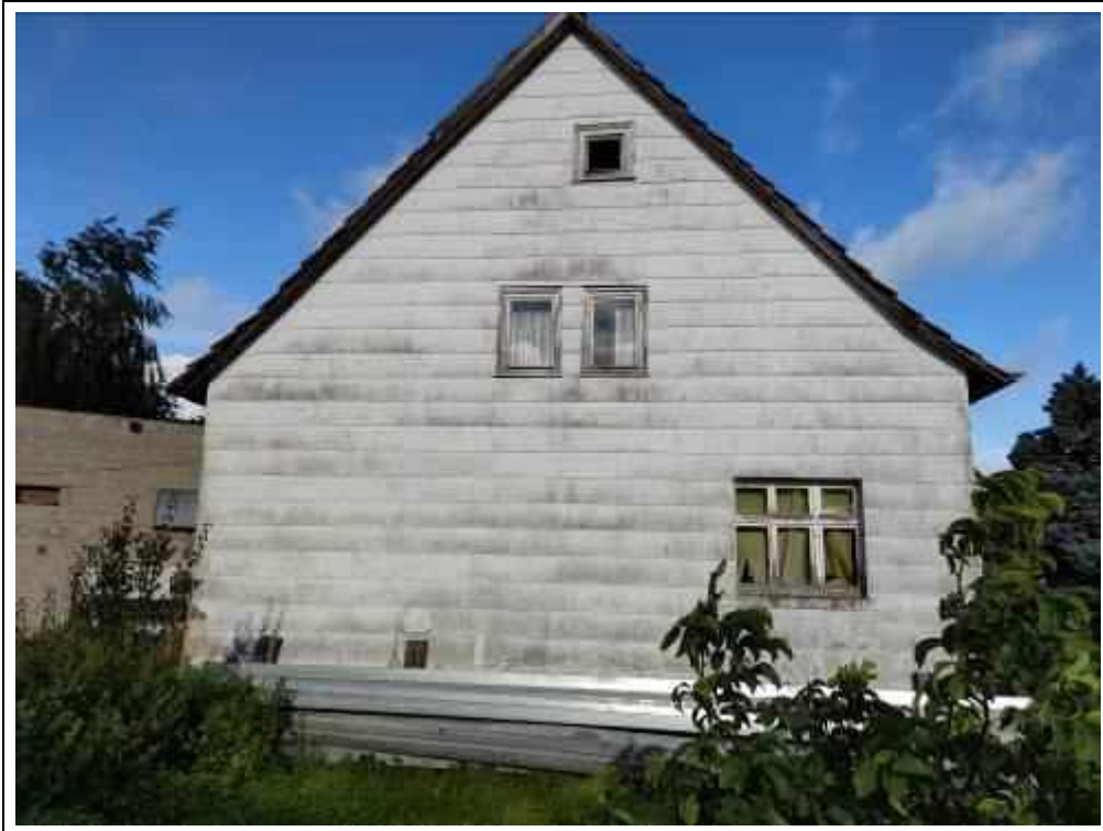
Blick auf das Bewertungsobjekt von Osten (Altbau)
