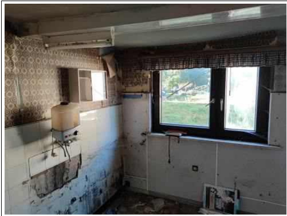
Blick in die ehemalige Küche des Altbaus
