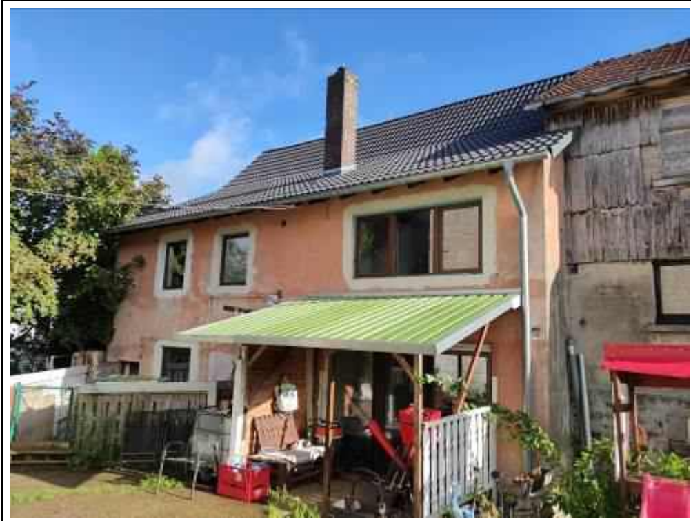
Blick auf das Bewertungsobjekt von Süden (Teilansicht Neubau)
