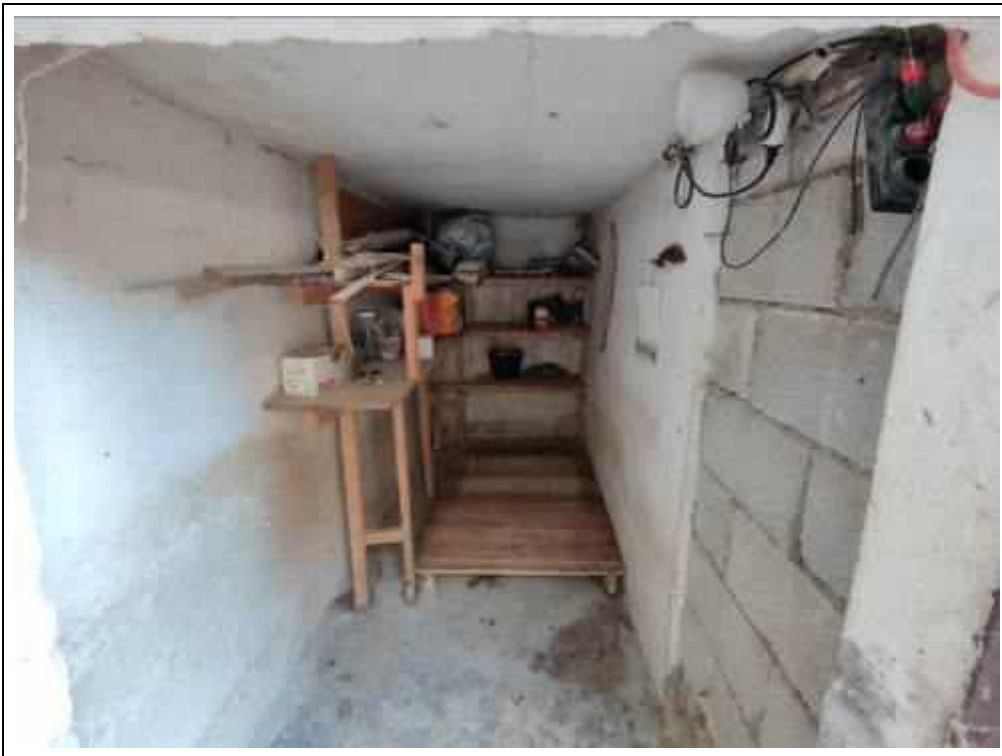
Blick in einen von außen zugänglichen Abstellraum
