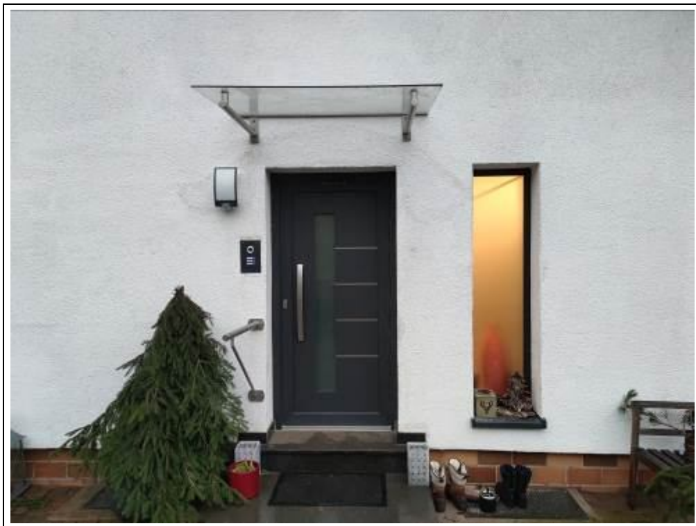
Blick auf den Hauseingang mit Überdachung
