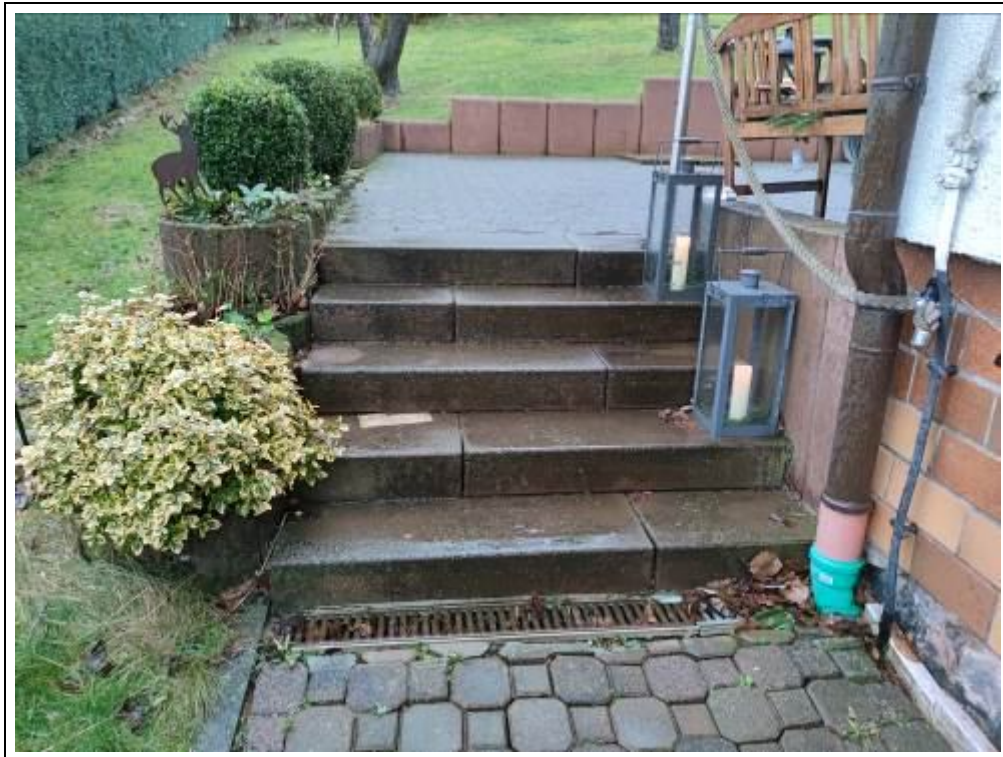
Blick auf den Zugang zum Hauseingang
