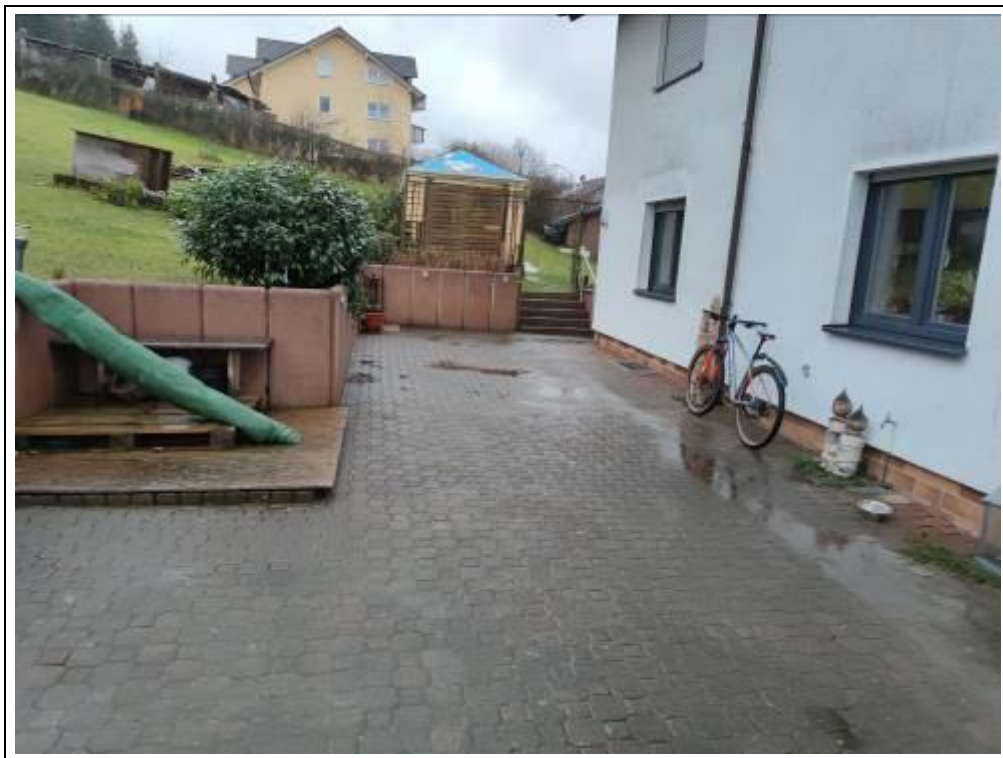
Blick auf den Terrassenbereich vor dem Hauseingang im Erdgeschoss
