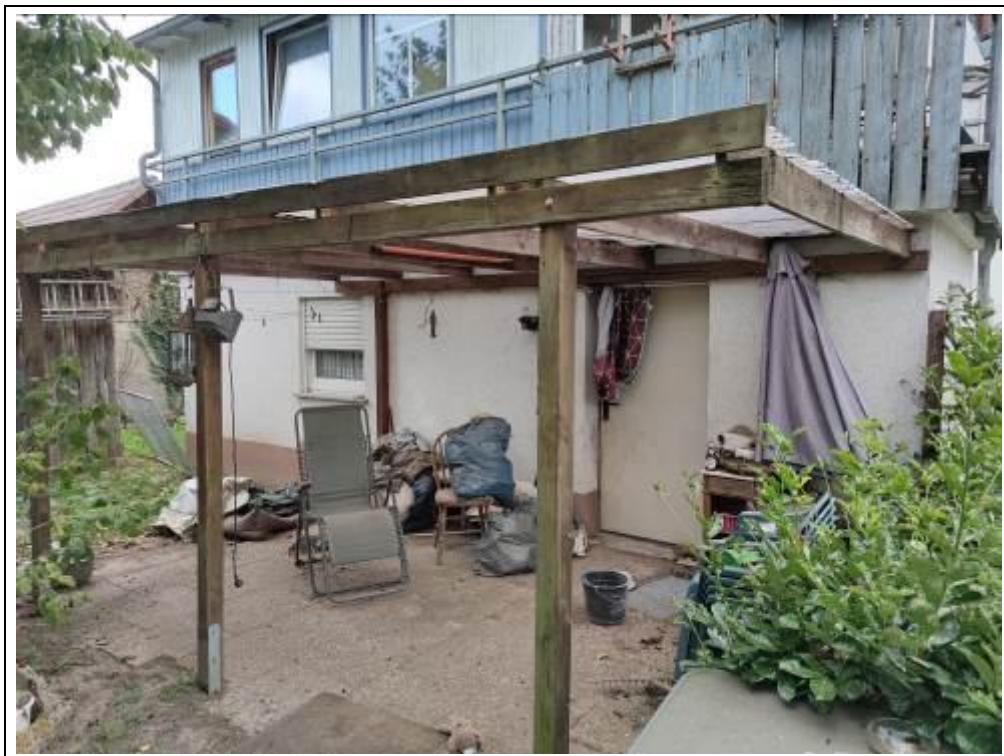
Blick auf die Terrassenüberdachung
