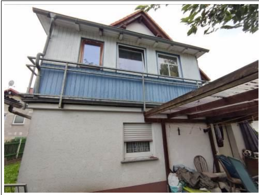
Blick auf das Bewertungsobjekt von Norden
