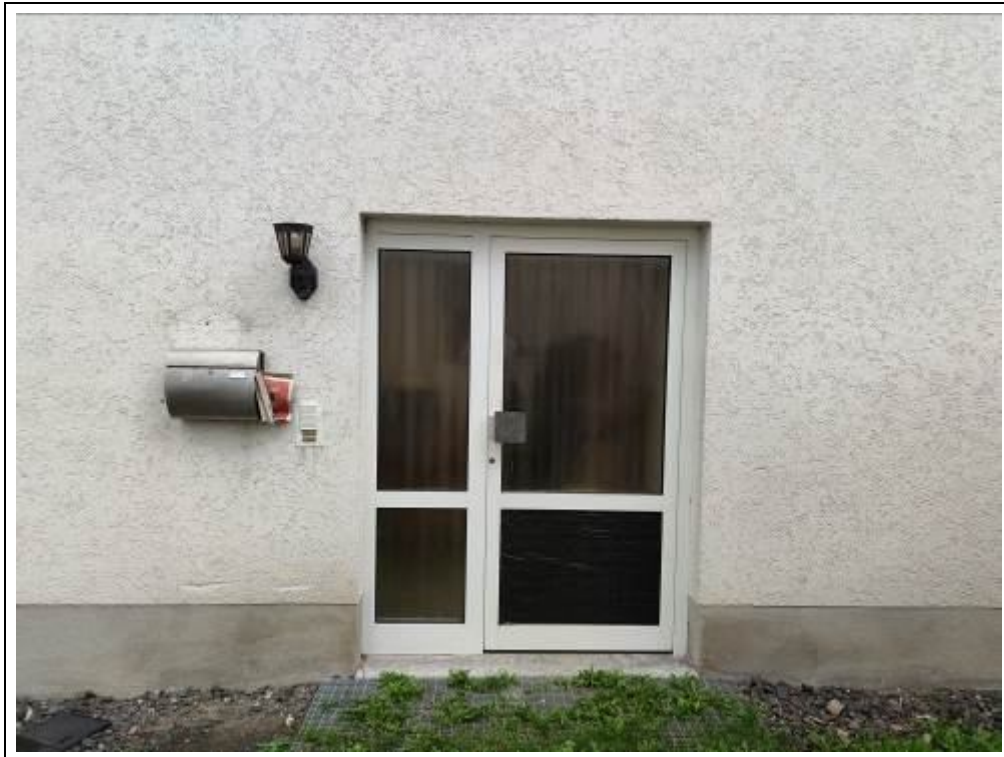
Blick auf den Hauseingang
