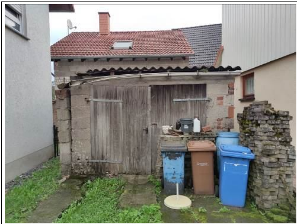
Blick auf die Garage von Westen
