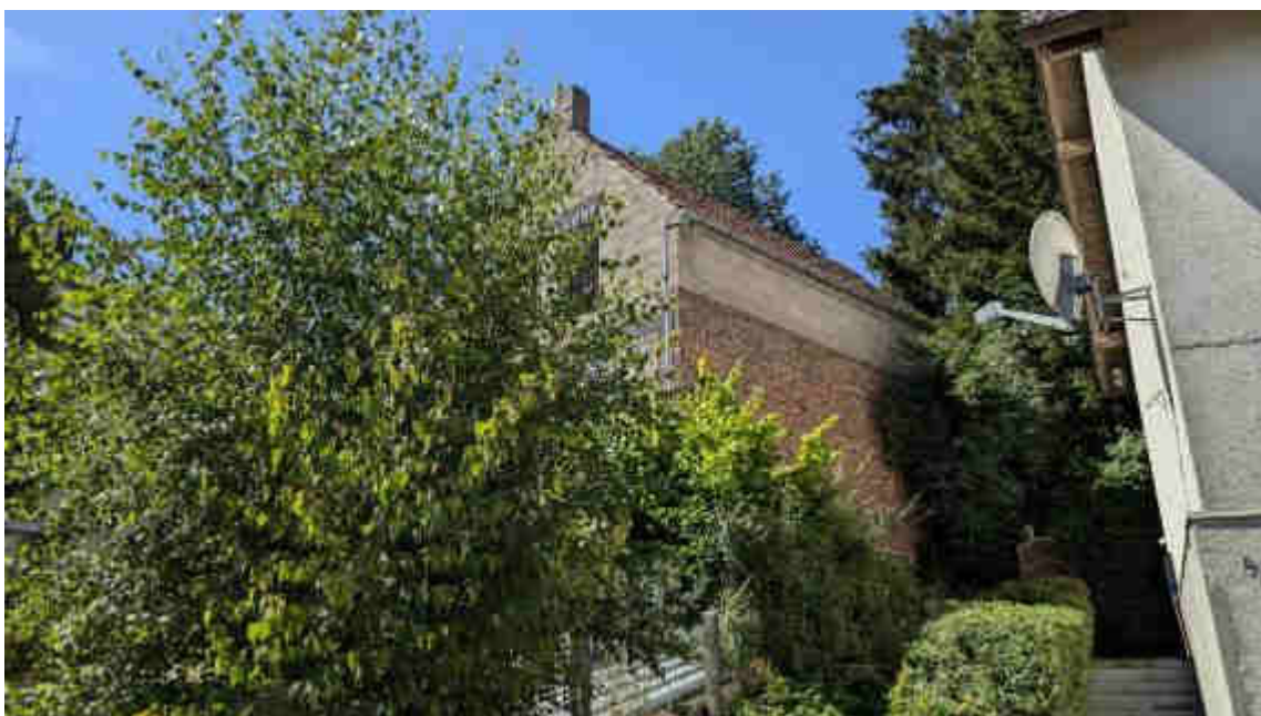
Bild B6 Nebengebäude
