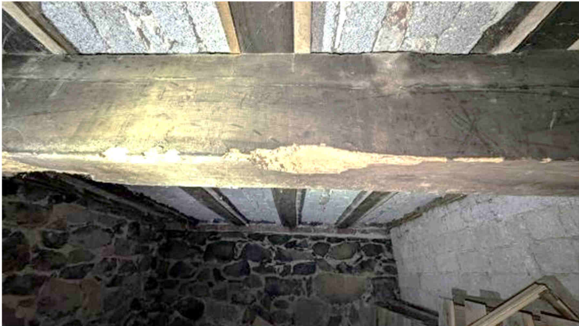
Bild D15 Beispiel Unterhaltungsbesonderheiten Nebengebäude
