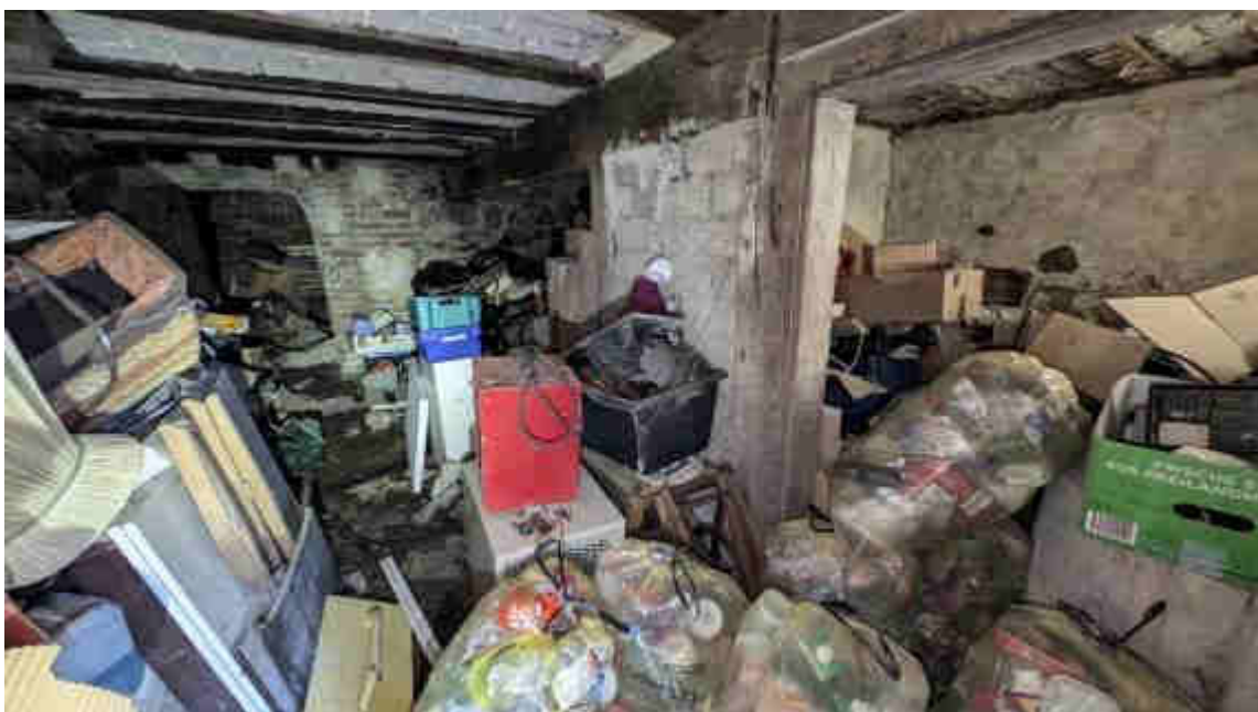
Bild D14 Beispiel Unterhaltungsbesonderheiten Nebengebäude
