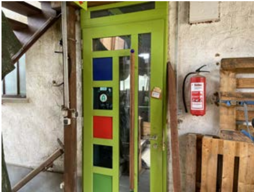
B9: Eingangsbereich Werkstatt
