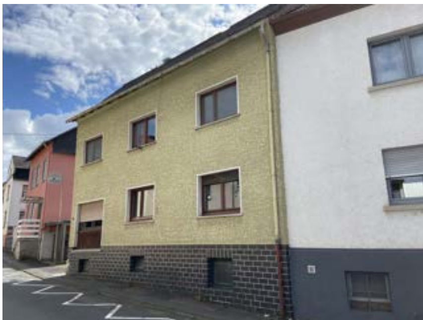
B2: exemplarische Außenansicht Wohnhaus
