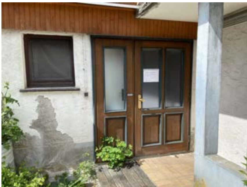
B8: Eingangsbereich Wohnhaus
