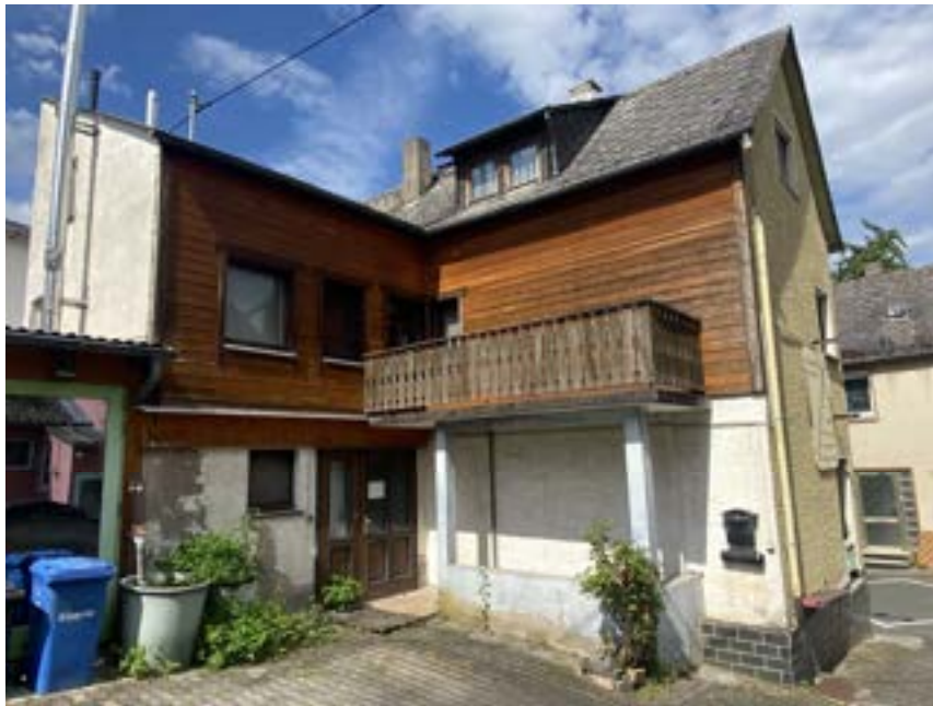
B3: exemplarische Außenansicht Wohnhaus
