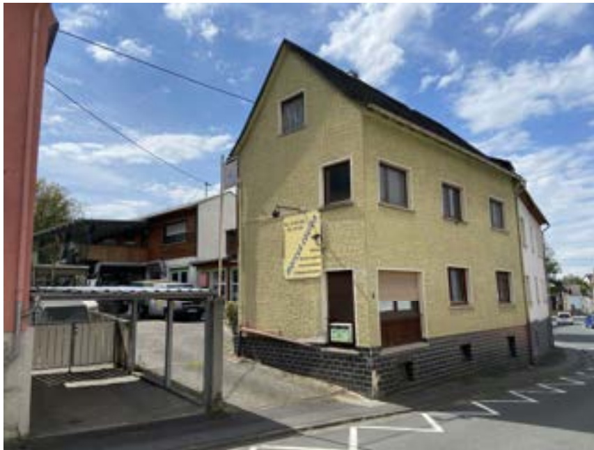
B1: exemplarische Außenansicht Wohnhaus
