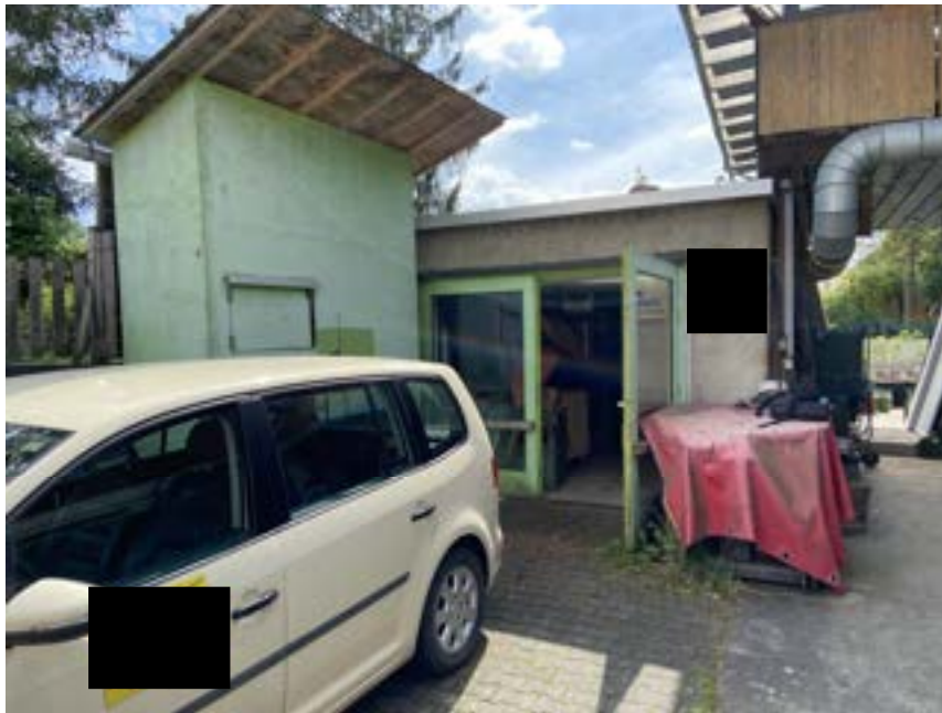
B7: exemplarische Außenansicht Garage
