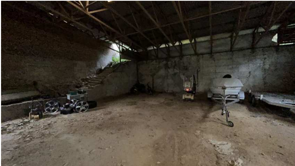
C5 - exemplarische Innenansicht Scheune
