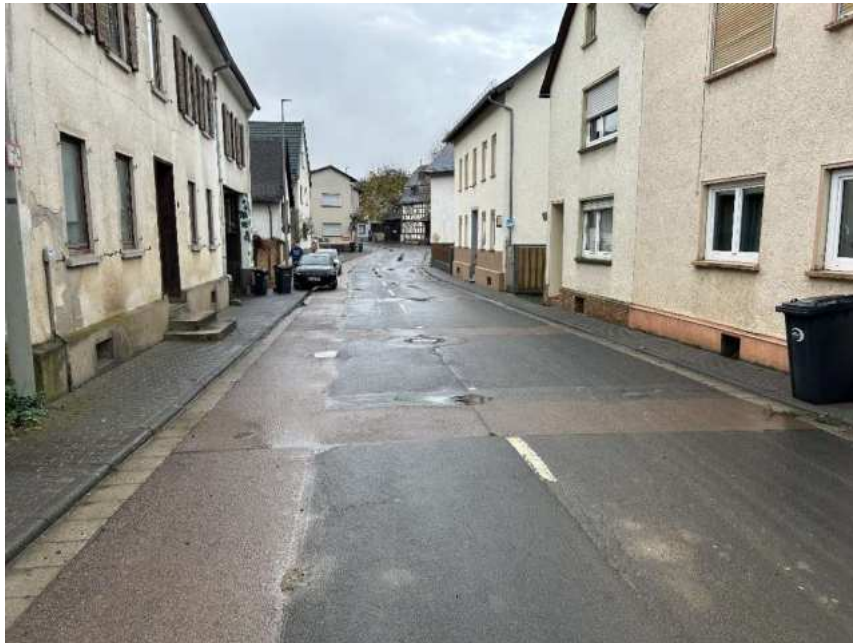
A1 - Blick in die Erschließungsstraße
