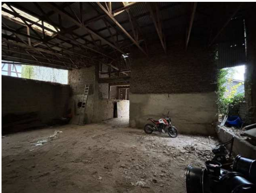
C6 - exemplarische Innenansicht Scheune
