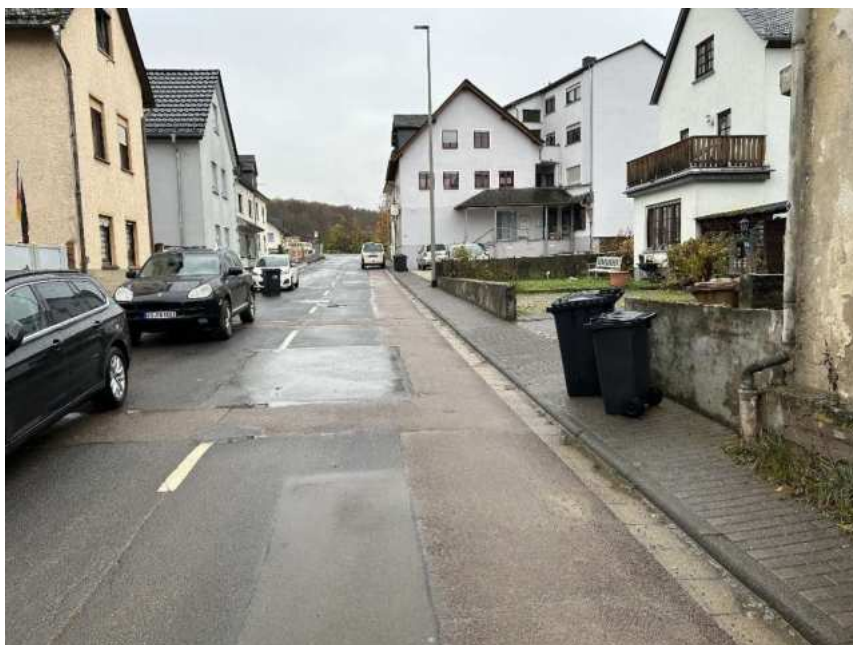
A2 - Blick in die Erschließungsstraße
