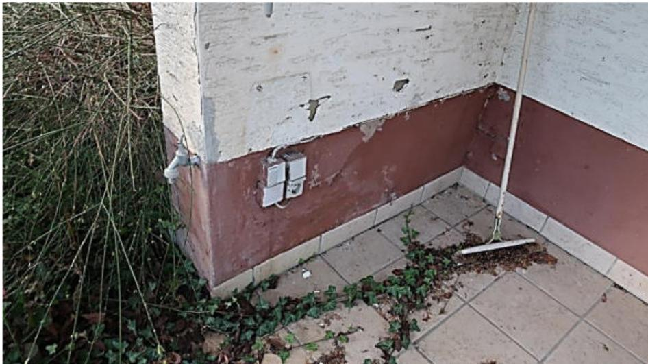
Haussockelbereich rückseits partiell mit Putz-/Feuchteschäden
