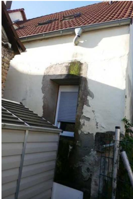
Bild 13: Fenster in Brandwand zu Kirchstr. 4 (Rückbau verfügt)
