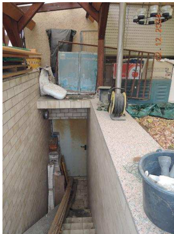
Abb. 22: Zugang zum gartenseitigen Kellerraum
