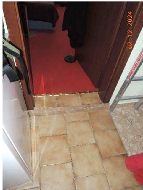
Abb. 15: Detailaufnahme im Dachgeschoss
