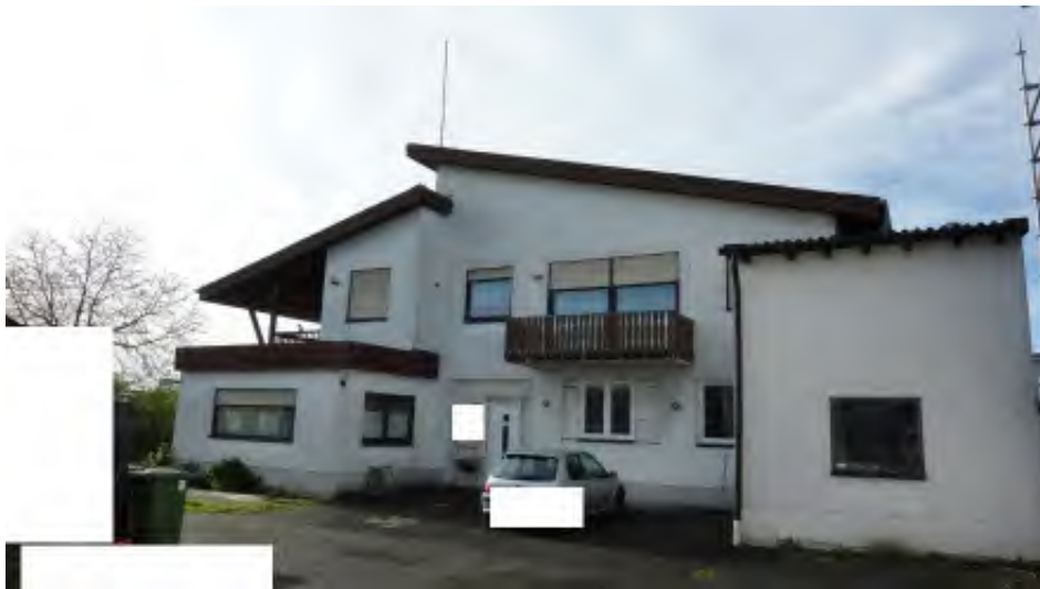
Gesamtansicht / Fassade mit tlw. zugemauerten urspr. Öffnungen im EG
