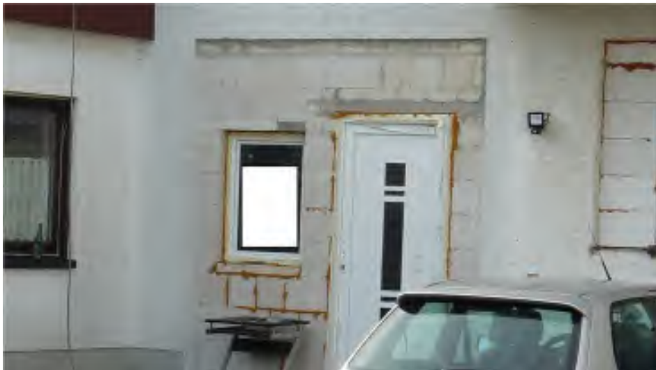
zugemauerte urspr. Öffnungen im EG
