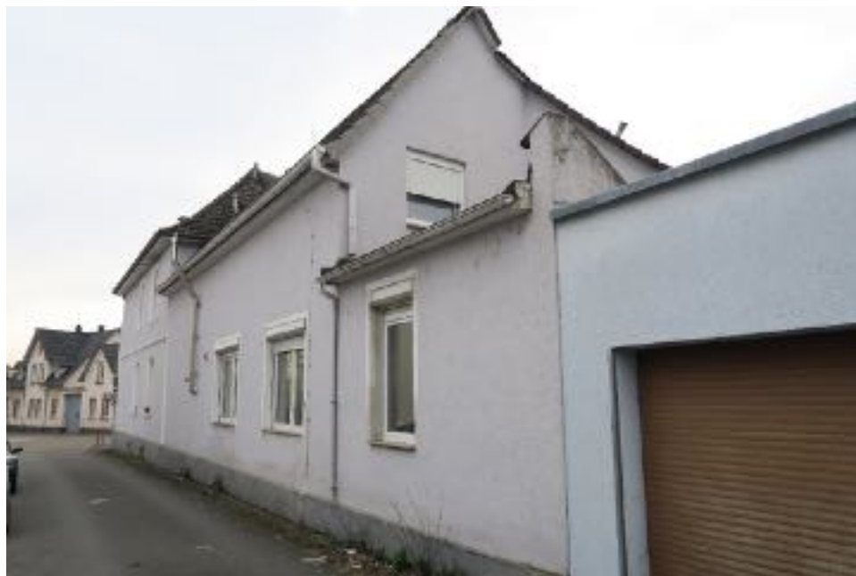
Bild 9: Straßenansicht der Gesamtanlage
