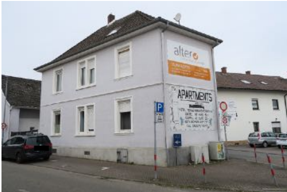
Bild 1: Straßenansicht der Gesamtanlage
