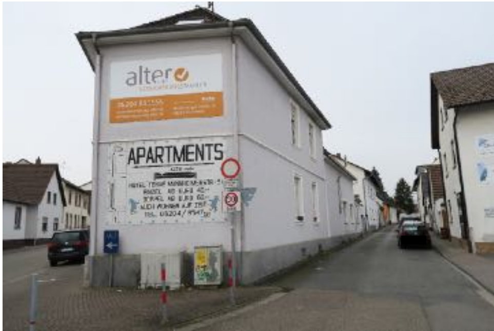
Bild 7: Straßenansicht der Gesamtanlage
