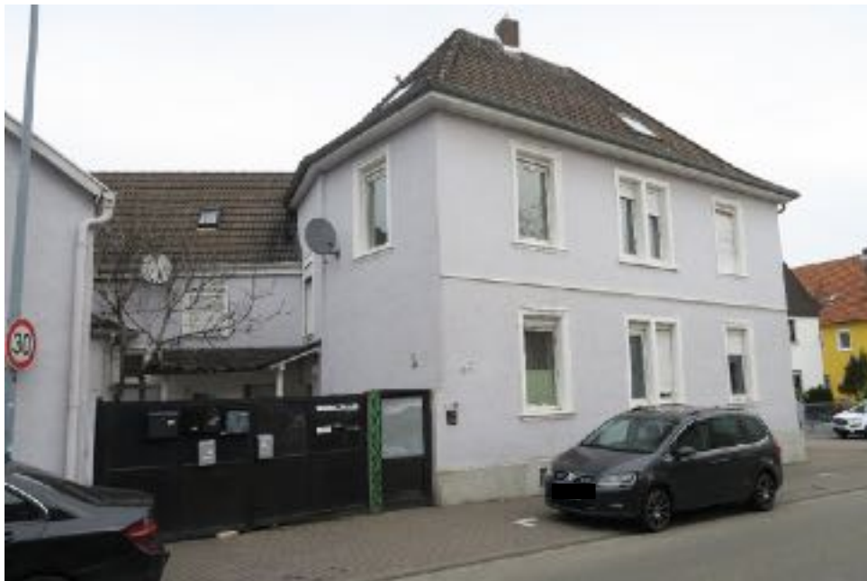
Bild 4: Straßenansicht der Gesamtanlage
