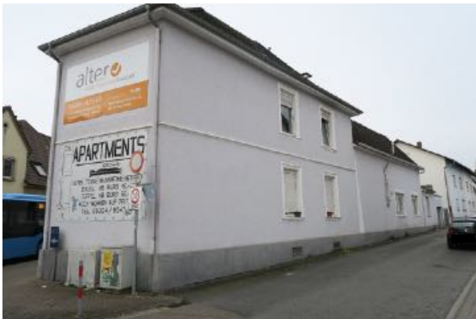
Bild 8: Straßenansicht der Gesamtanlage
