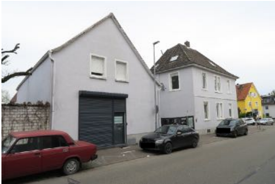
Bild 3: Straßenansicht der Gesamtanlage
