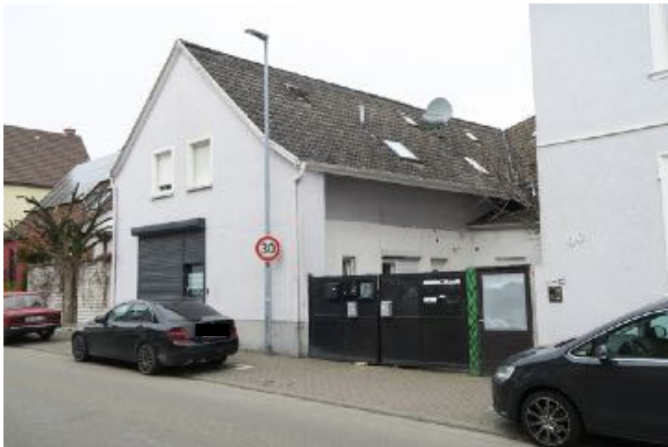
Bild 2: Straßenansicht der Gesamtanlage
