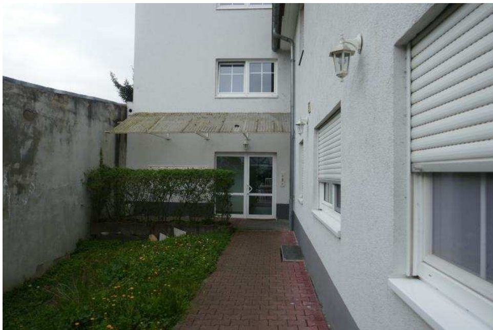
Bild 4: Treppenhaus (Zugang zum Bewertungsobjekt) mit Ansicht von Nordwesten
