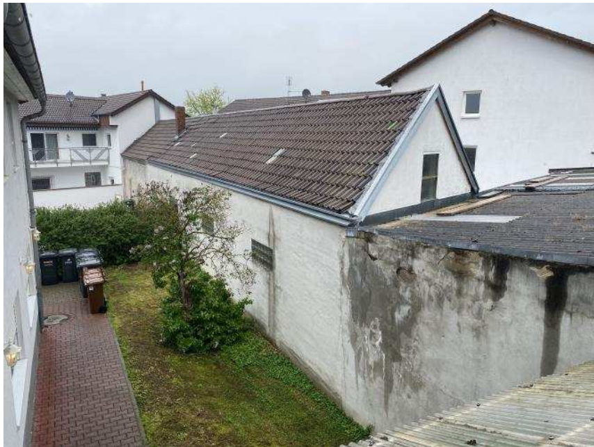
Bild 20: Grenzbebauung durch das Nachbargrundstück (Flurstück Nr. 364/1) im Rahmen einer bestehenden Grunddienstbarkeit
