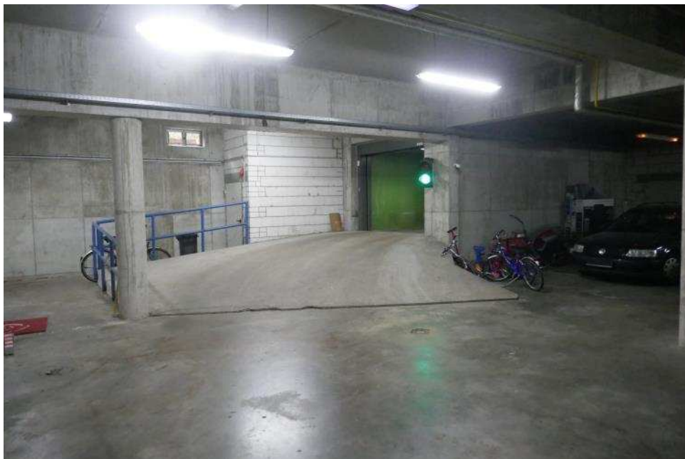
Bild 16: Zufahrt zum Autolift in der Tiefgarage des Gebäudekomplexes
