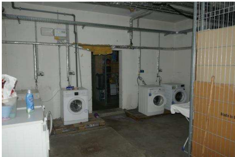
Bild 12: Waschraum (Gemeinschaftseigentum) im Kellergeschoss des Gebäudekomplexes
