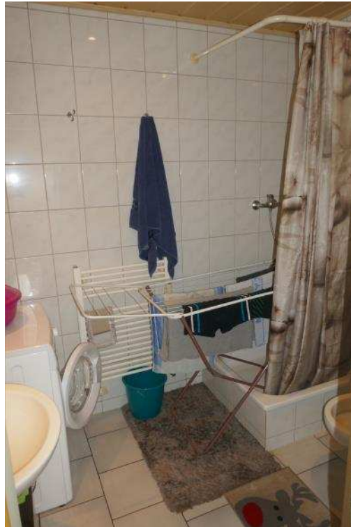
Bild 11: Innenliegendes Badezimmer im Wohnbereich 2 des Bewertungsobjektes
