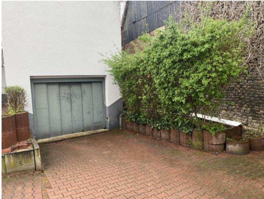
Bild 17: Zufahrt zum Autolift im Innenhof mit Ansicht von Westen
