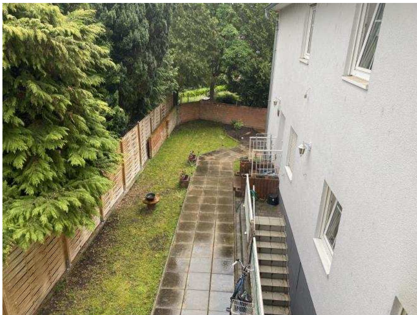
Bild 6: Innenhof auf der Gebäude-Ostseite mit Zugang zum Wohnbereich 1 des Bewertungsobjektes und Treppenabgang zum Kellerbereich
