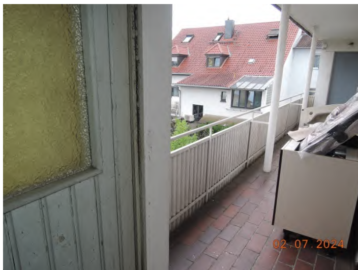
Bild 6: Zugang zum Laubengang (2. OG)
