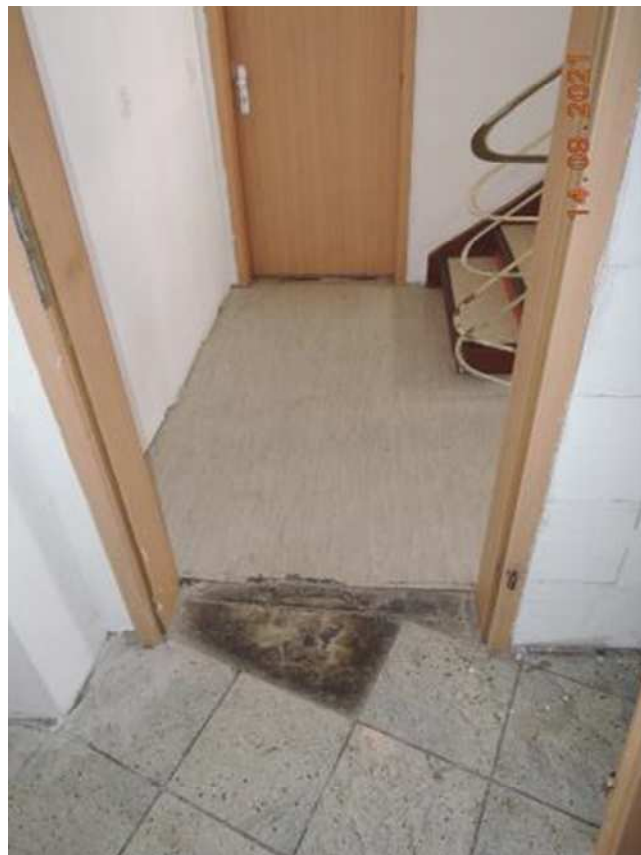
Bild 18: Treppenhaus zum Flur
