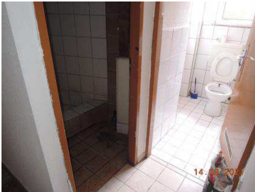
Bild 15: Duschbad im OG
