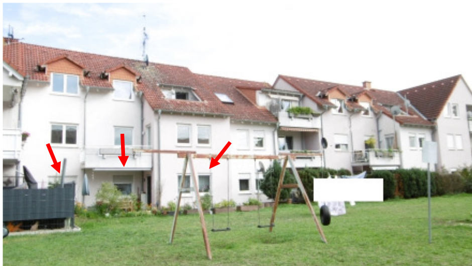
Ansicht Gesamtanlage (Rückseite)
