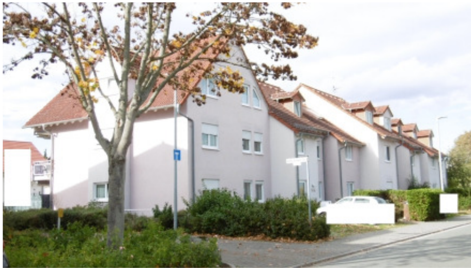
Ansicht Gesamtanlage (Straßenseite)
