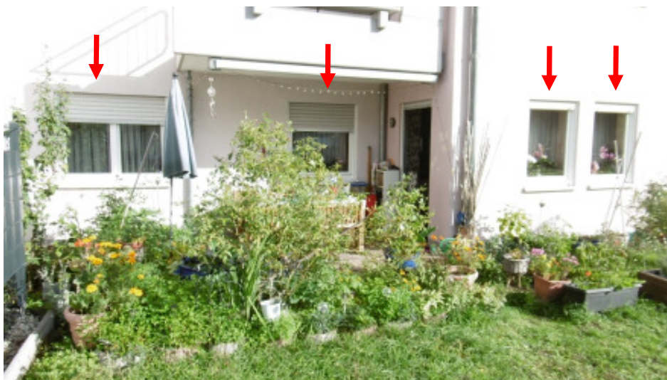
rückseitige Wohnungsansicht Nr. 8 im EG
